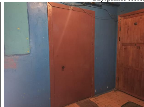
Фото 13. Вход в помещение
