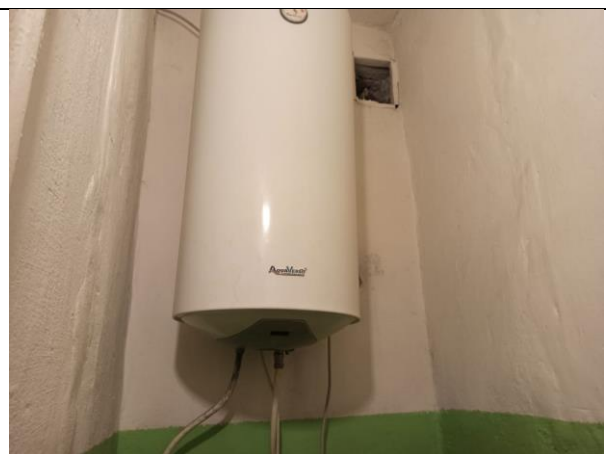
Фото 16. Внутреннее состояние Объекта оценки
