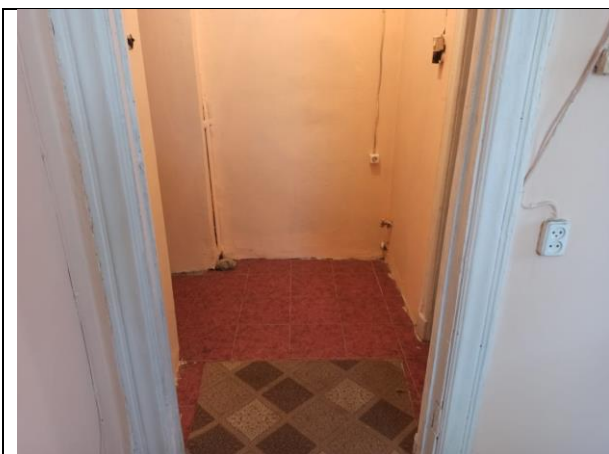
Фото 15. Внутреннее состояние Объекта оценки
