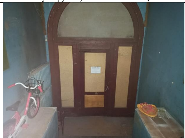
Фото 12. Общий вход с улицы (закрыт, не эксплуатируется) – вид изнутри
