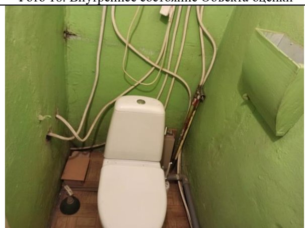
Фото 18. Внутреннее состояние Объекта оценки
