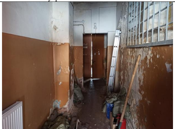
Фото 26. Внутреннее состояние Объекта оценки
