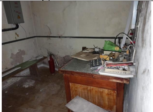
Фото 28. Внутреннее состояние Объекта оценки
