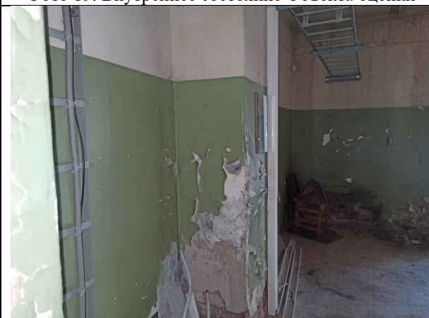
Фото 21. Внутреннее состояние Объекта оценки
