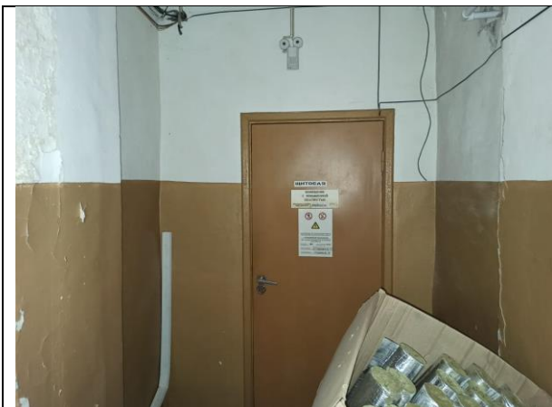
Фото 23. Внутреннее состояние Объекта оценки
