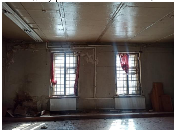
Фото 20. Внутреннее состояние Объекта оценки
