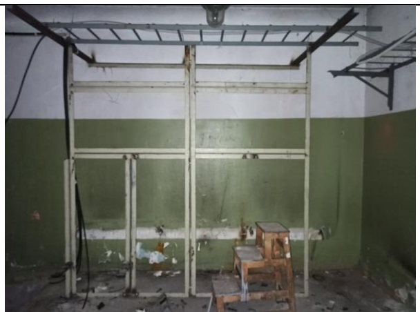
Фото 16. Внутреннее состояние Объекта оценки
