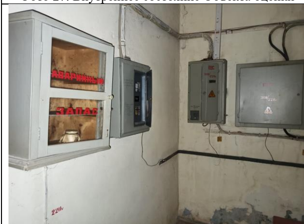
Фото 29. Внутреннее состояние Объекта оценки
