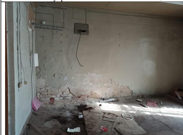
Фото 25. Внутреннее состояние Объекта оценки
