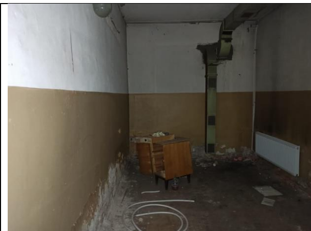
Фото 15. Внутреннее состояние Объекта оценки
