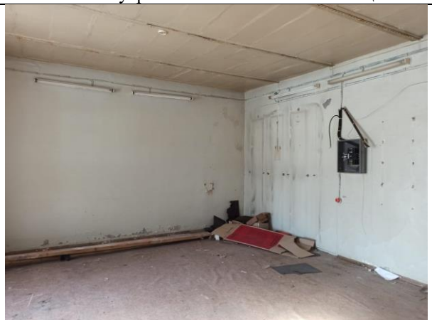
Фото 18. Внутреннее состояние Объекта оценки
