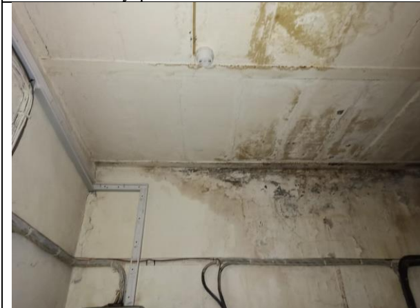
Фото 27. Внутреннее состояние Объекта оценки
