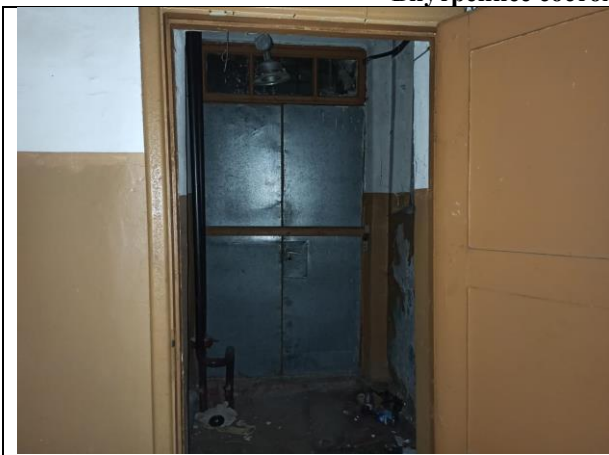
Фото 13. Внутреннее состояние Объекта оценки
