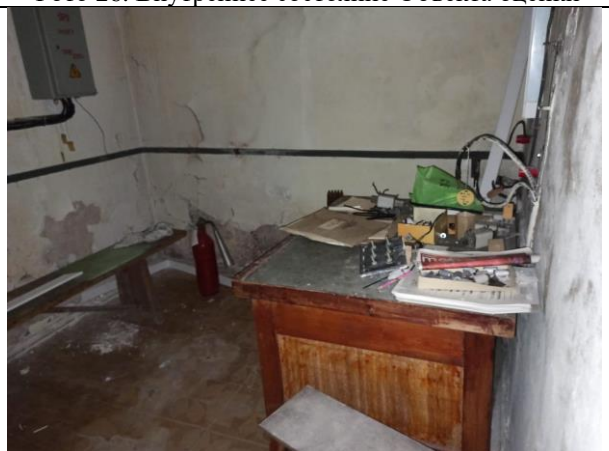
Фото 28. Внутреннее состояние Объекта оценки
