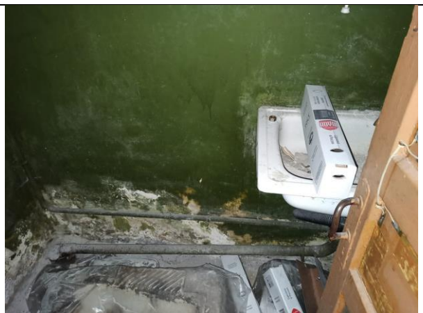
Фото 24. Внутреннее состояние Объекта оценки
