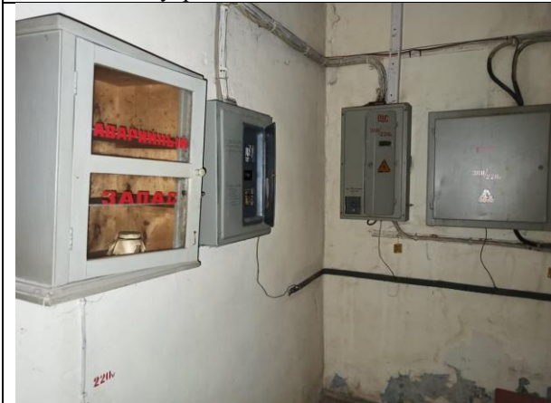
Фото 29. Внутреннее состояние Объекта оценки
