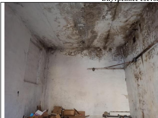
Фото 7. Внутреннее состояние Объекта оценки
