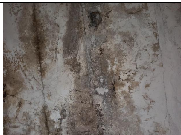
Фото 12. Внутреннее состояние Объекта оценки
