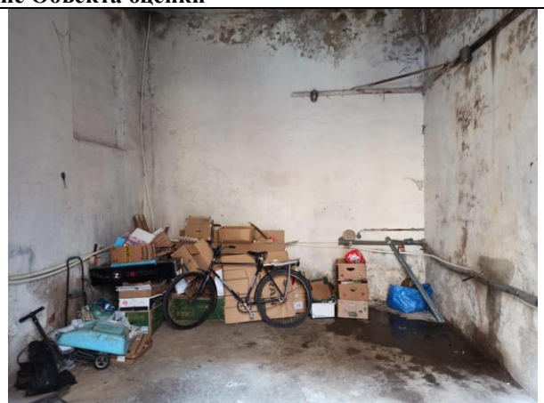
Фото 8. Внутреннее состояние Объекта оценки
