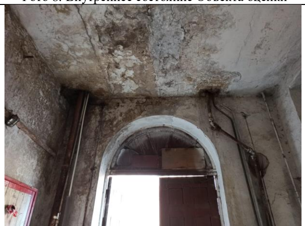
Фото 10. Внутреннее состояние Объекта оценки
