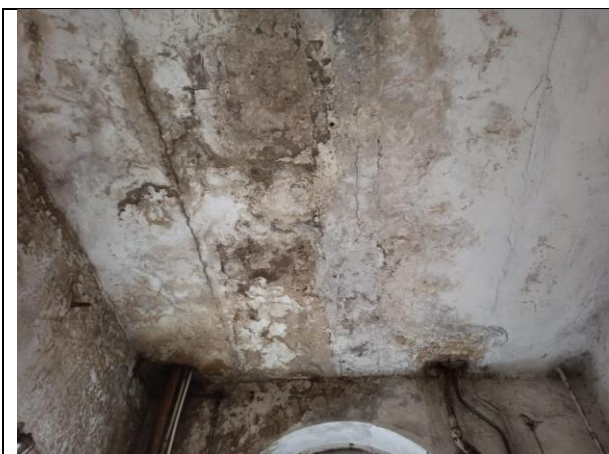
Фото 11. Внутреннее состояние Объекта оценки
