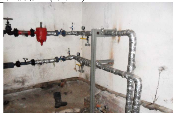
Фото 12. Внутреннее состояние Объекта оценки
