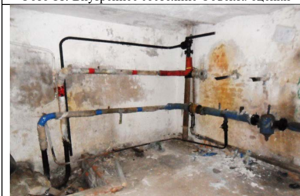
Фото 13. Внутреннее состояние Объекта оценки
