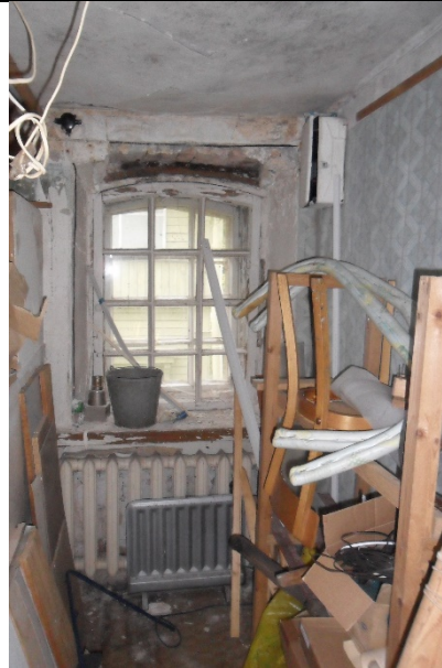
Фото 16. Внутреннее состояние Объекта оценки
