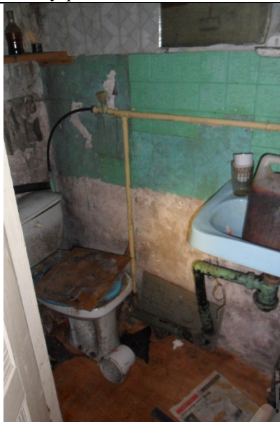
Фото 20. Внутреннее состояние Объекта оценки
