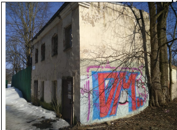
Фото 1. Вид здания, в котором расположен Объект оценки, со двора
