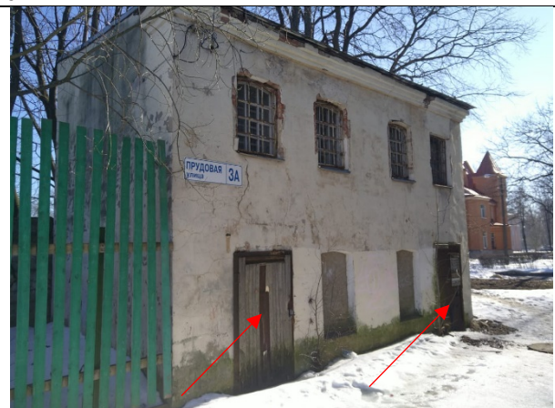
Фото 2. Вид здания, в котором расположен Объект оценки, со двора. Доступ
