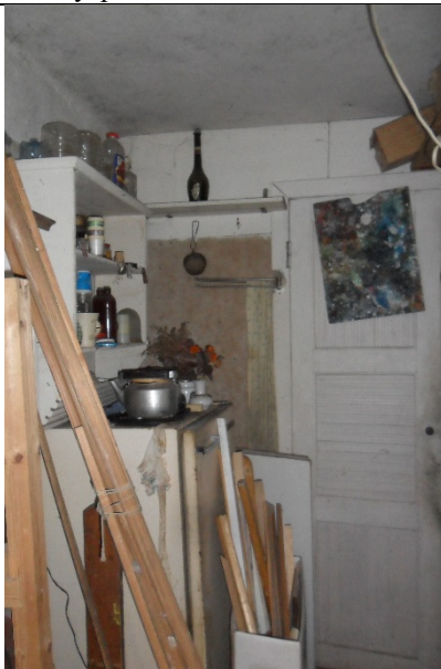
Фото 19. Внутреннее состояние Объекта оценки
