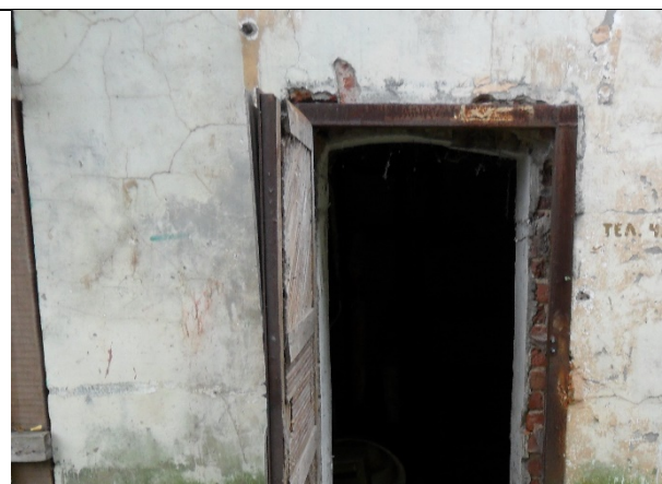
Фото 10. Доступ Объекта оценки (вход пом. 1-Н)
