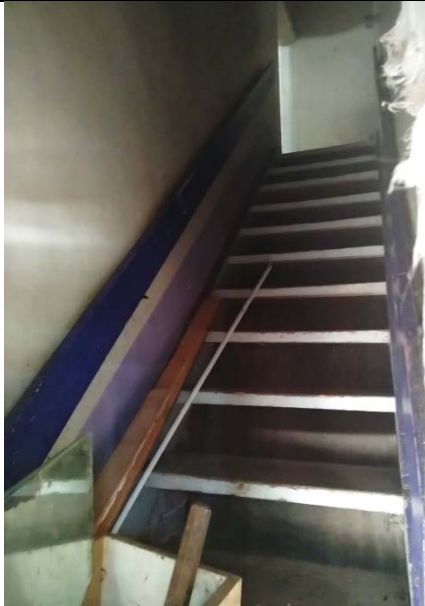
Фото 15. Внутреннее состояние Объекта оценки
