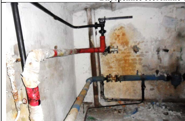
Фото 11. Внутреннее состояние Объекта оценки
