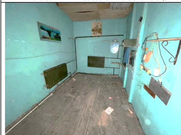
Фото 41. Типичное состояние Объекта оценки
