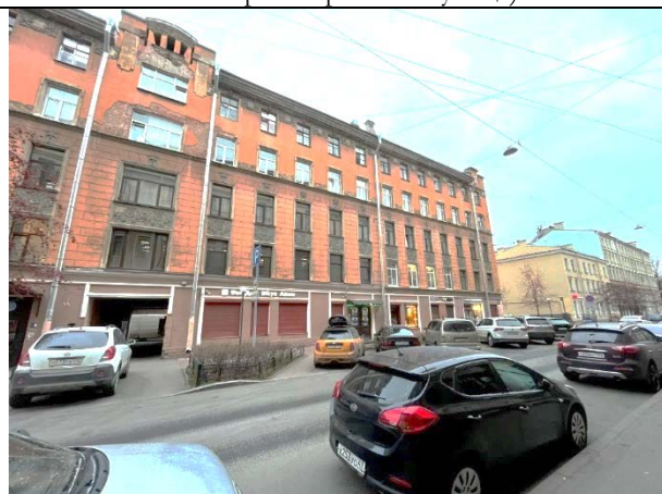
Фото 25. Вид здания расположения Объекта оценки
