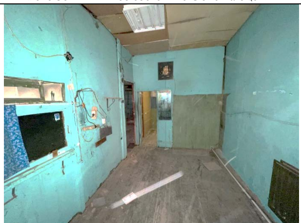
Фото 40. Типичное состояние Объекта оценки
