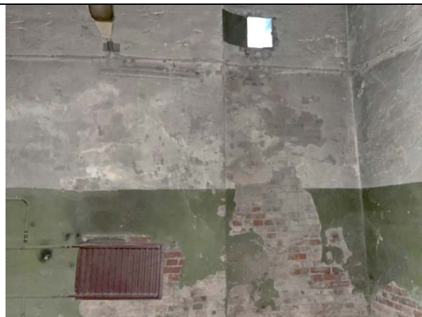
Фото 36. Типичное состояние Объекта оценки
