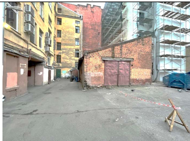
Фото 30. Вид здания Объекта оценки
