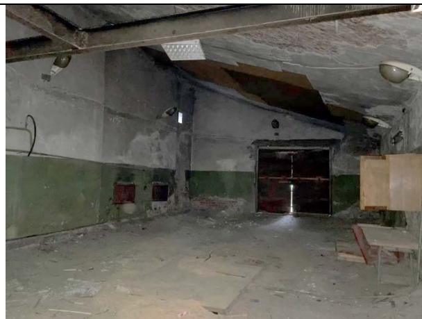
Фото 35. Типичное состояние Объекта оценки
