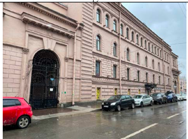
Фото 18. Вид здания расположения Объекта оценки
