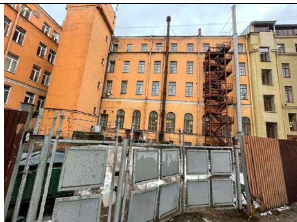
Фото 22. Внутри дворовая территория Объекта оценки
