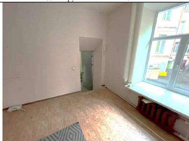
Фото 32. Типичное состояние Объекта оценки
