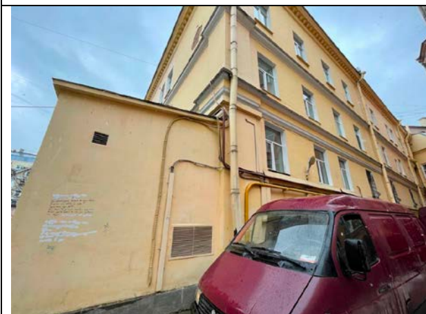
Фото 23. Внутри дворовая территория Объекта оценки
