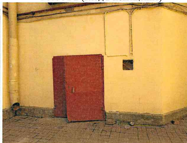
Фото № 2 (вход в помещение)
