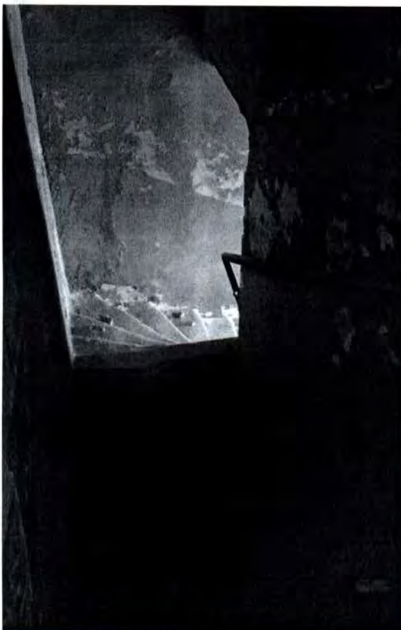
31. Вид на лестницу (пом. 23-Н (1, 4) объекта культурного наследия
