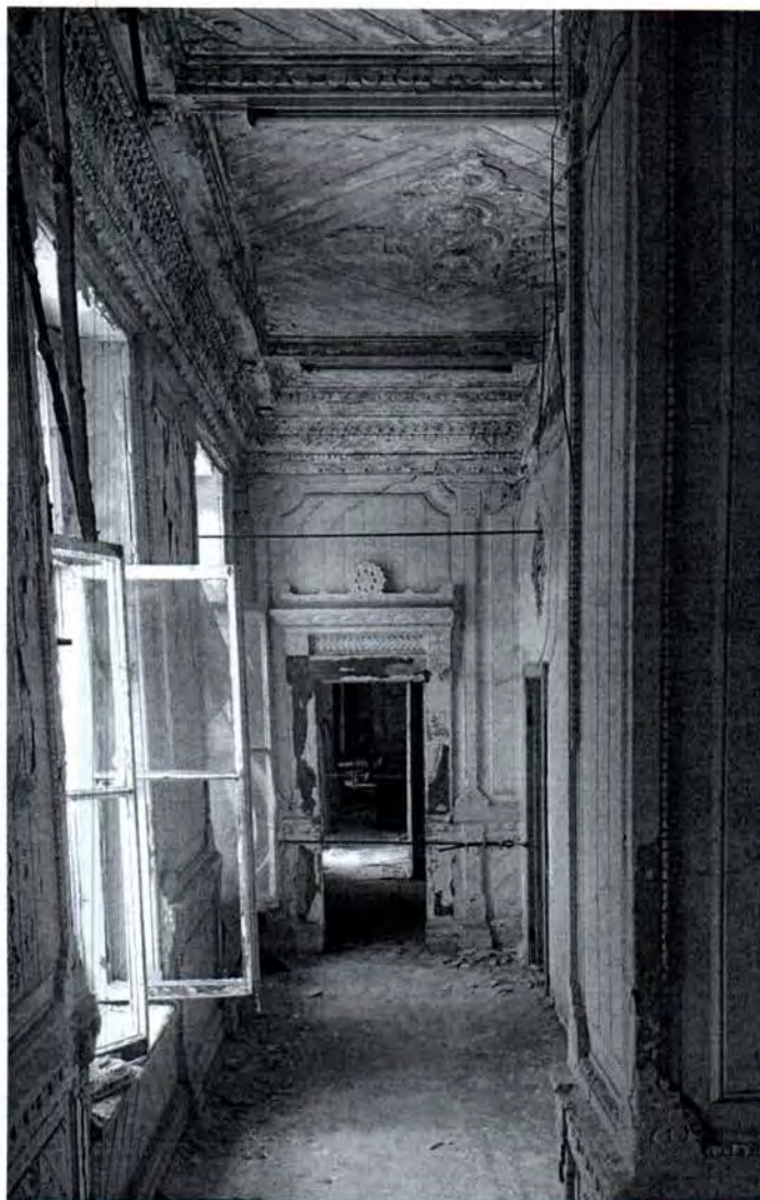
39. Вид на помещение 49-Н (122) объекта культурного наследия
