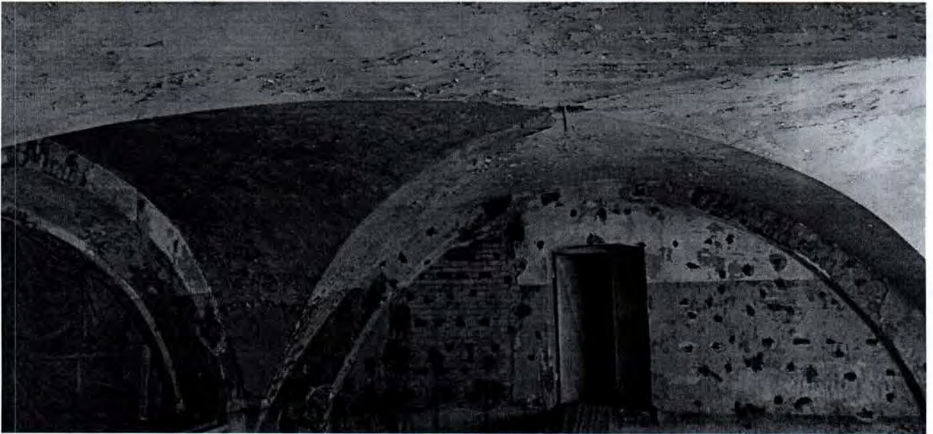
37. Вид на помещение 58-Н (3) объекта культурного наследия
