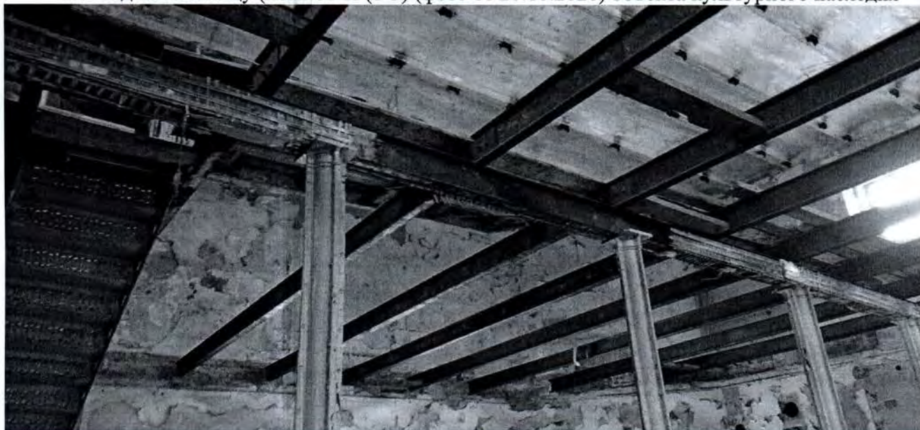
36. Вид на помещение 23-Н (16-20) объекта культурного наследия
