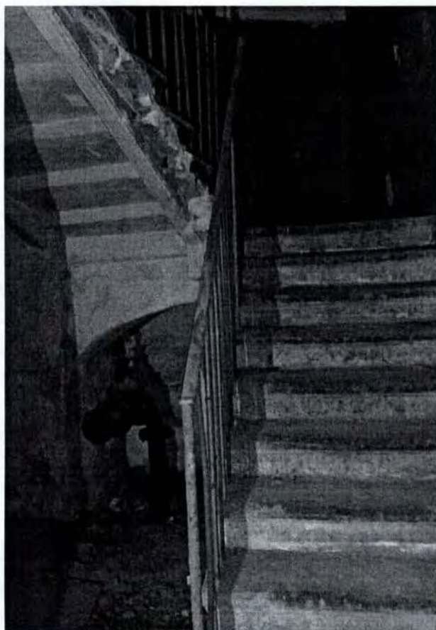
29. Вид на лестницу (пом. 15-Н (7, 9, 17) объекта культурного наследия
