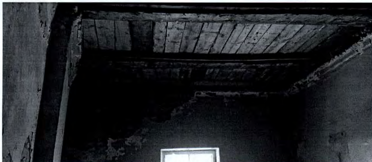
51. Вид на помещение 59-Н (11) объекта культурного наследия
