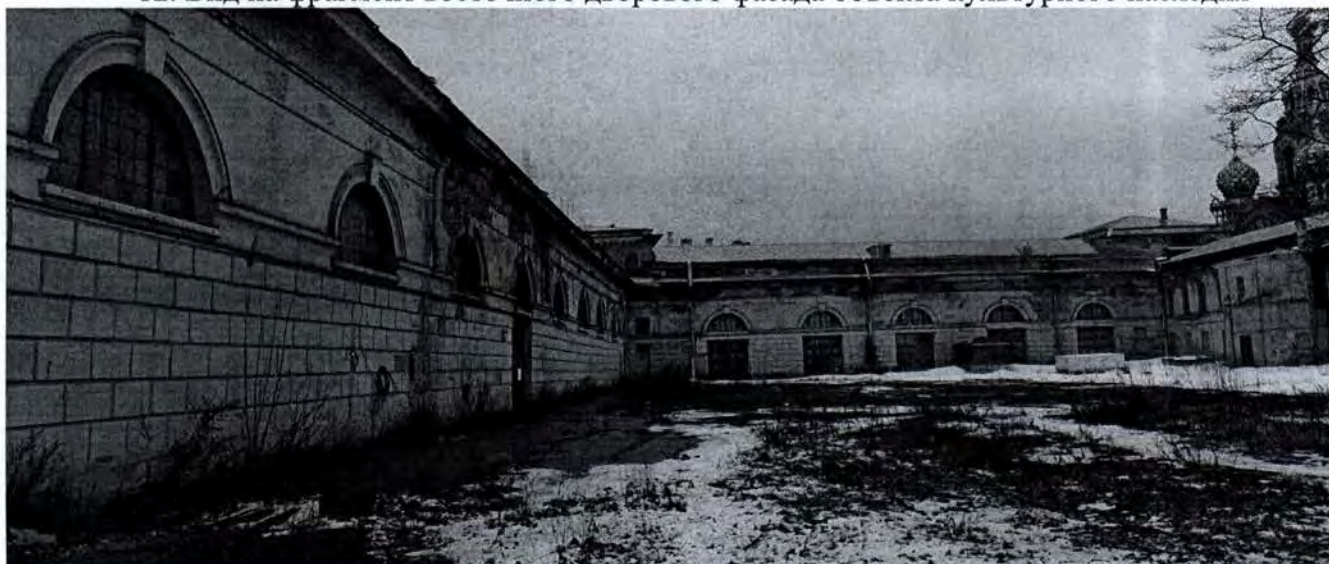
13. Вид на западный дворовый фасад и фрагмент южного дворового фасада объекта культурного наследия
