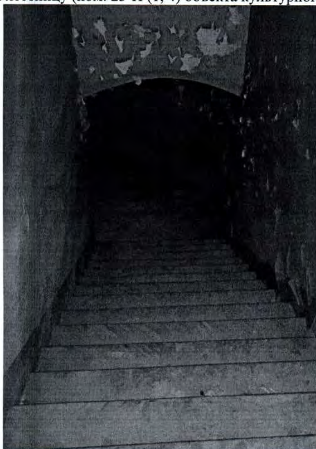
32. Вид на лестницу 2-ЛК объекта культурного наследия
