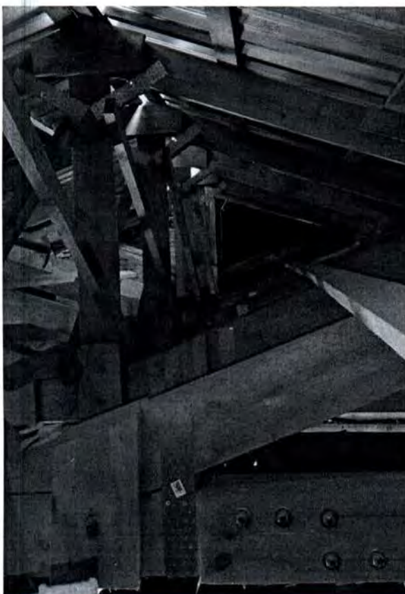
54. Вид на конструкцию крыши объекта культурного наследия
