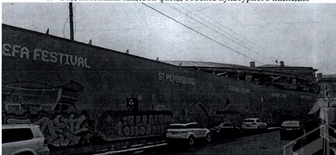
2. Вид на западный лицевой фасад объекта культурного наследия
