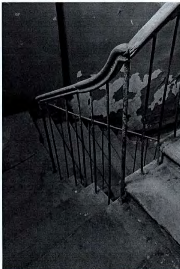
33. Вид на лестницу 23-Н (13, 14) объекта культурного наследия
