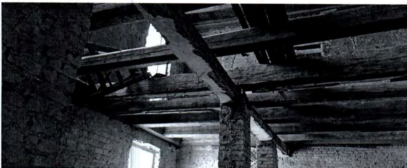
43. Вид на помещение 39-Н (13-17) объекта культурного наследия
