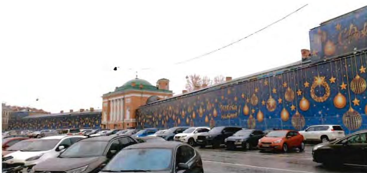
1. Вид на южный лицевой фасад объекта культурного наследия.
