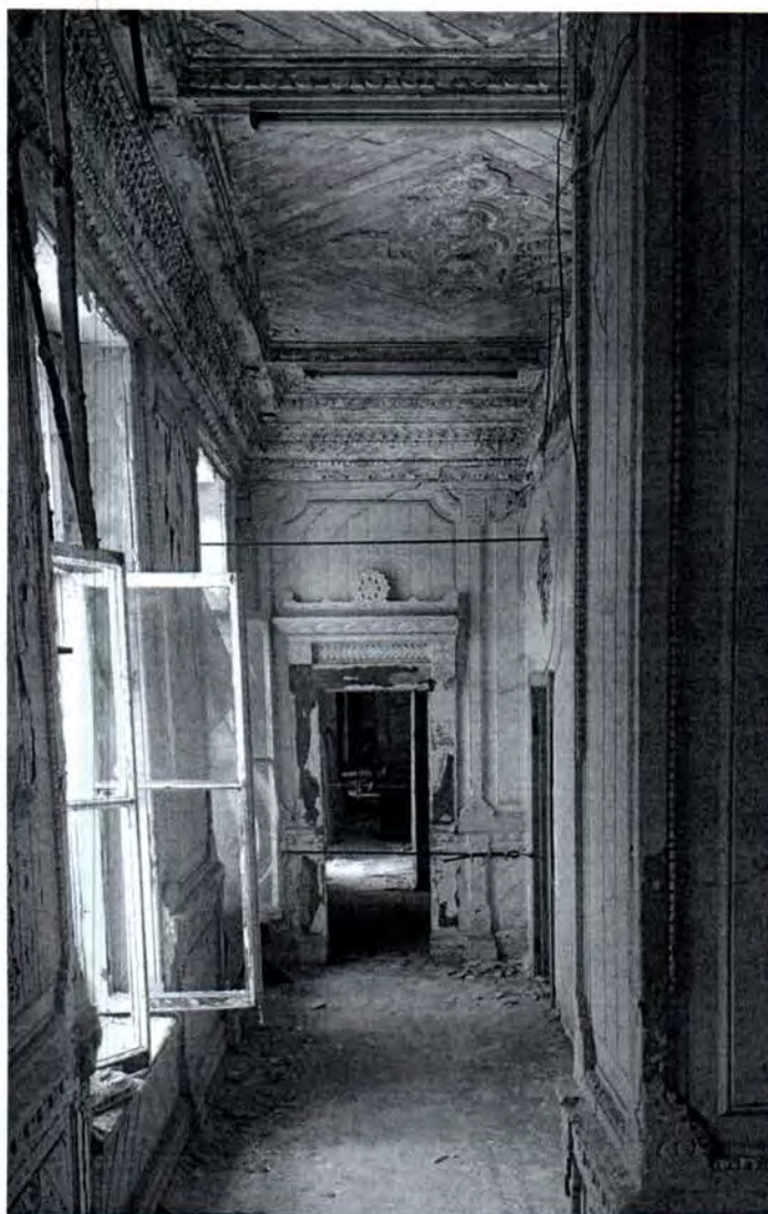
39. Вид на помещение 49-Н (122) объекта культурного наследия
