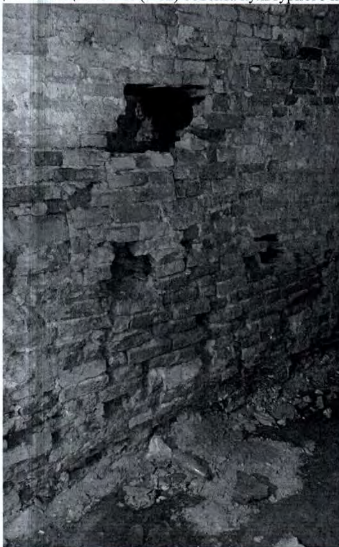
50. Вид на помещение 3-Н (2) объекта культурного наследия
