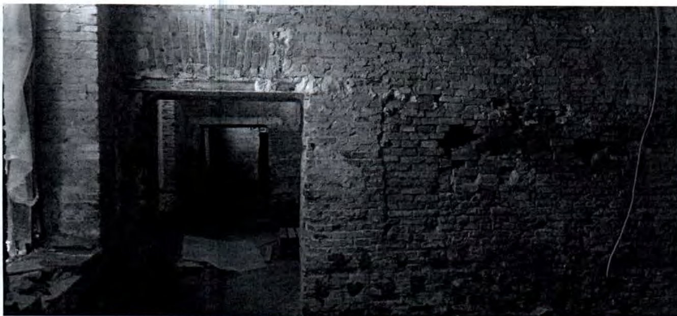
49. Вид на помещение 4-Н (7-12) объекта культурного наследия
