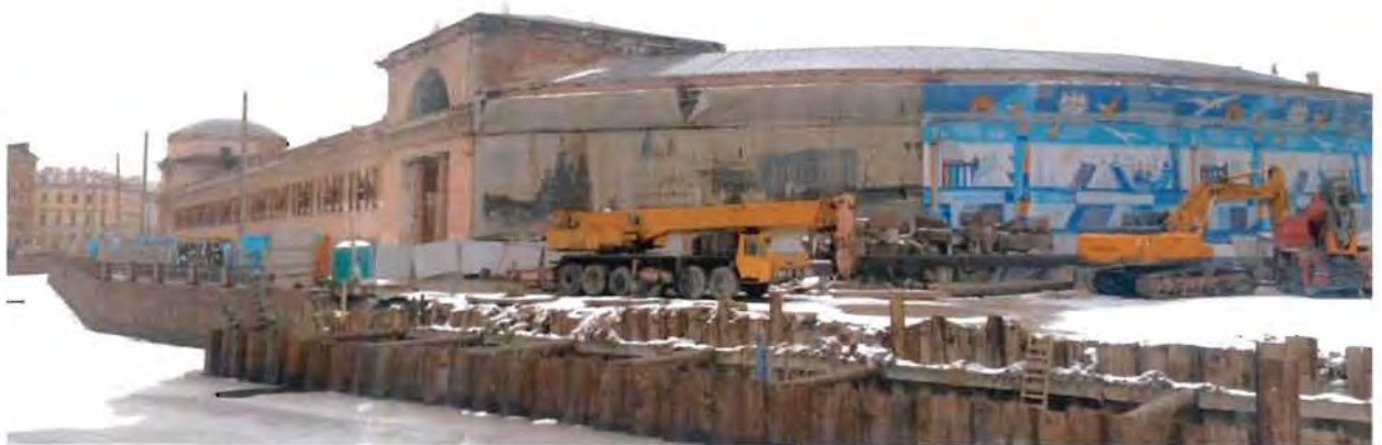
3. Вид на западный лицевой фасад объекта культурного наследия.
