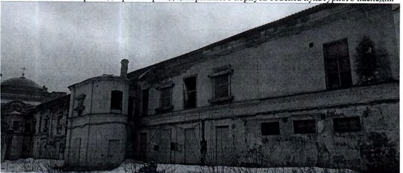
10. Вид на фрагмент северного дворового фасада объекта культурного наследия
