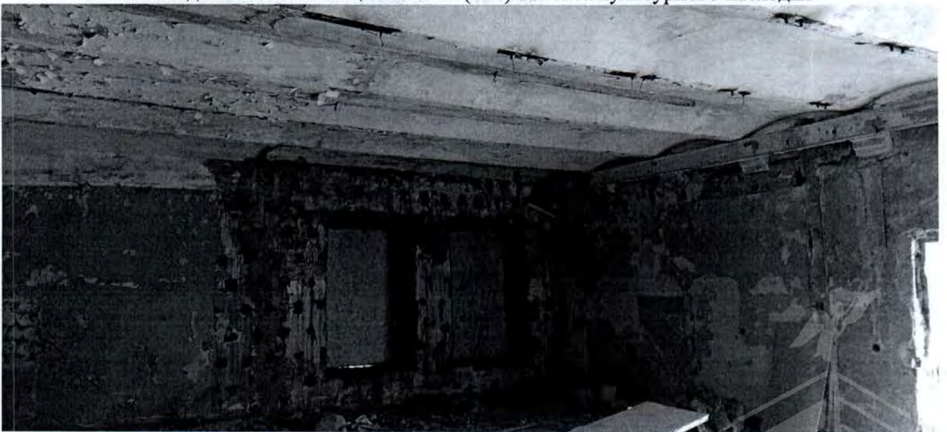
42. Вид на помещение 45-Н (9) объекта культурного наследия
