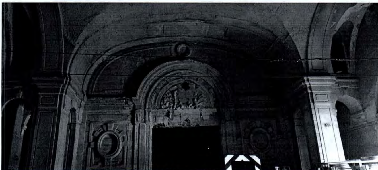
46. Вид на помещение 22-Н (1) объекта культурного наследия
