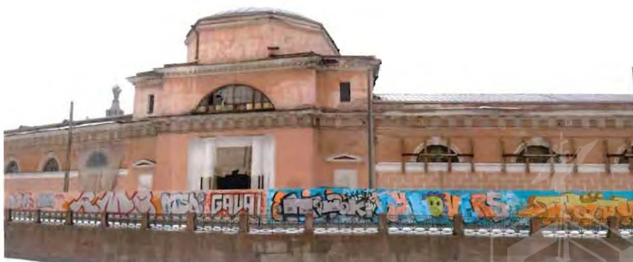
2. Вид на фрагмент северного лицевой фасада объекта культурного наследия.
