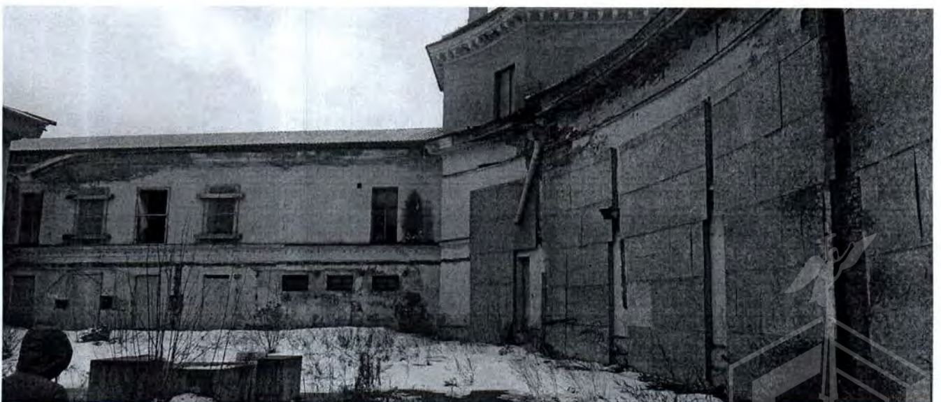
11. Вид на фрагмент северного дворового фасада объекта культурного наследия
