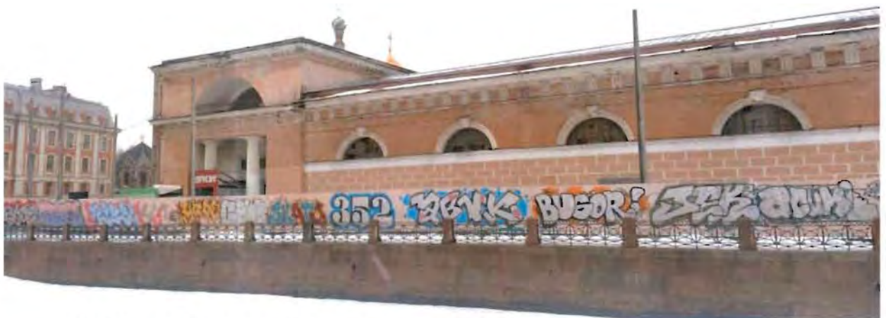
4. Вид на фрагмент северного лицевого фасада объекта культурного наследия.
