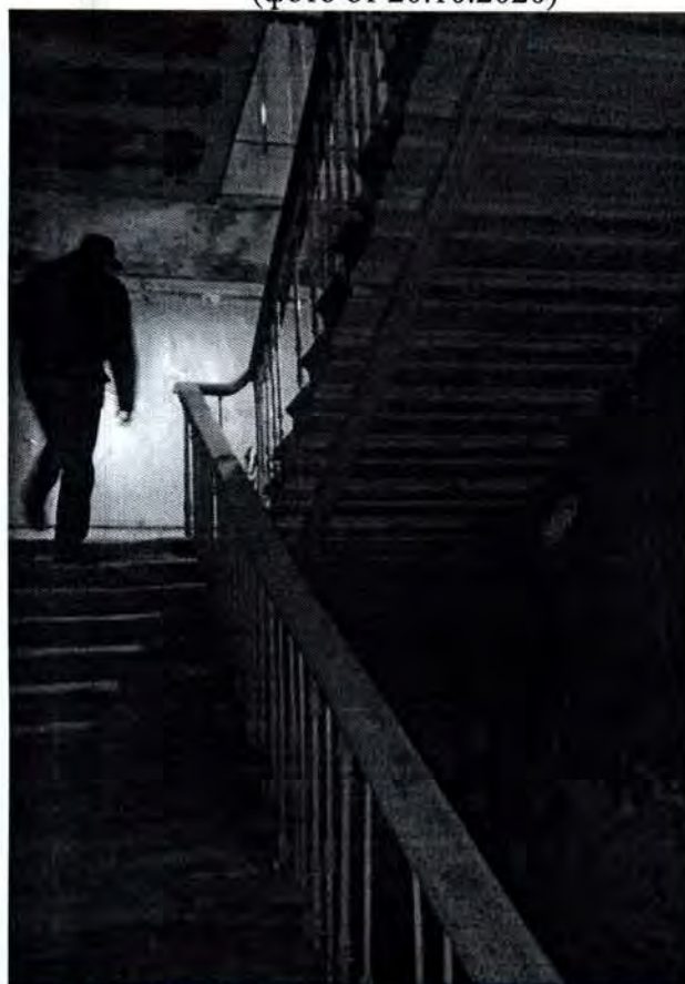
28. Вид на лестницу 1-ЛК объекта культурного наследия
