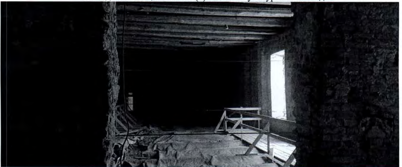
38. Вид на помещение 49-Н (125) объекта культурного наследия
