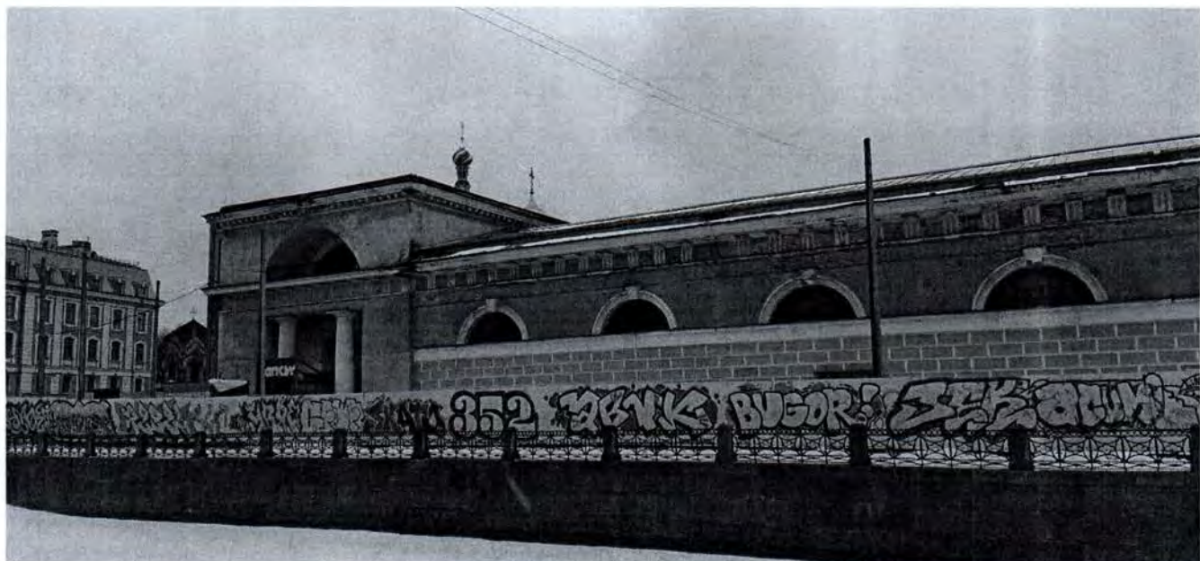
6. Вид на фрагмент северного лицевого фасада объекта культурного наследия
