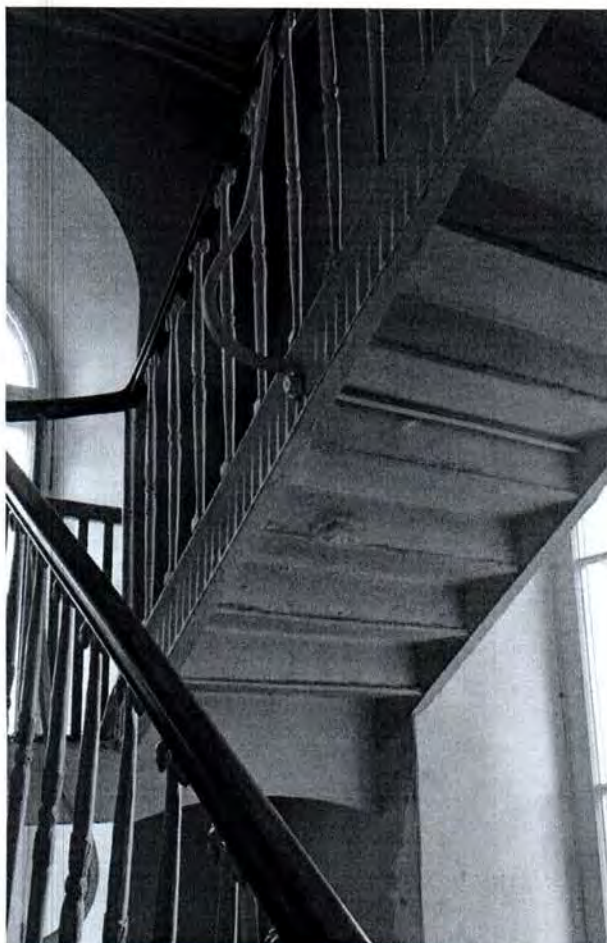
35. Вид на лестницу (пом. 61-Н (1-3) (фото от 20.10.2020) объекта культурного наследия
