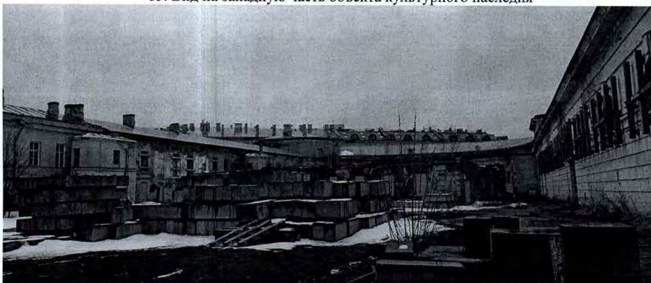
16. Вид на западную часть территории объекта культурного наследия
