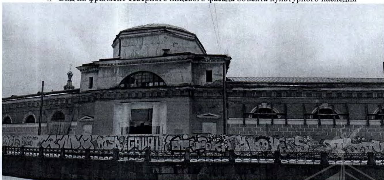
5. Вид на фрагмент северного лицевого фасада объекта культурного наследия
