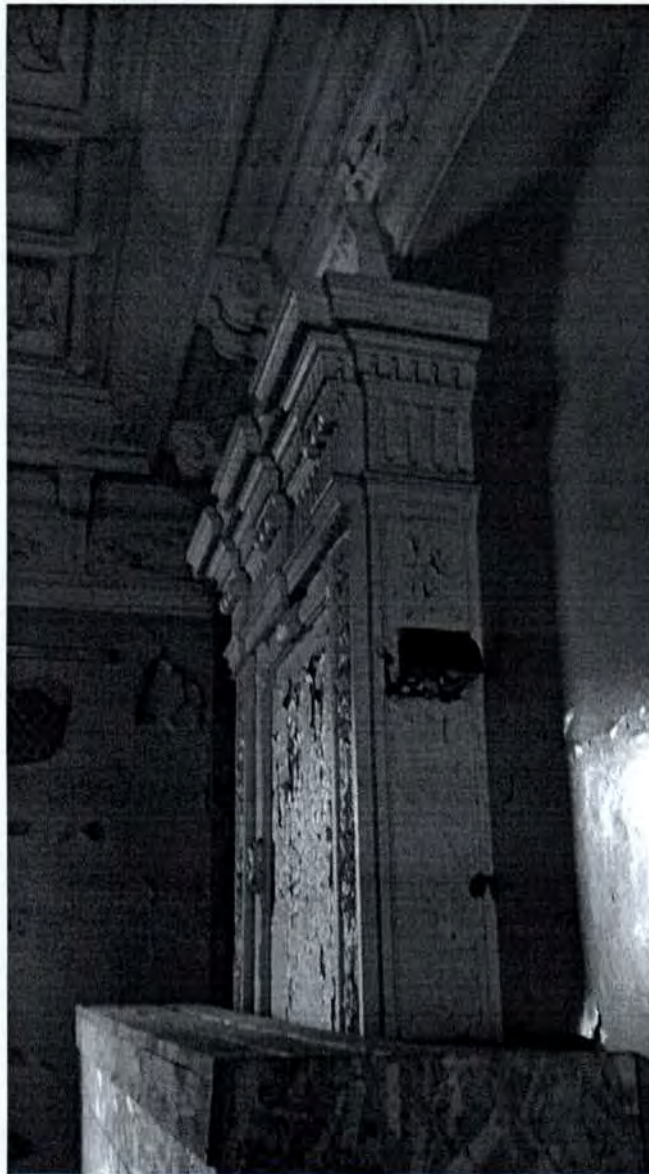
41. Вид на камин помещения 49-Н (104) объекта культурного наследия
