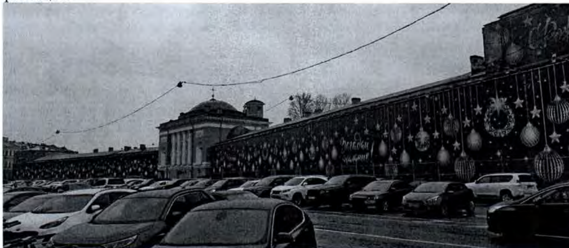
1. Вид на южный лицевой фасад объекта культурного наследия
