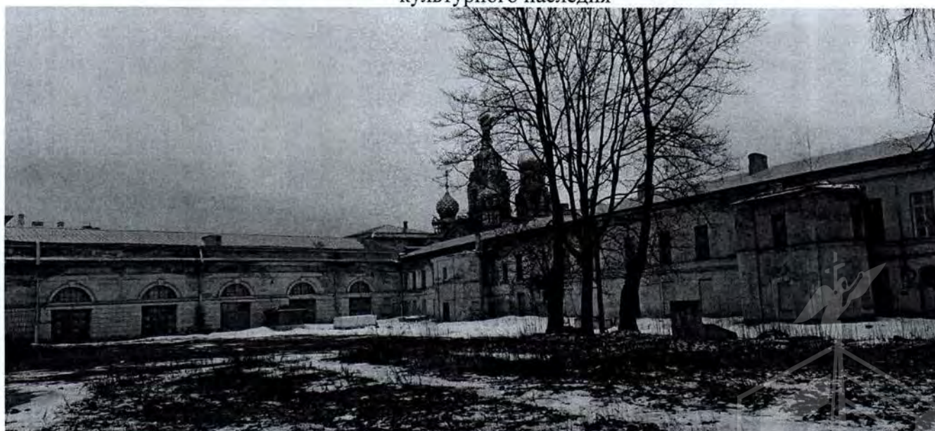
14. Вид на фрагмент западного и северного дворовых фасадов объекта культурного наследия
