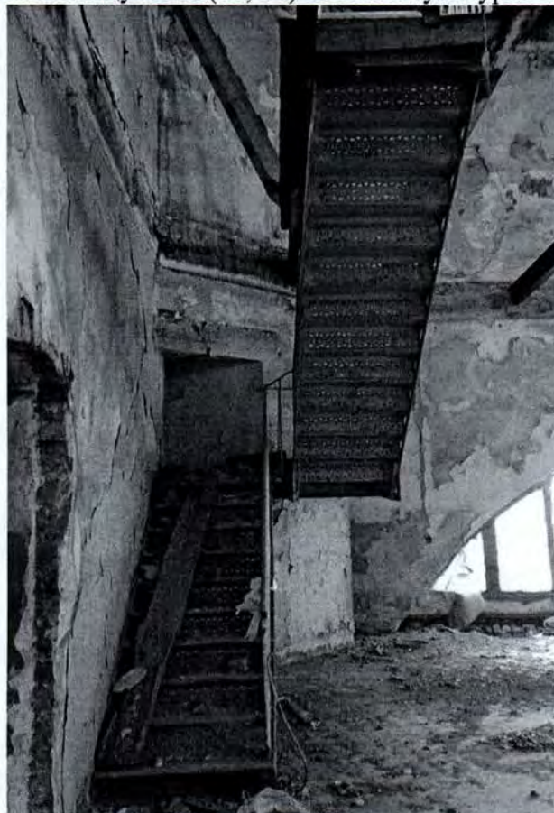
34. Вид на лестницу 23-Н (16) объекта культурного наследия
