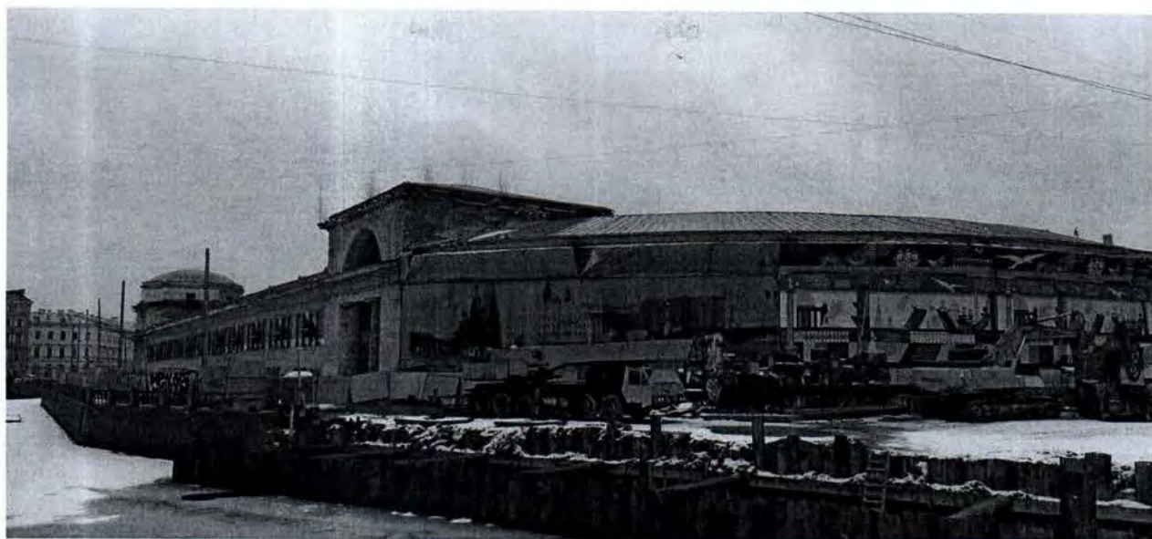
3. Вид на западный лицевой фасад объекта культурного наследия
