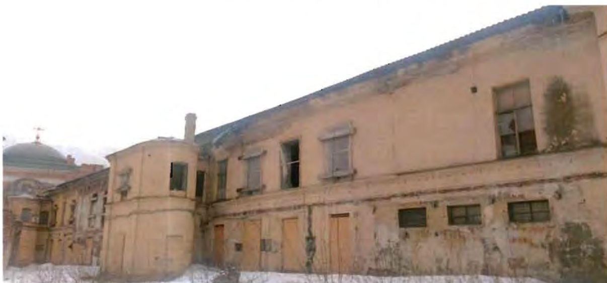
7. Вид на фрагмент северного дворового фасада объекта культурного наследия.
