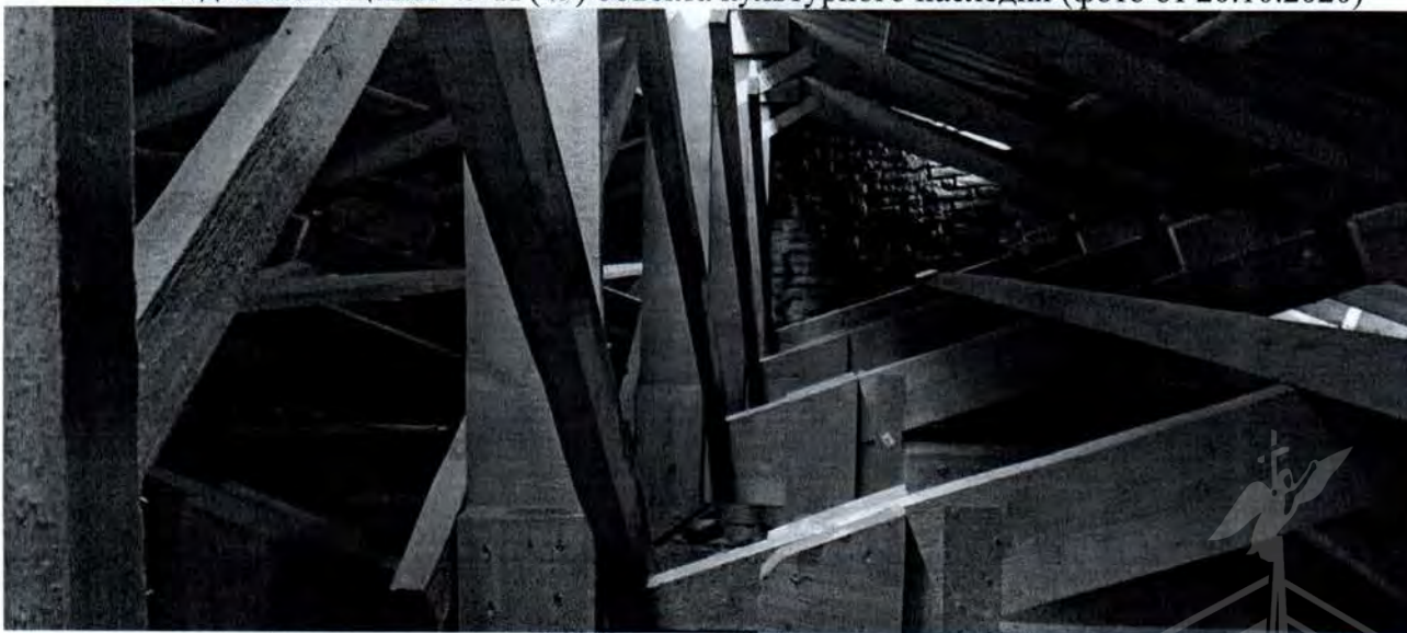
53. Вид на конструкцию крыши объекта культурного наследия
