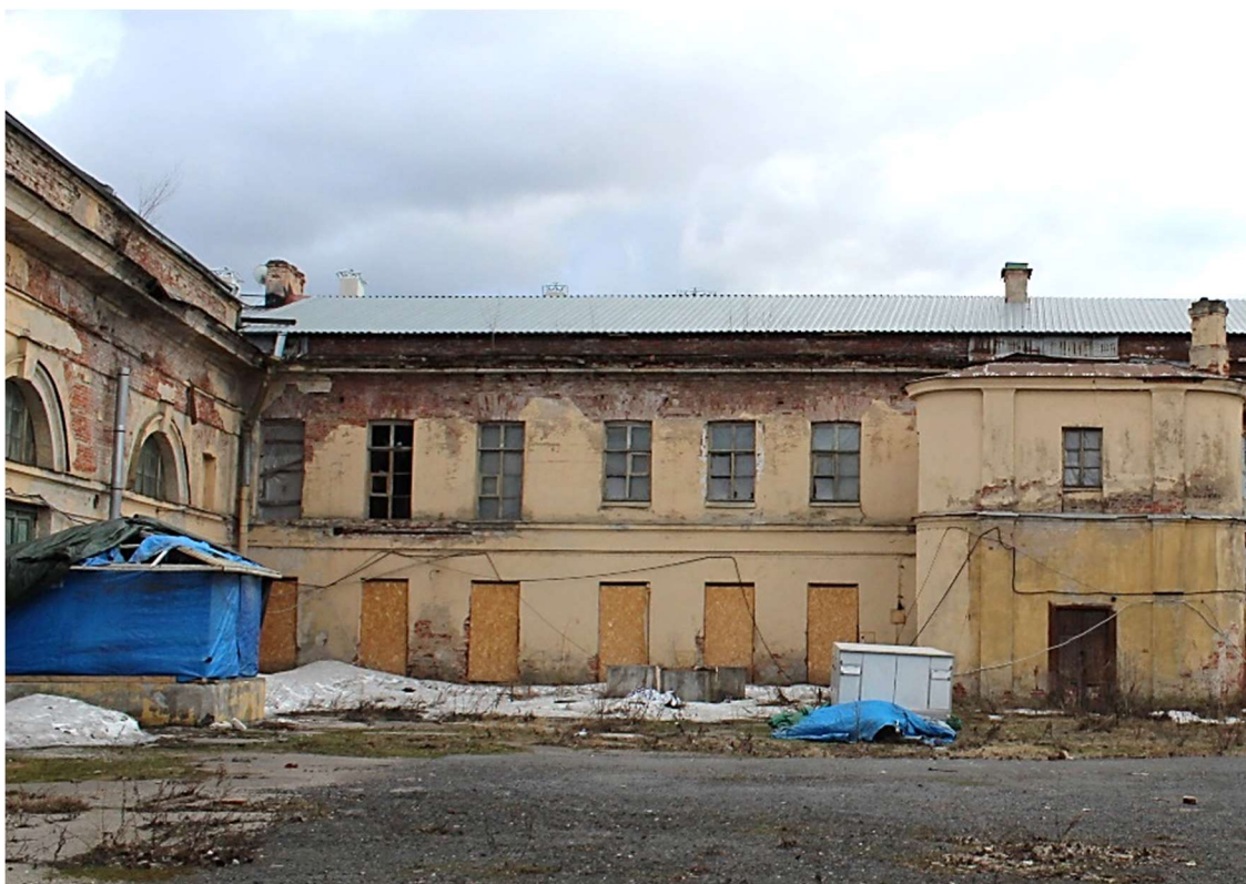
Внутренние помещения южной части здания
