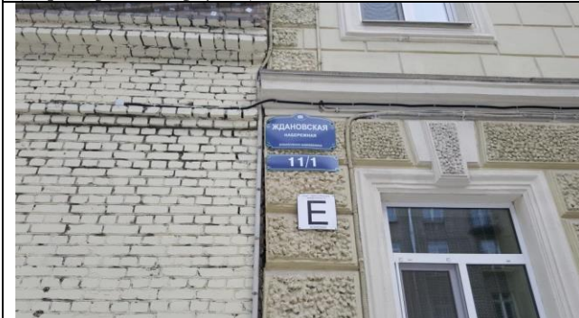
Фото 11. Адрес Объекта оценки
