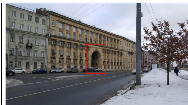
Фото 1. Ближайшее окружение Объекта оценки (Ждановская набережная), арка ведущая на Офицерский переулок
