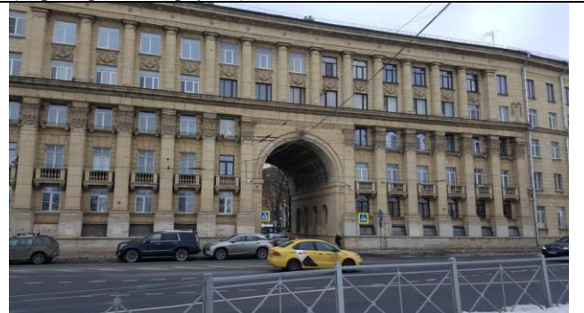
Фото 12. Вид здания расположения Объекта оценки
