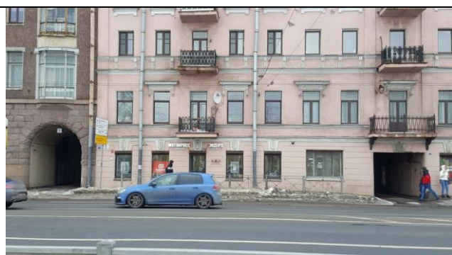
Фото 2. Ближайшее окружение Объекта оценки (Ждановская набережная)
