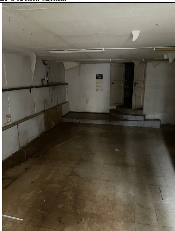
Фото 10. Внутреннее состояние Объекта оценки
