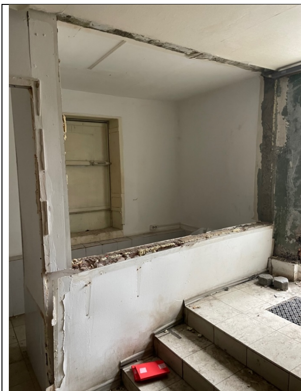
Фото 11. Внутреннее состояние Объекта оценки
