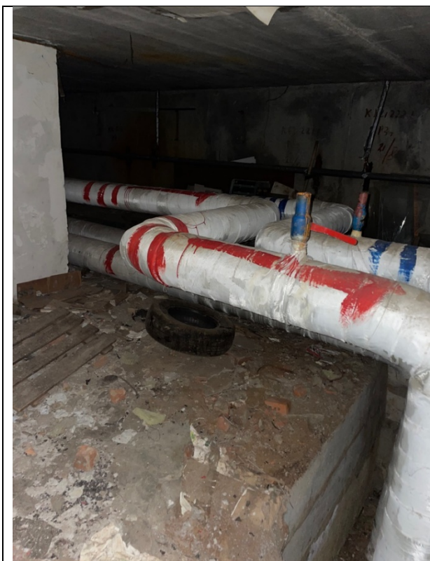
Фото 19. Внутреннее состояние Объекта оценки
