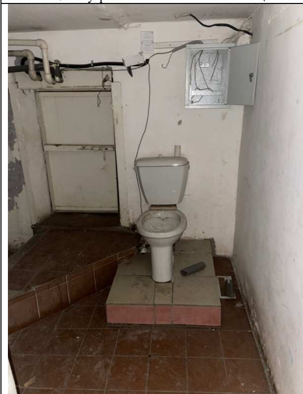
Фото 17. Внутреннее состояние Объекта оценки
