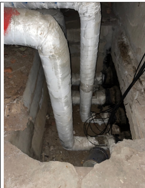
Фото 15. Внутреннее состояние Объекта оценки
