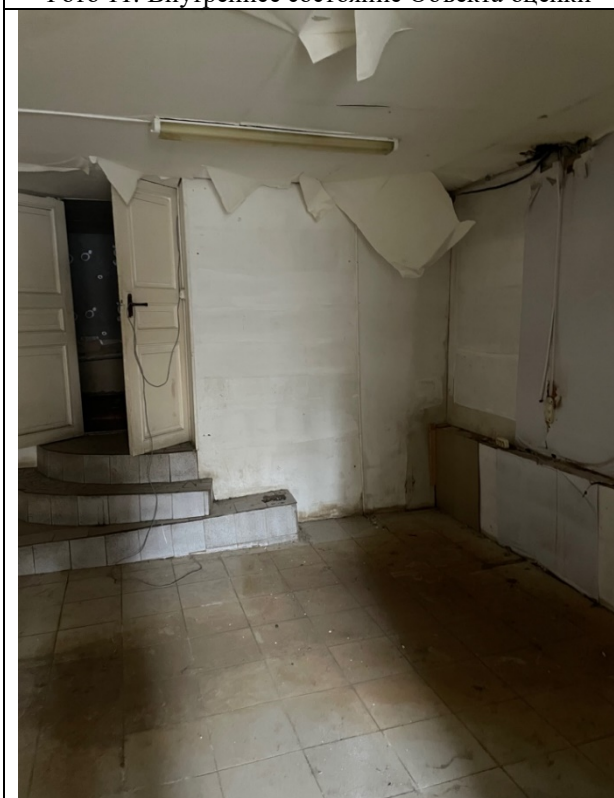
Фото 13. Внутреннее состояние Объекта оценки
