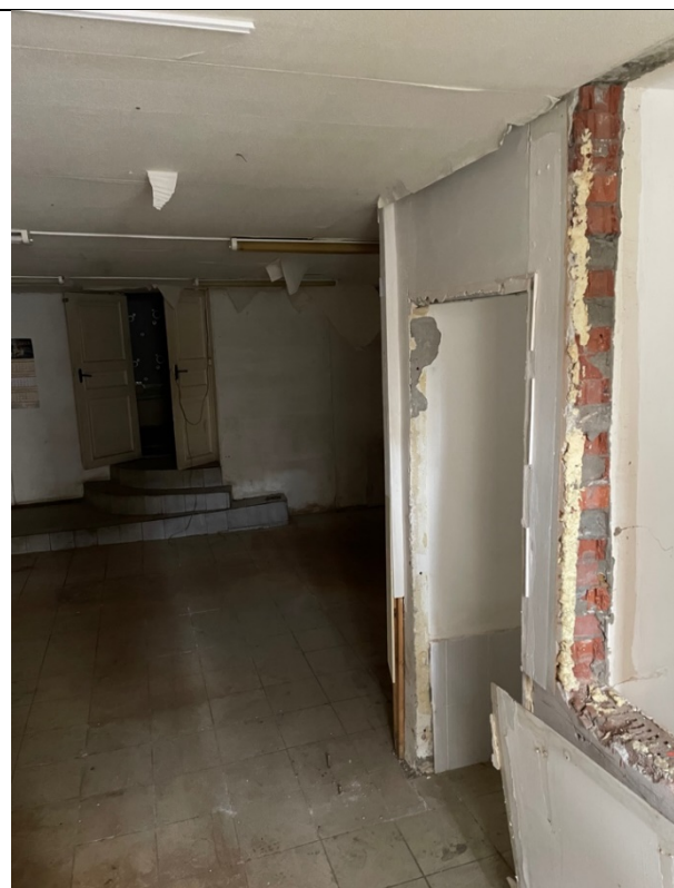
Фото 12. Внутреннее состояние Объекта оценки
