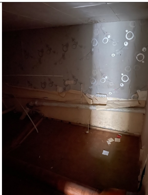
Фото 16. Внутреннее состояние Объекта оценки
