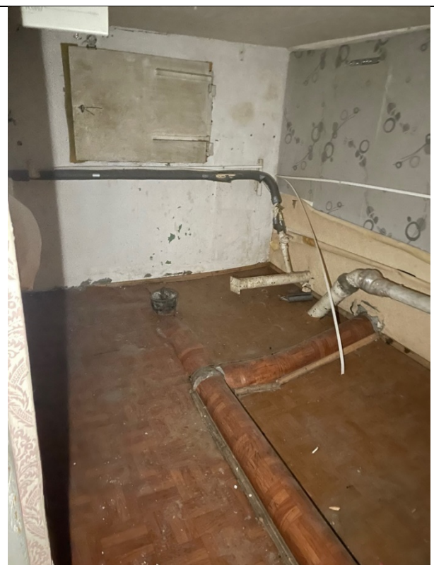
Фото 20. Внутреннее состояние Объекта оценки
