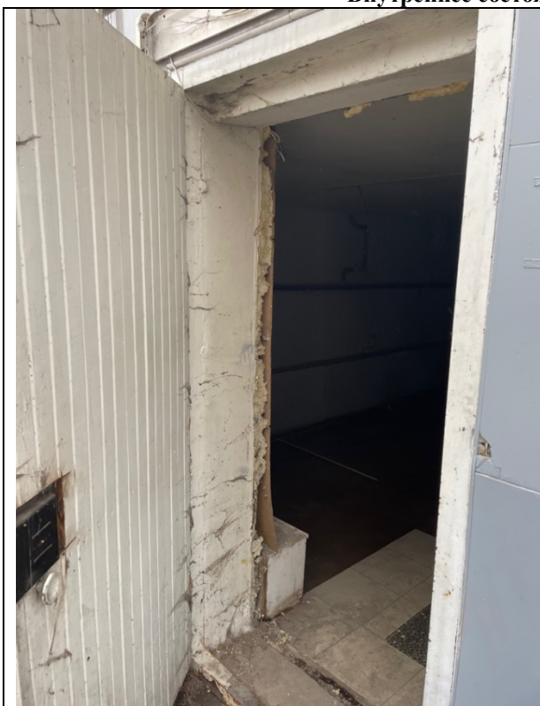
Фото 9. Внутреннее состояние Объекта оценки
