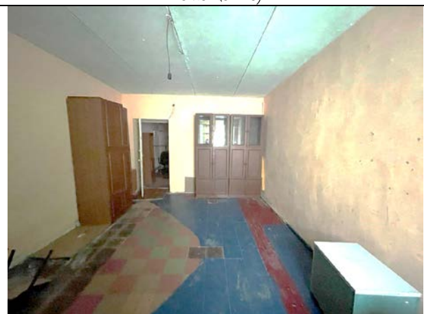
Фото 22. Типичное состояние Объекта оценки
