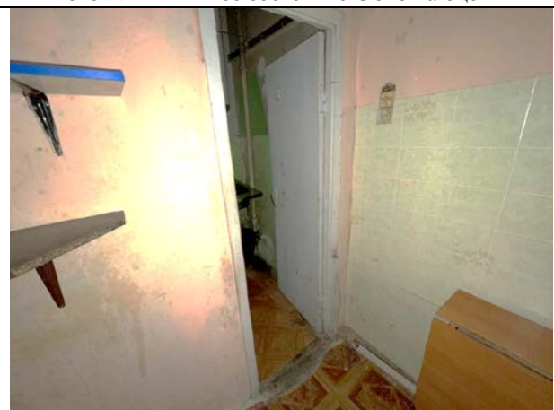
Фото 24. Типичное состояние Объекта оценки
