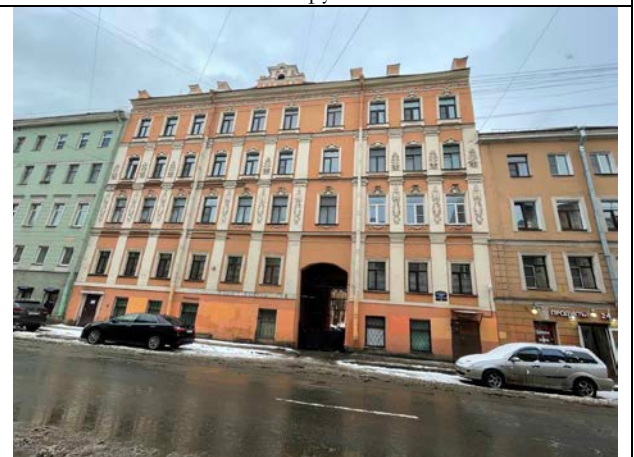
Фото 14. Вид здания расположения Объекта оценки
