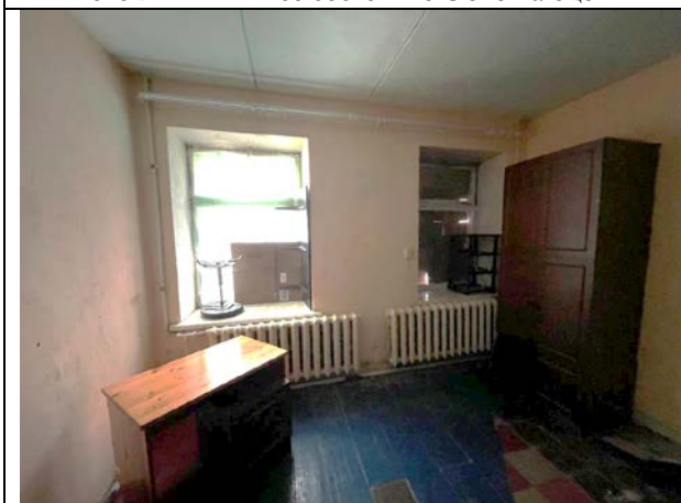
Фото 23. Типичное состояние Объекта оценки
