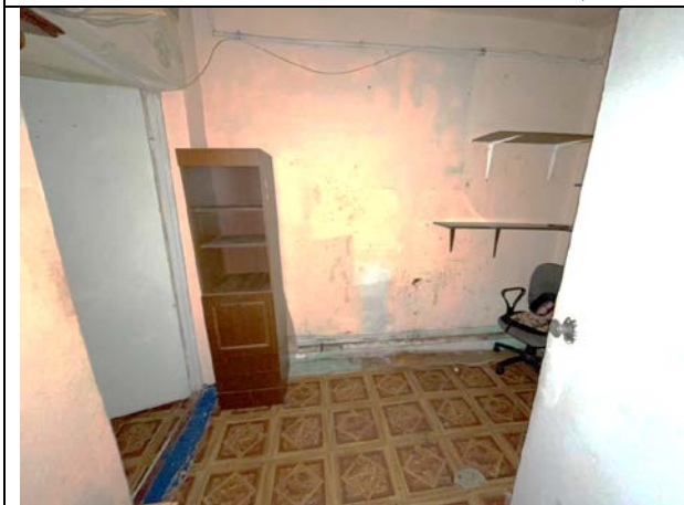
Фото 25. Типичное состояние Объекта оценки
