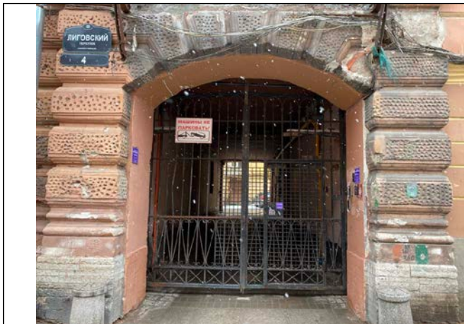
Фото № 7 Вход в арку
