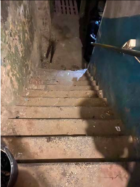
Фото № 13 Внутреннее состояние помещения
