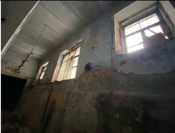
Фото № 21 Внутреннее состояние помещения
