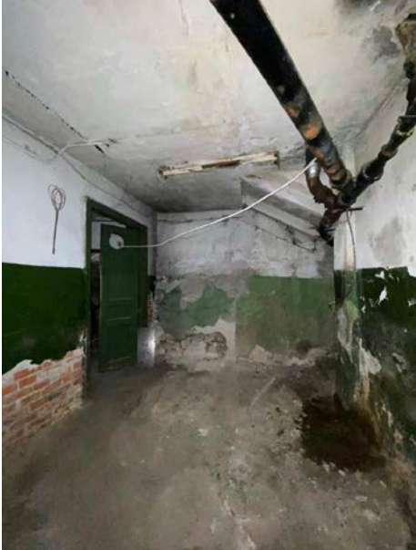
Фото № 15 Внутреннее состояние помещения
