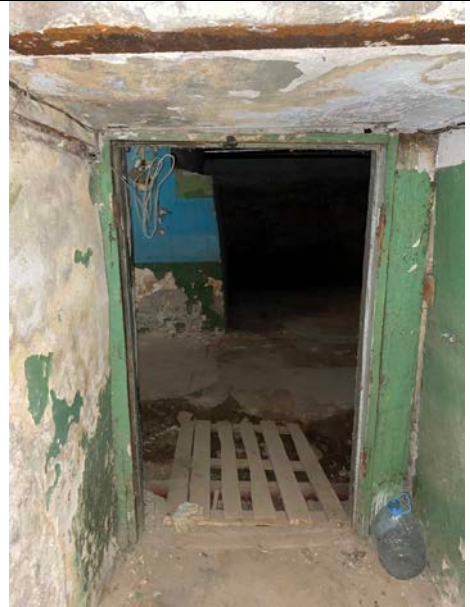
Фото № 14 Внутреннее состояние помещения
