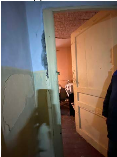
Фото № 27 Внутреннее состояние помещения
