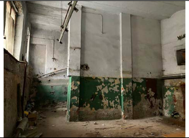
Фото № 20 Внутреннее состояние помещения
