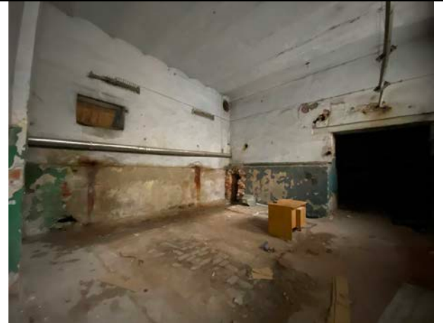
Фото № 22 Внутреннее состояние помещения
