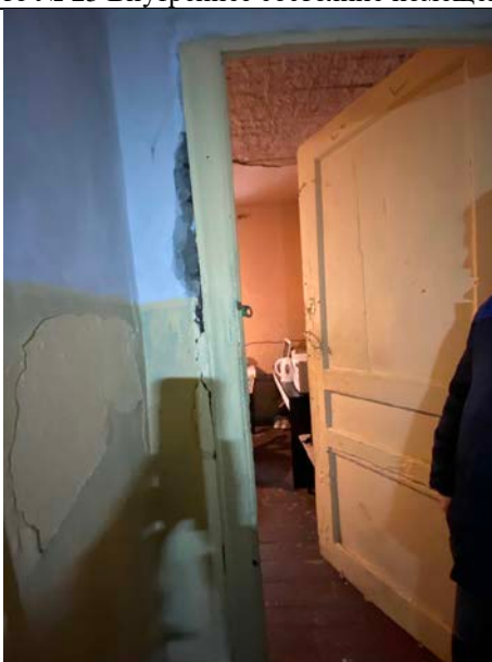
Фото № 27 Внутреннее состояние помещения
