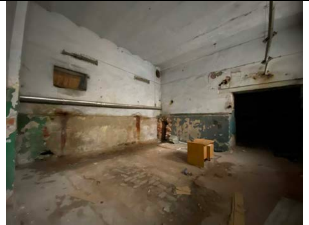
Фото № 22 Внутреннее состояние помещения
