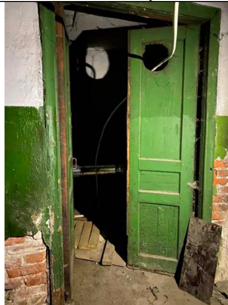
Фото № 10 Вход в помещение
