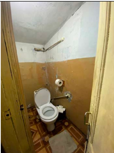
Фото № 25 Внутреннее состояние помещения
