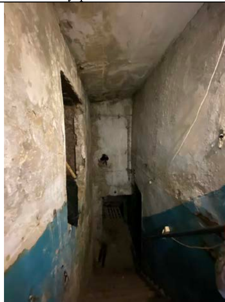
Фото № 28 Внутреннее состояние помещения
