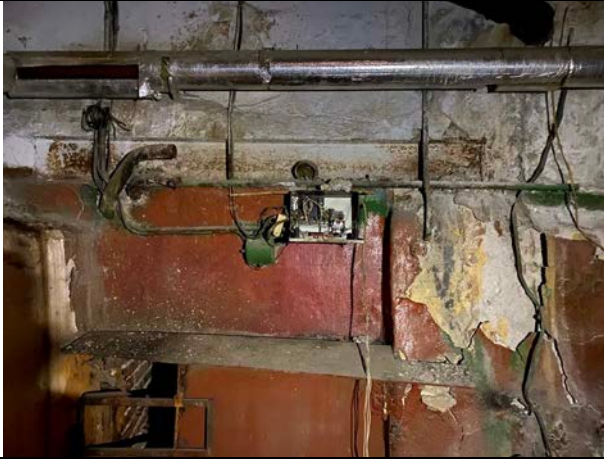
Фото № 19 Внутреннее состояние помещения
