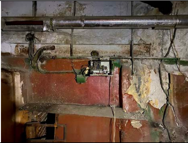
Фото № 19 Внутреннее состояние помещения
