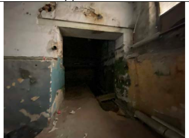
Фото № 24 Внутреннее состояние помещения
