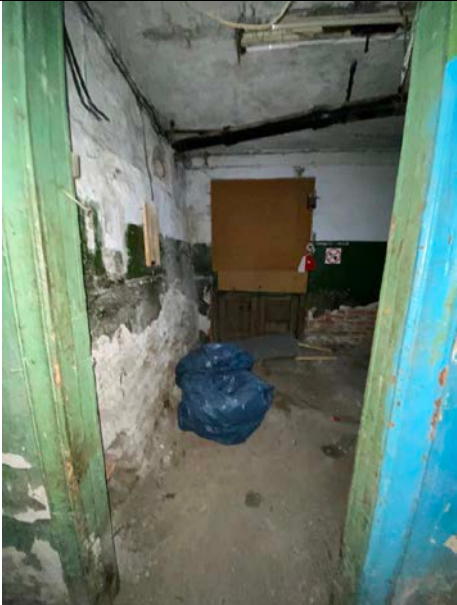
Фото № 17 Внутреннее состояние помещения
