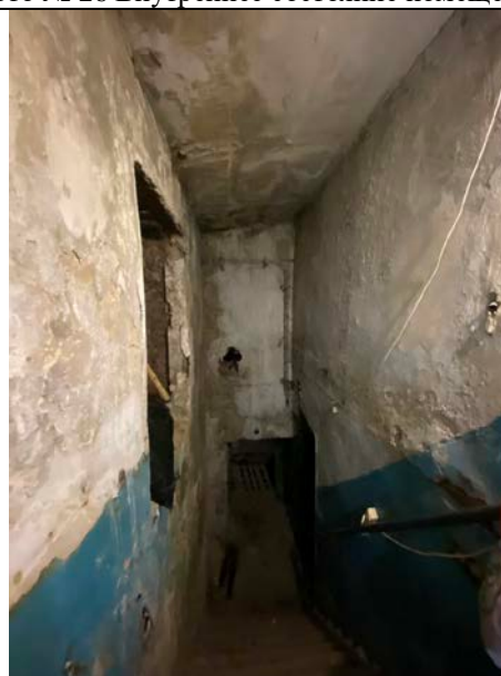
Фото № 28 Внутреннее состояние помещения
