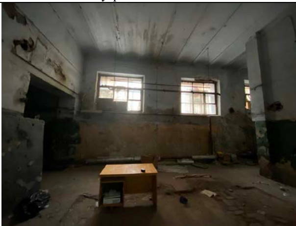
Фото № 23 Внутреннее состояние помещения
