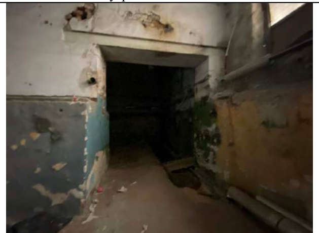
Фото № 24 Внутреннее состояние помещения
