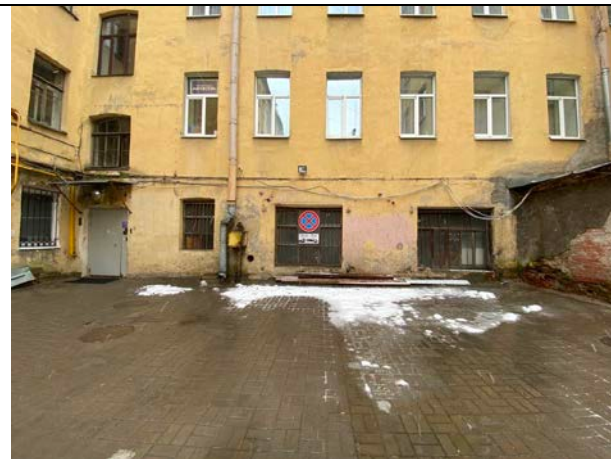
Фото № 8 Вход в помещение, расположение окон
