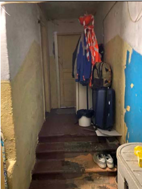
Фото № 11 Внутреннее состояние помещения
