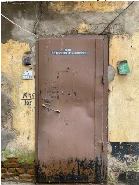
Фото № 9 Вход в помещение
