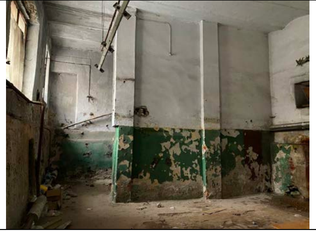
Фото № 20 Внутреннее состояние помещения
