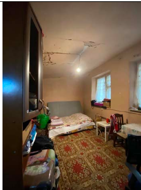
Фото № 26 Внутреннее состояние помещения
