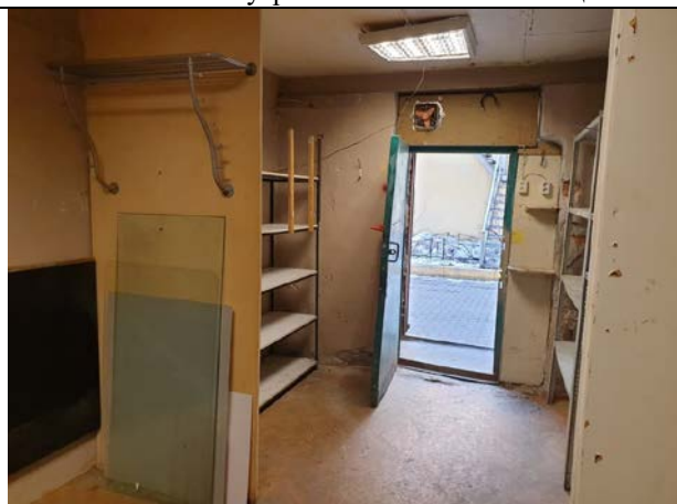
Фото № 12 – Внутреннее состояние помещения
