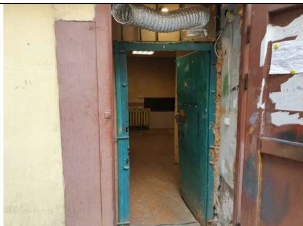
Фото № 10 – Внутреннее состояние помещения
