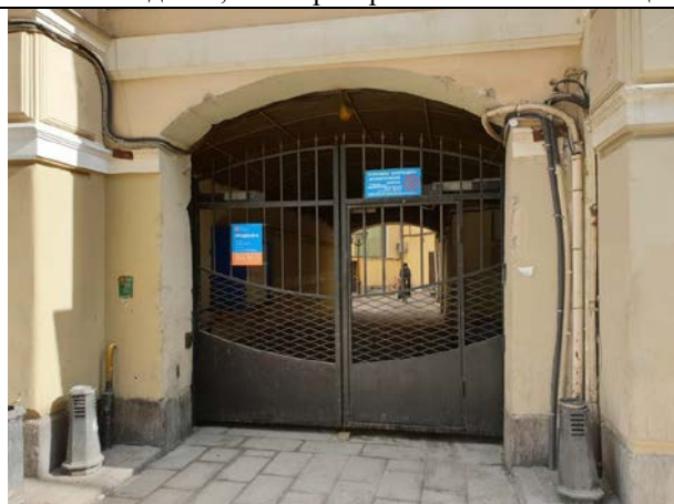
Фото № 6 – Вход в арку
