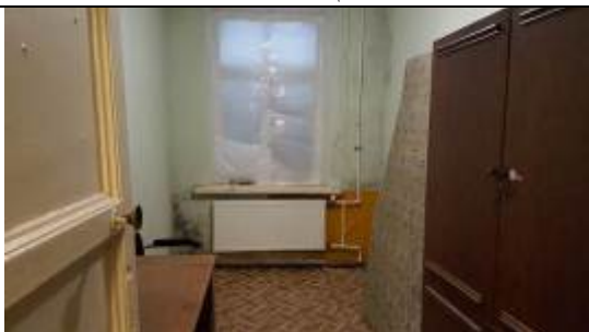
Фото 17. Типичное состояние Объекта оценки
