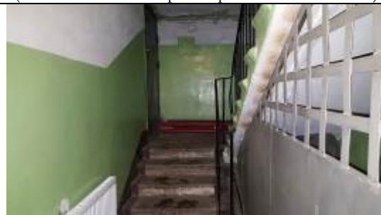
Фото 16. Лестничный проём парадной жилого дома Объекта оценки
