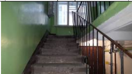
Фото 15. Лестничный проём парадной жилого дома Объекта оценки
