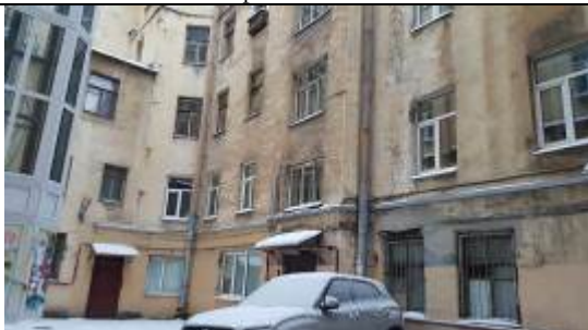
Фото 11. Внутри дворовая территория здания расположения Объекта оценки
