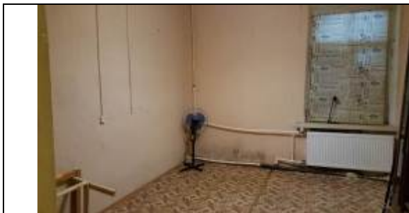
Фото 19. Типичное состояние Объекта оценки
