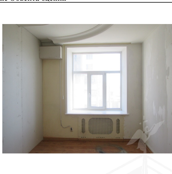
Фото 12. Внутреннее состояние Объекта оценки
