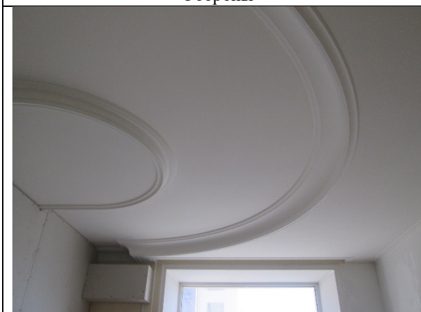
Фото 15. Внутреннее состояние Объекта оценки
