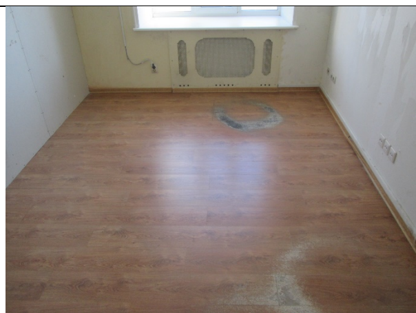
Фото 14. Внутреннее состояние Объекта оценки
