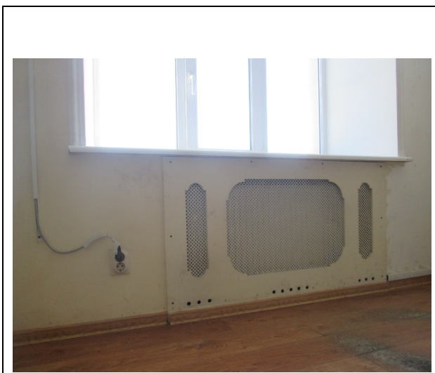
Фото 19. Внутреннее состояние Объекта оценки
