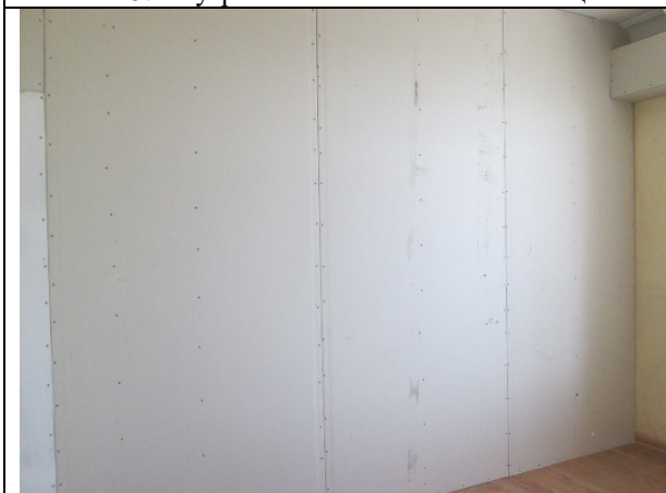
Фото 17. Внутреннее состояние Объекта оценки
