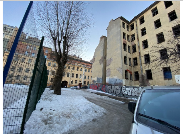
Фото № 4. Подъездные пути и окружение объекта
