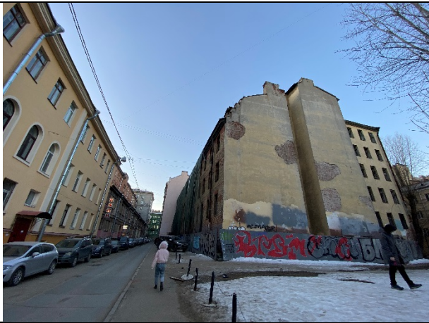
Фото № 1. Подъездные пути и окружение объекта
