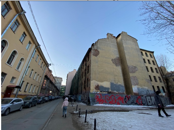
Фото № 3. Подъездные пути и окружение объекта
