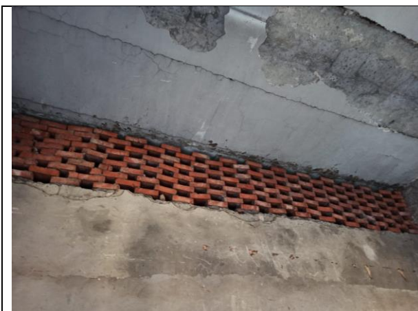
Фото 11. Внутреннее состояние Объекта оценки
