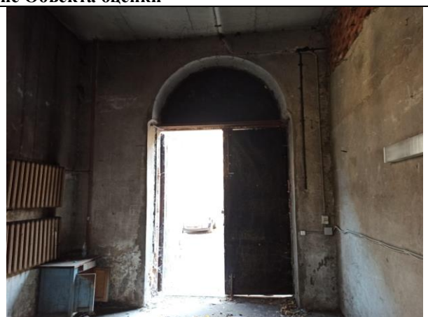
Фото 8. Внутреннее состояние Объекта оценки
