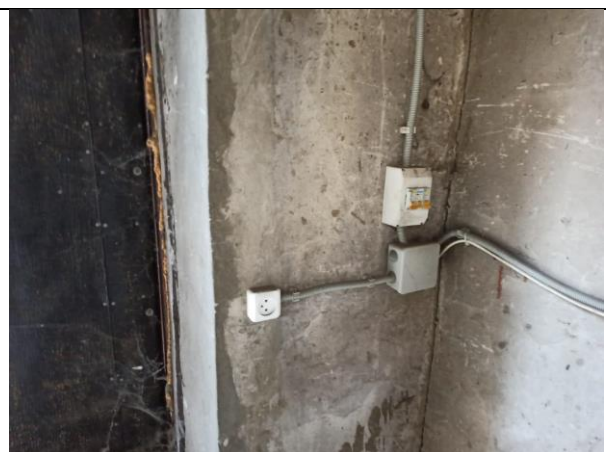
Фото 12. Внутреннее состояние Объекта оценки
