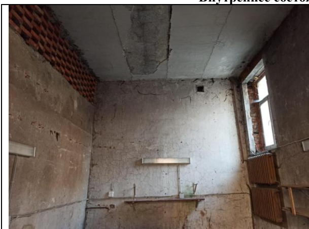
Фото 7. Внутреннее состояние Объекта оценки
