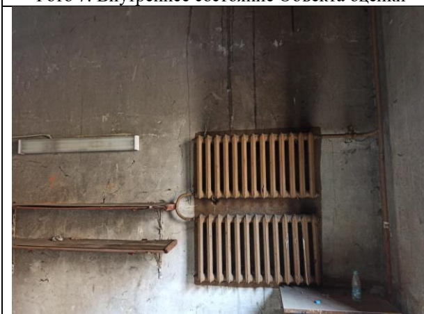
Фото 9. Внутреннее состояние Объекта оценки
