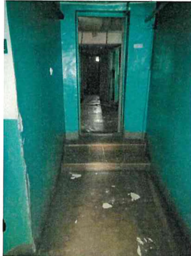
Фото № 34(ч.п.8 пом. 1-Н)
