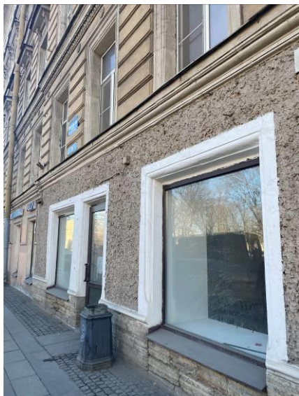
Фото 3. Состояние здания, в котором находится объект оценки
