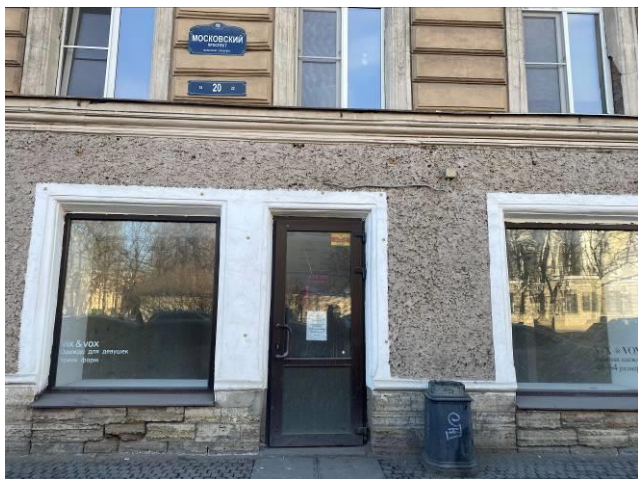
Фото 1. Состояние здания, в котором находится объект оценки
