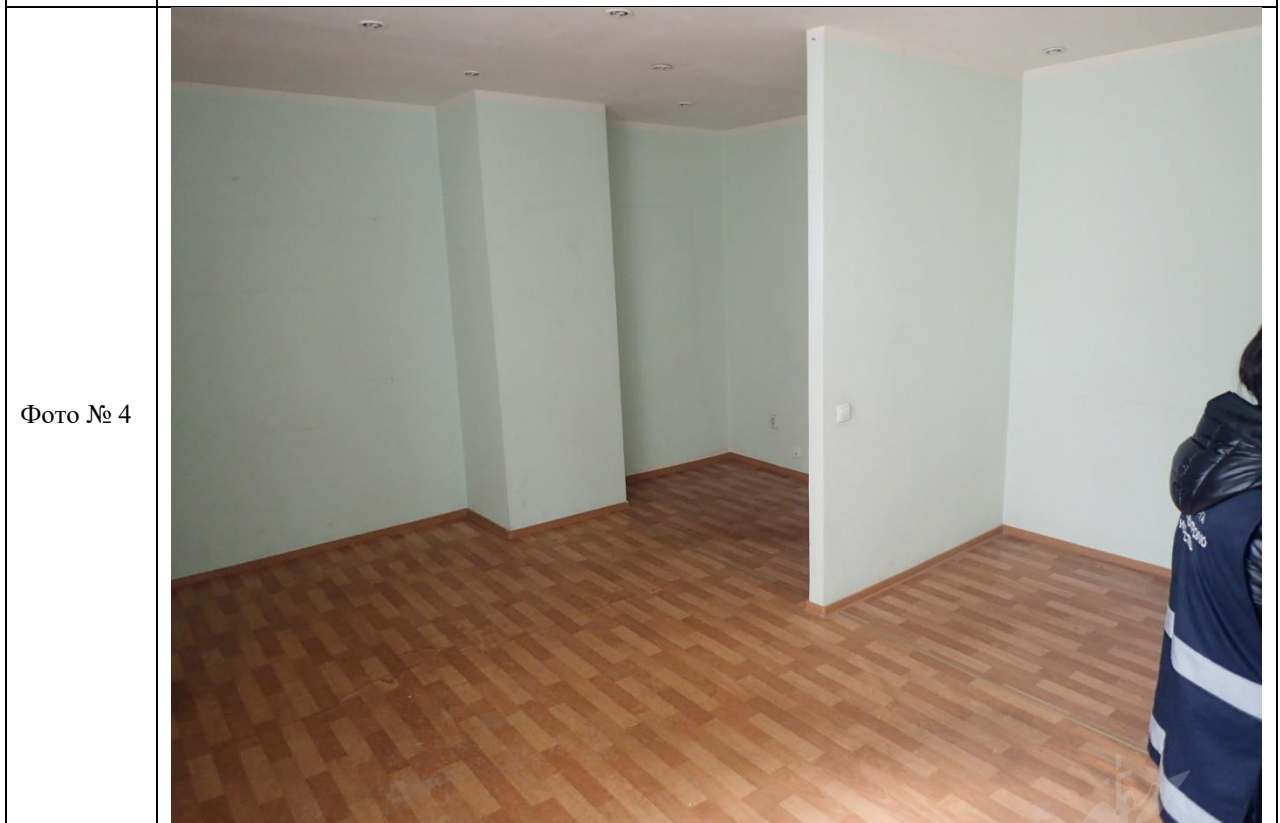
Описание: в ч.п. 2 Объекта возведена перегородка
