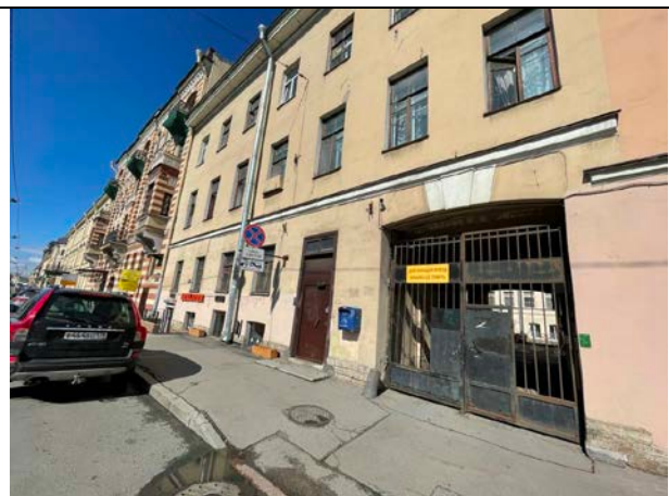
Фото 14. Вид здания расположения Объекта оценки
