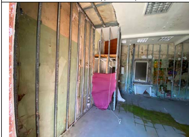
Фото № 9 – Внутреннее состояние помещения
