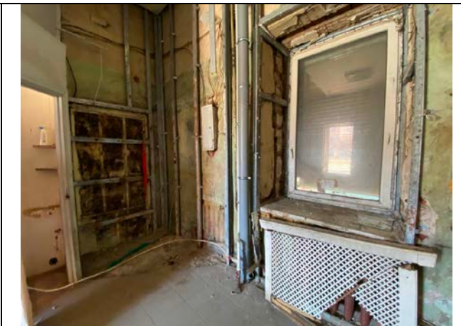
Фото № 12 – Внутреннее состояние помещения
