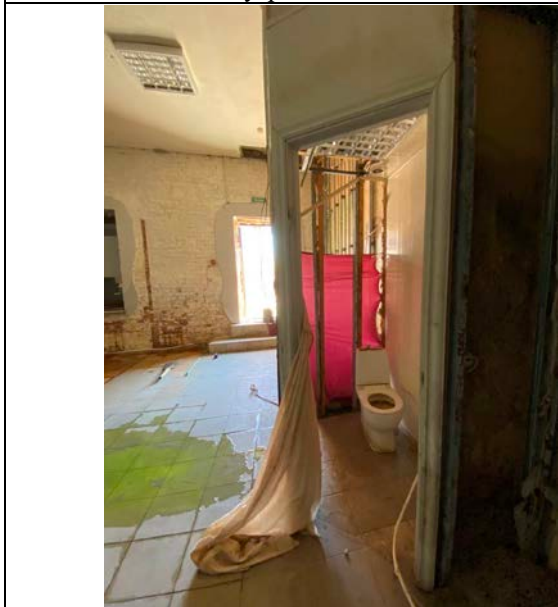
Фото № 13 – Внутреннее состояние помещения
