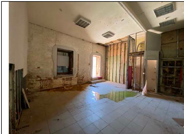
Фото № 11 – Внутреннее состояние помещения
