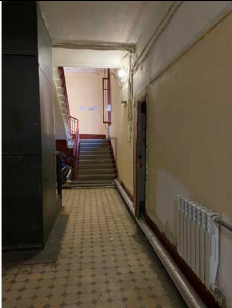
Фото № 9 – Вход в помещение (парадная)
