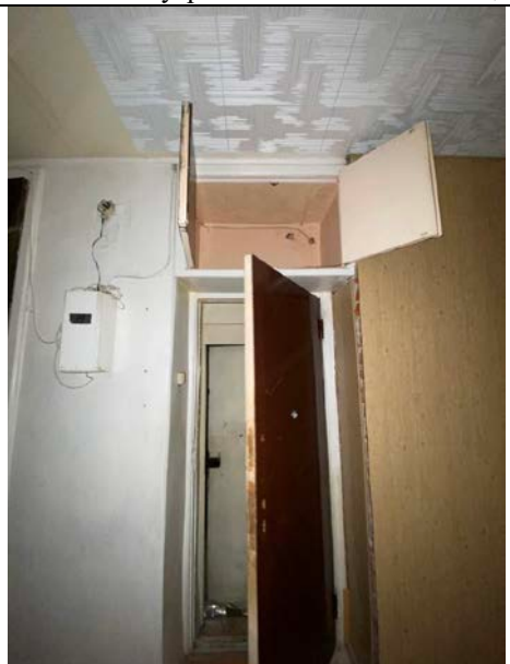
Фото № 16 – Внутреннее состояние помещения
