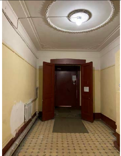
Фото № 8 – Вход в помещение (парадная)
