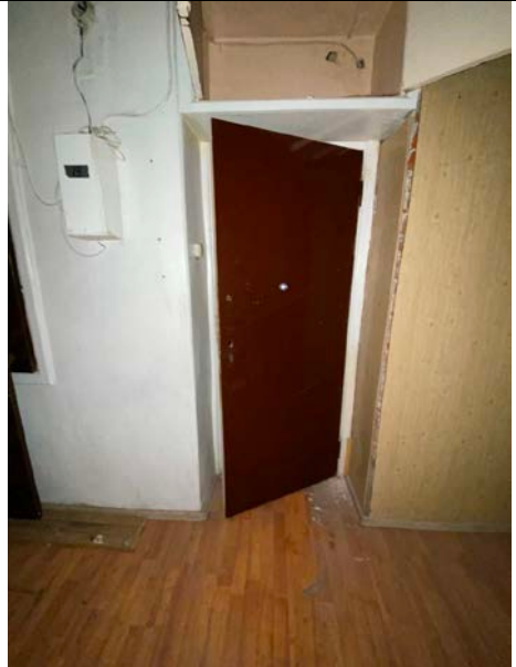
Фото № 14 – Внутреннее состояние помещения
