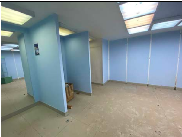
Фото № 25– Внутреннее состояние помещения
