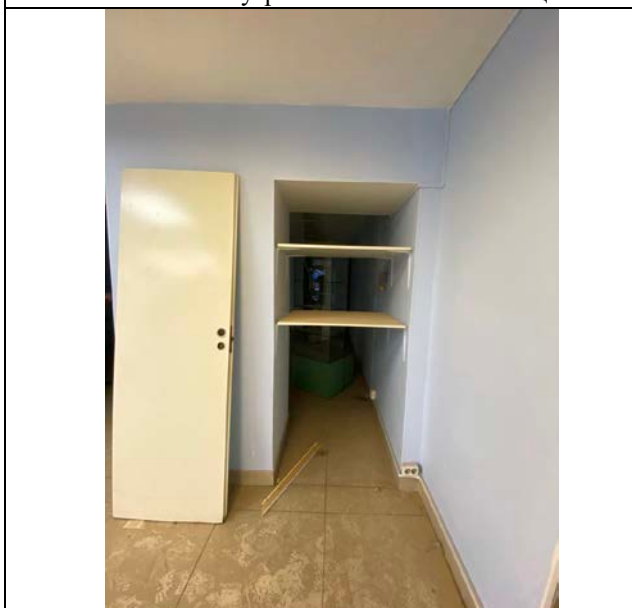
Фото № 13– Внутреннее состояние помещения
