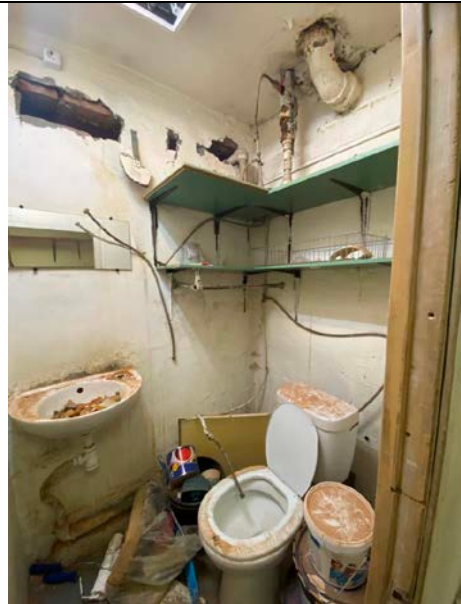
Фото № 16– Внутреннее состояние помещения
