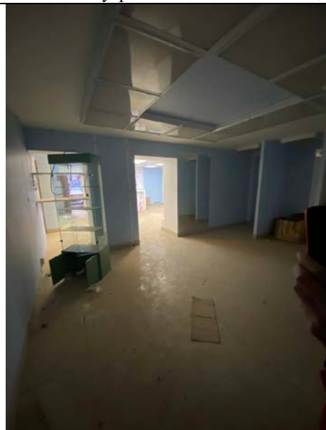
Фото № 18– Внутреннее состояние помещения
