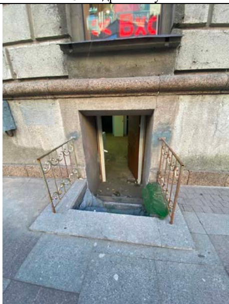
Фото № 7 – Вход в помещение (с улицы)
