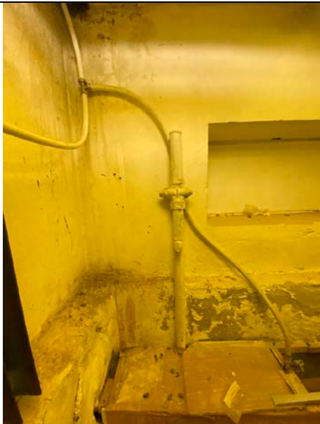
Фото № 23– Внутреннее состояние помещения
