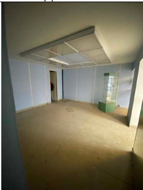
Фото № 19– Внутреннее состояние помещения
