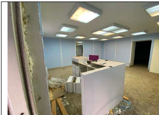
Фото № 9– Внутреннее состояние помещения
