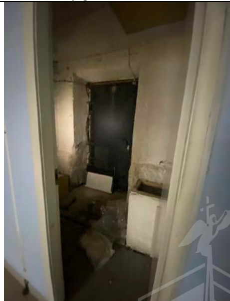
Фото № 20– Внутреннее состояние помещения
