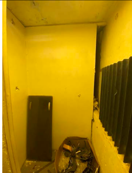
Фото № 22 – Внутреннее состояние помещения
