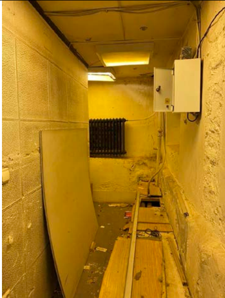
Фото № 21 – Внутреннее состояние помещения
