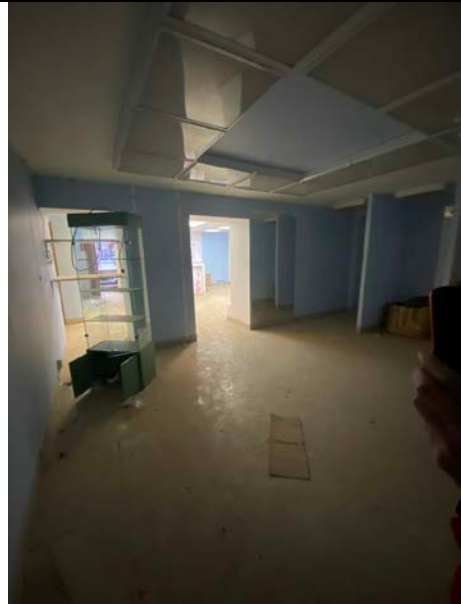
Фото № 18– Внутреннее состояние помещения
