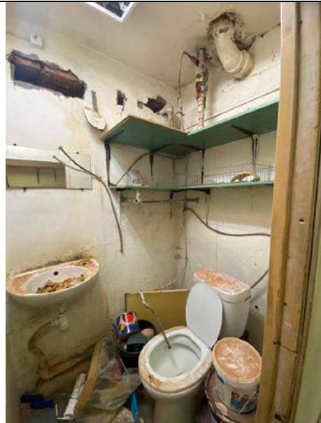
Фото № 16– Внутреннее состояние помещения
