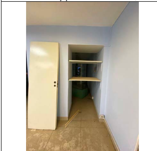
Фото № 13– Внутреннее состояние помещения
