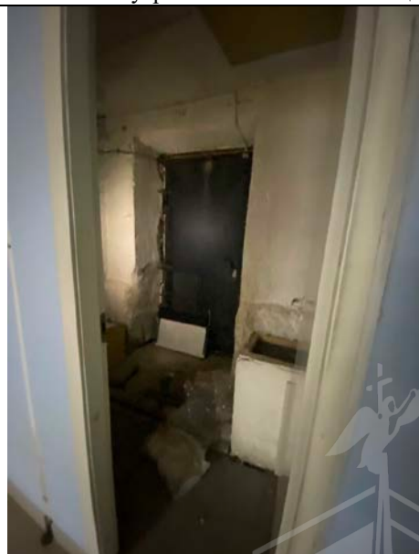
Фото № 20– Внутреннее состояние помещения
