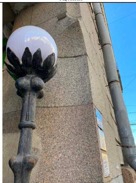
Фото № 6 – Элементы фасада здания
