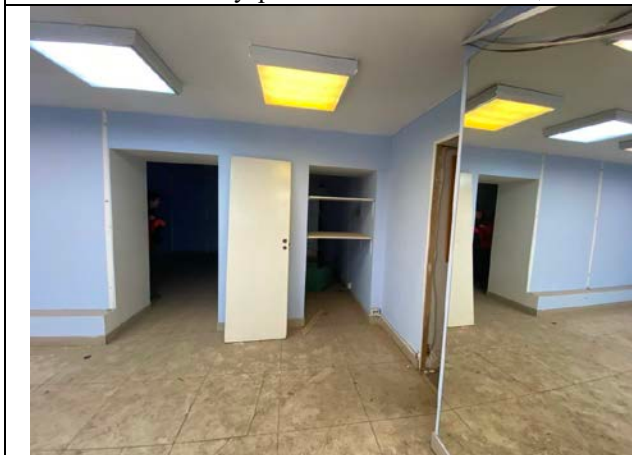
Фото № 11– Внутреннее состояние помещения
