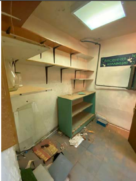
Фото № 15– Внутреннее состояние помещения
