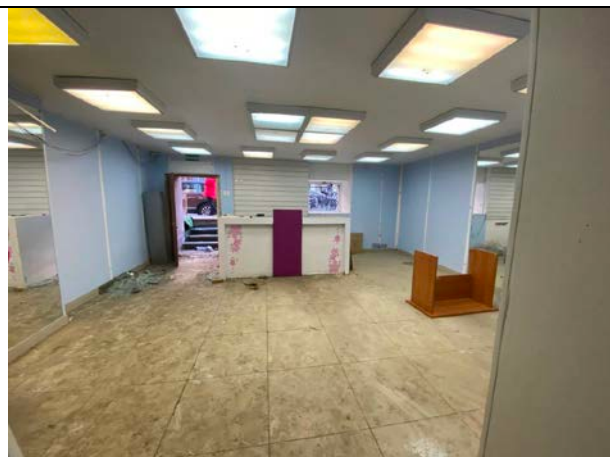
Фото № 10– Внутреннее состояние помещения
