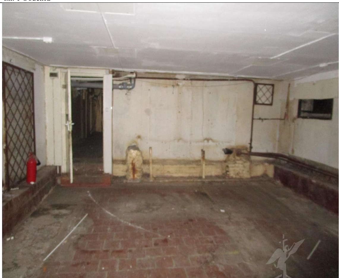
Описание: в ч.п. 1 Объекта оборудован оконный проем
