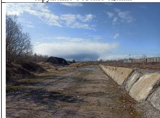
Фото 13. Вид на ближайшее окружение Объекта оценки
