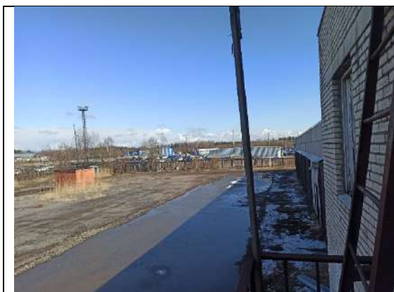
Фото 11. Вид территории и ближайшее окружение Объекта оценки
