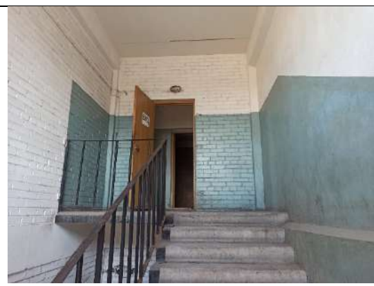
Фото 52. Лестница на 2 этаж административной части здания
