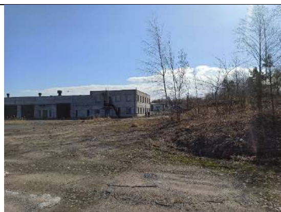
Фото 12. Вид территории и ближайшее окружение Объекта оценки
