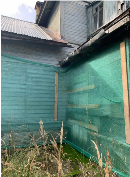
Фото 9. Общий вид и текущее состояние жилого дома в составе Объекта оценки.
