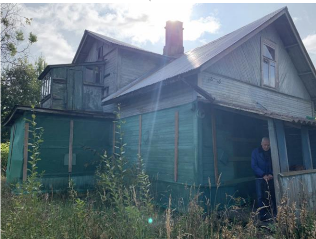
Фото 5. Общий вид и текущее состояние жилого дома в составе Объекта оценки.
