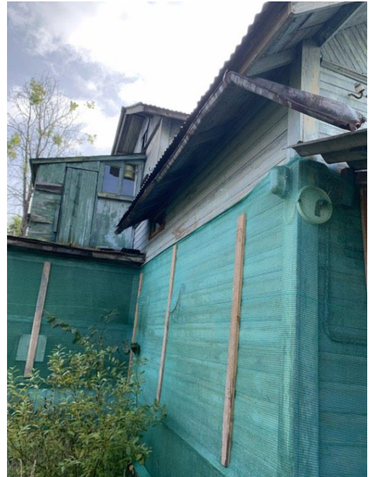
Фото 10. Общий вид и текущее состояние жилого дома в составе Объекта оценки.
