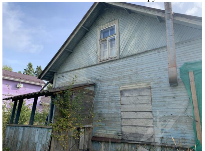
Фото 6. Общий вид и текущее состояние жилого дома в составе Объекта оценки.
