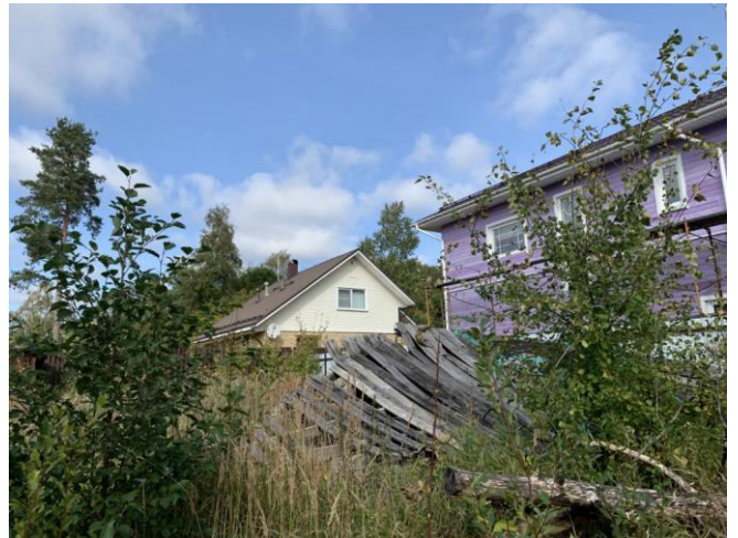
Фото 4. Вид на земельный участок в составе Объекта оценки и ближайшее окружение.
