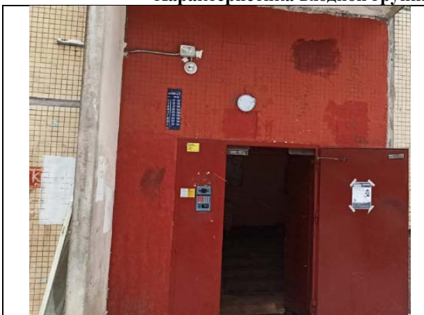
Фото 7. Общий вход Объекта оценки со двора
