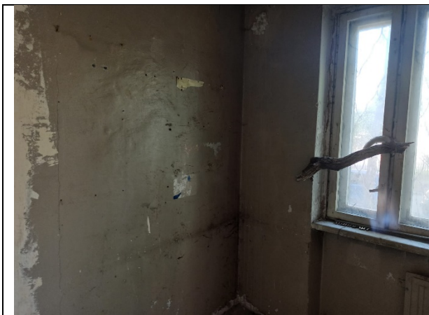
Фото 23. Внутреннее состояние Объекта оценки
