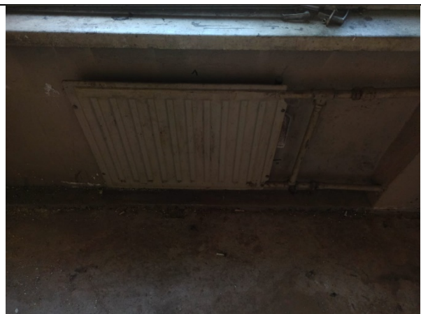
Фото 24. Внутреннее состояние Объекта оценки
