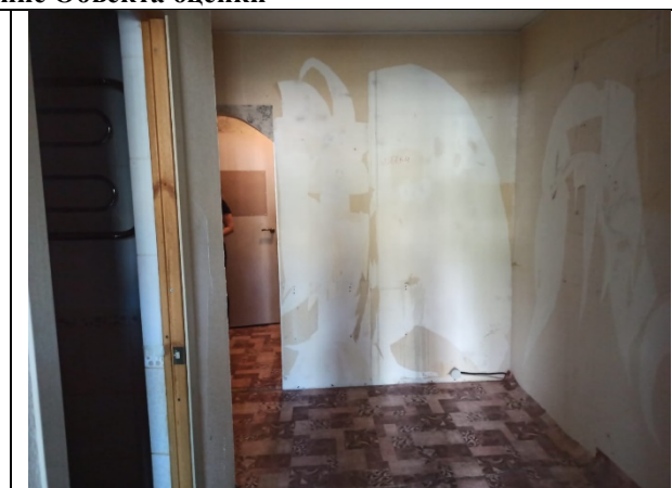
Фото 14. Внутреннее состояние Объекта оценки
