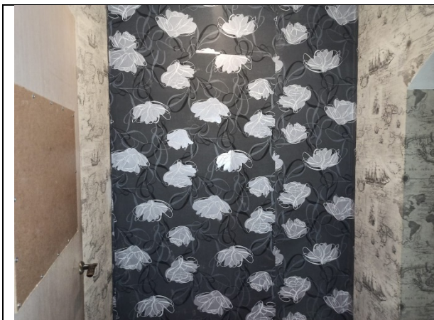
Фото 15. Внутреннее состояние Объекта оценки
