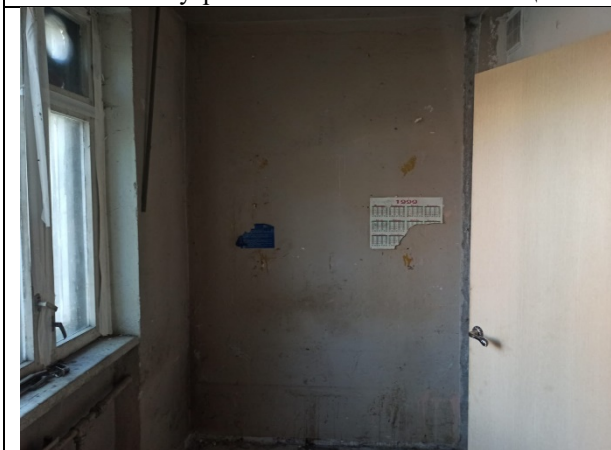
Фото 21. Внутреннее состояние Объекта оценки
