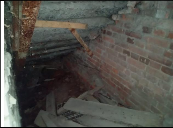
Фото 13. Внутреннее состояние Объекта оценки
