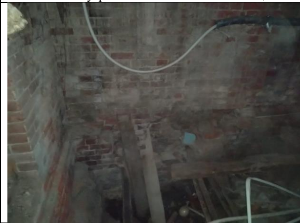
Фото 15. Внутреннее состояние Объекта оценки
