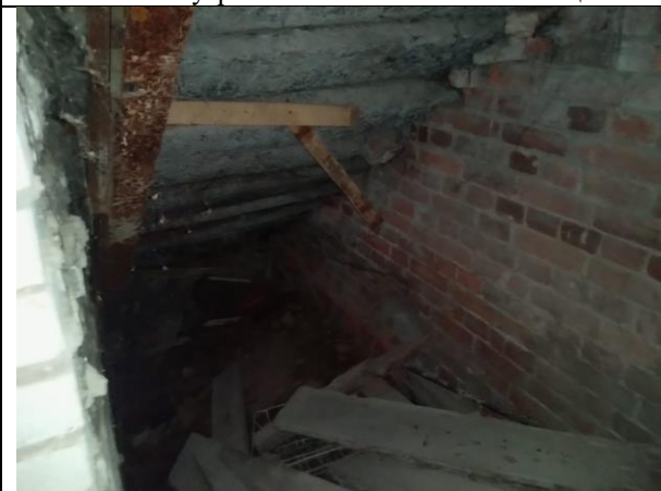
Фото 17. Внутреннее состояние Объекта оценки
