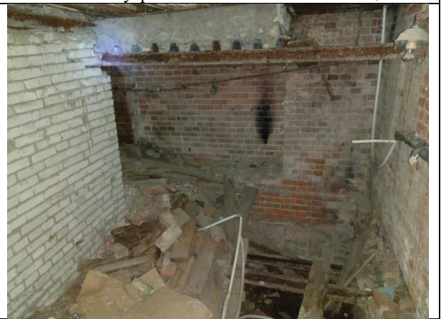
Фото 16. Внутреннее состояние Объекта оценки
