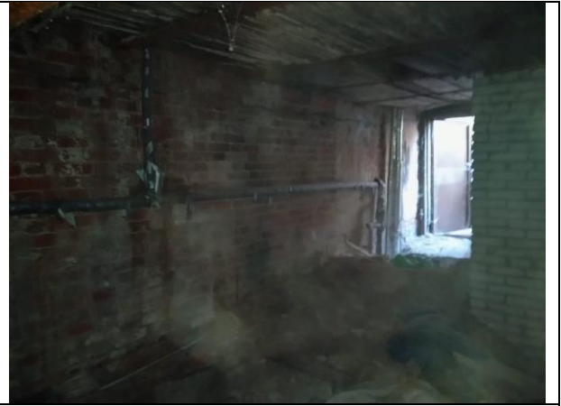
Фото 14. Внутреннее состояние Объекта оценки
