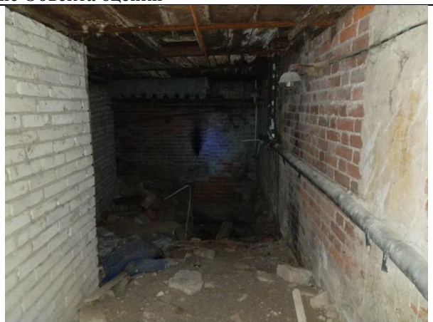
Фото 12. Внутреннее состояние Объекта оценки
