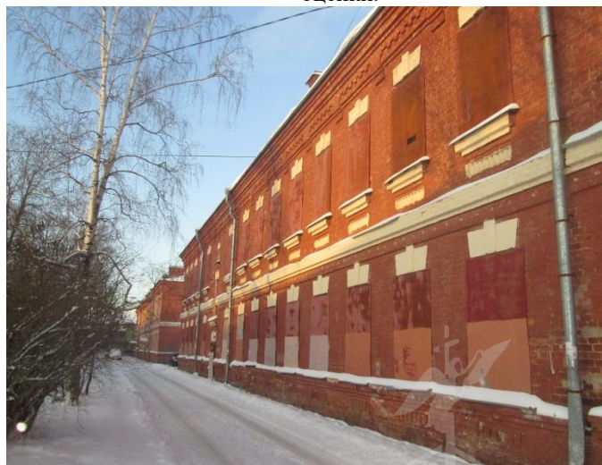
Фото 6. Вид на здание размещения Объекта оценки.
