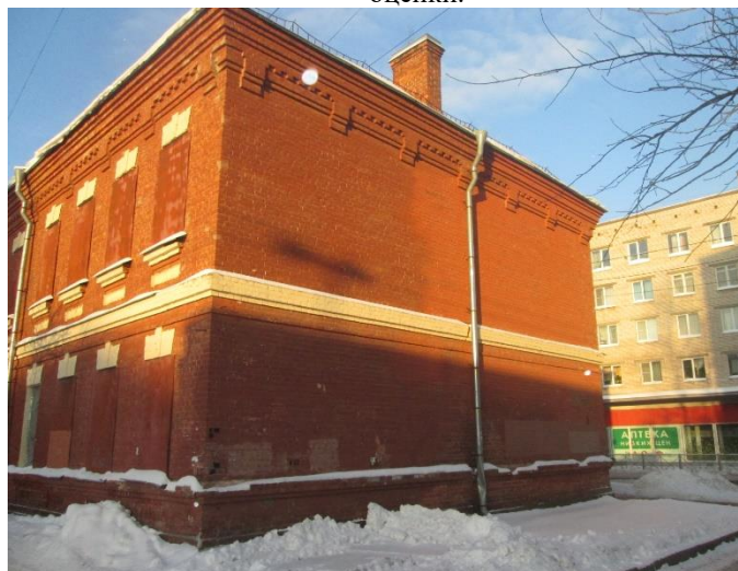
Фото 4. Вид на здание размещения Объекта оценки.
