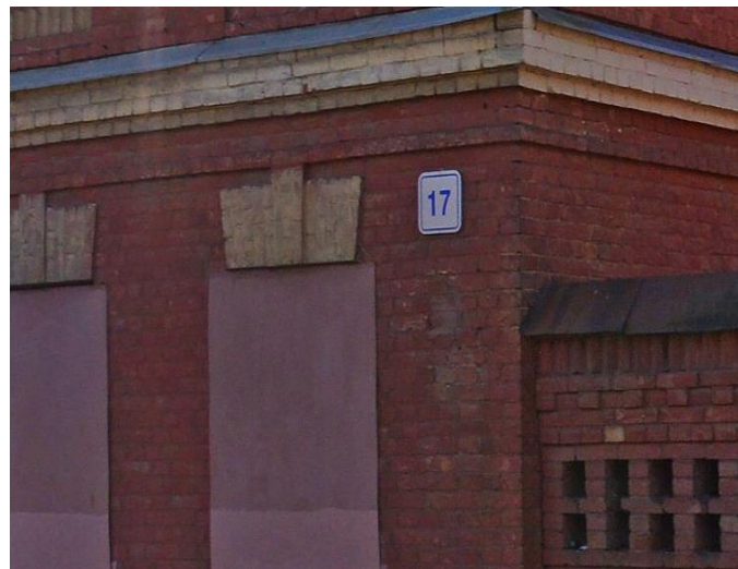
Фото 8. Номер дома на здании.
