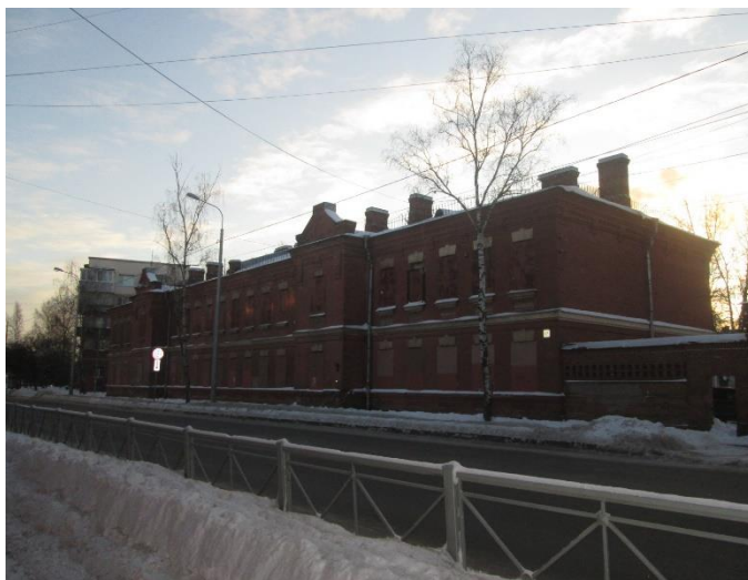
Фото 1. Вид на здание размещения Объекта оценки.
