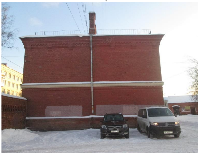
Фото 5. Вид на здание размещения Объекта оценки.
