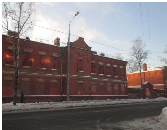
Фото 2. Вид на здание размещения Объекта оценки.
