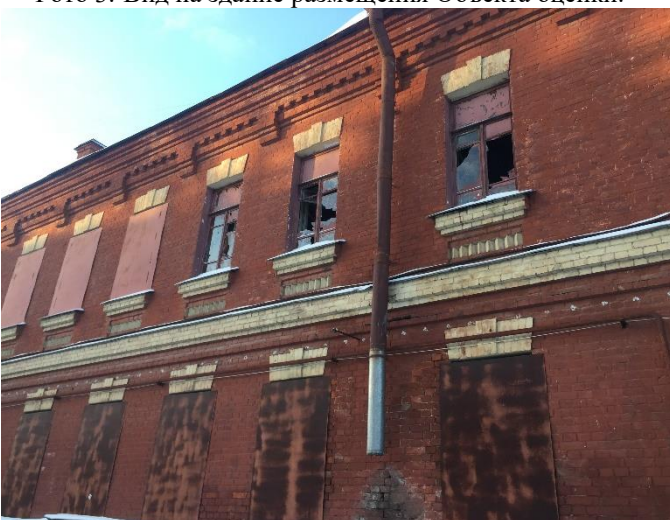
Фото 5. Вид на здание размещения Объекта оценки.
