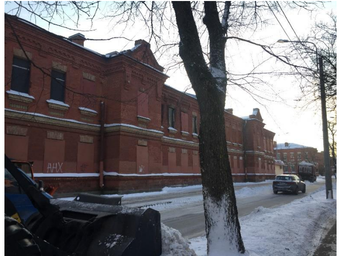
Фото 2. Вид на здание размещения Объекта оценки.
