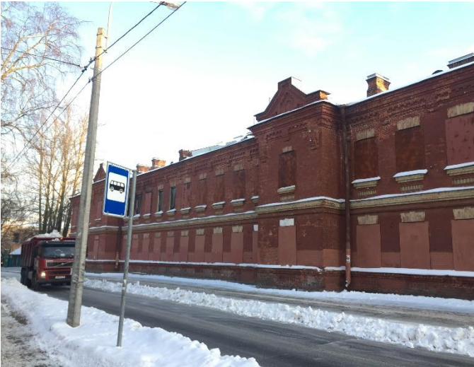
Фото 1. Вид на здание размещения Объекта оценки.
