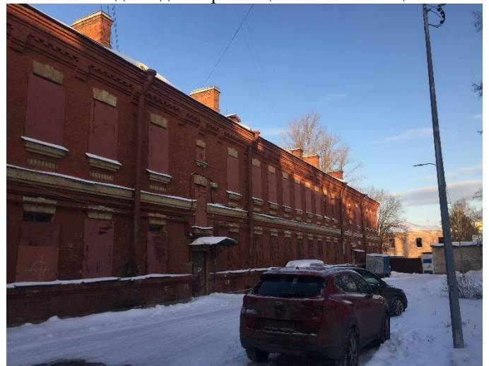
Фото 4. Вид на здание размещения Объекта оценки.
