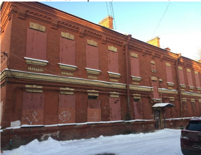
Фото 3. Вид на здание размещения Объекта оценки.
