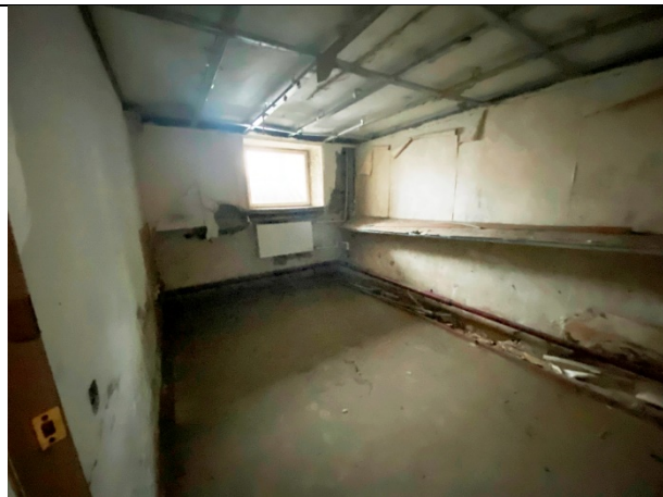
Фото № 20 – Внутреннее состояние помещения
