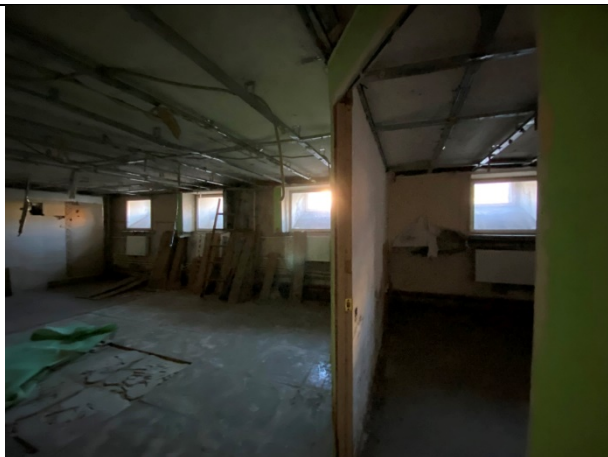
Фото № 19 – Внутреннее состояние помещения
