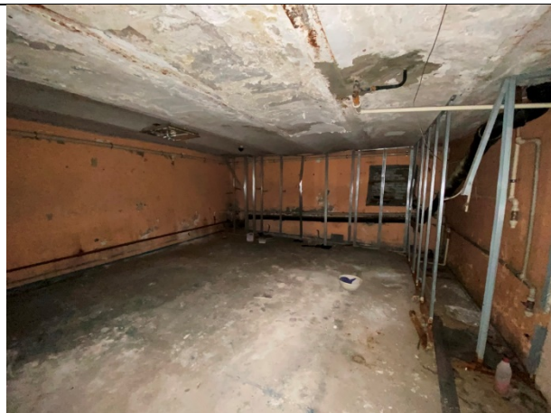
Фото № 14 – Внутреннее состояние помещения
