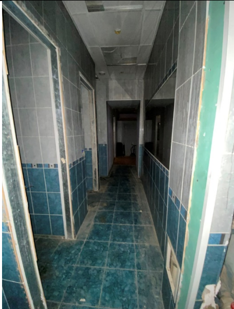
Фото № 9 – Внутреннее состояние помещения
