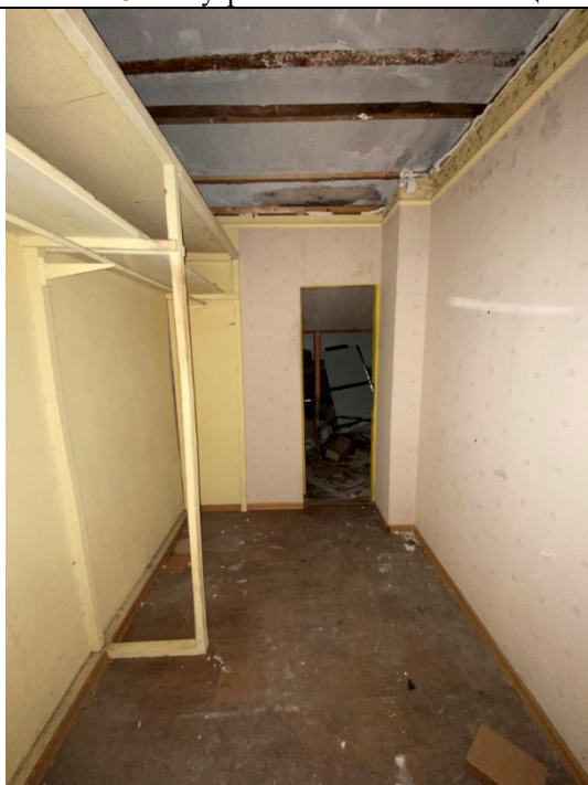
Фото № 17 – Внутреннее состояние помещения
