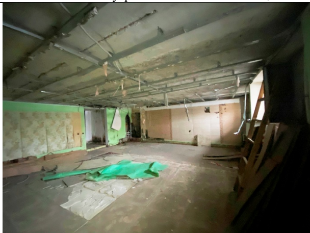
Фото № 21 – Внутреннее состояние помещения
