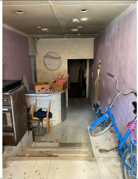
Фото № 8 – Внутреннее состояние помещения
