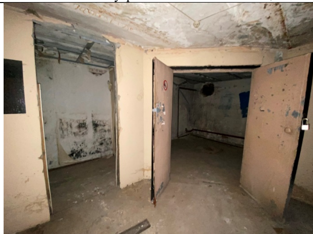
Фото № 16 – Внутреннее состояние помещения
