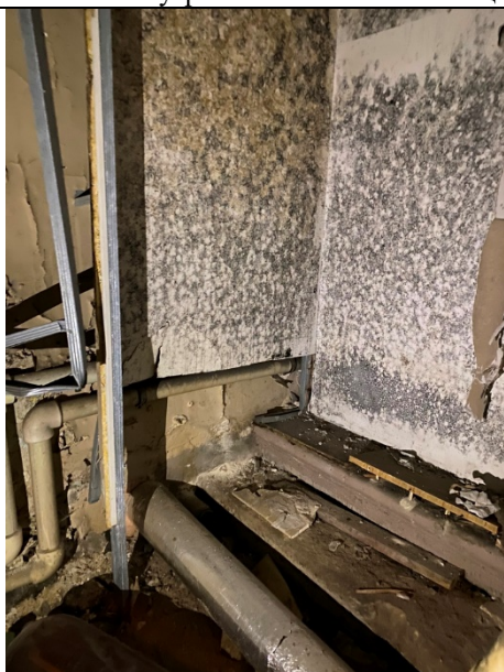
Фото № 23 – Внутреннее состояние помещения
