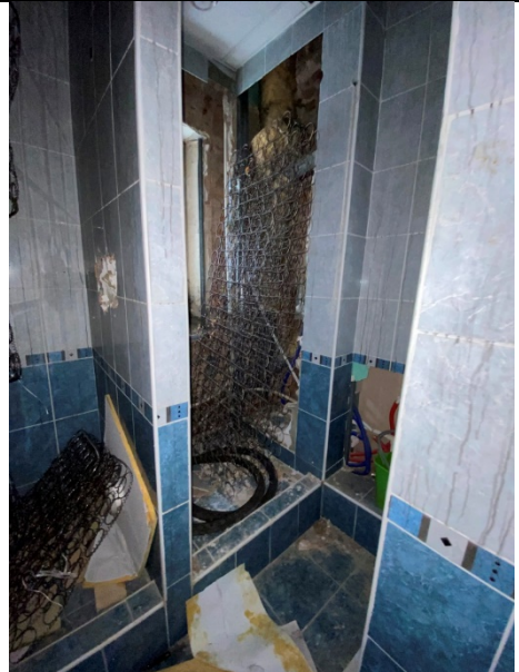
Фото № 10 – Внутреннее состояние помещения
