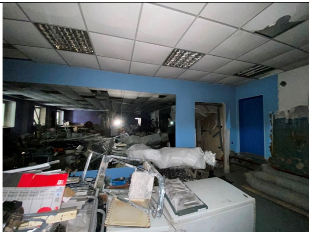
Фото № 13 – Внутреннее состояние помещения
