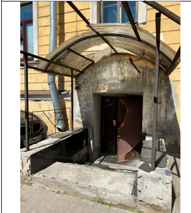
Фото № 5 – Вход в помещение
