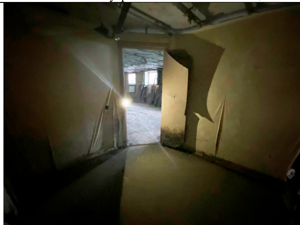
Фото № 22 – Внутреннее состояние помещения
