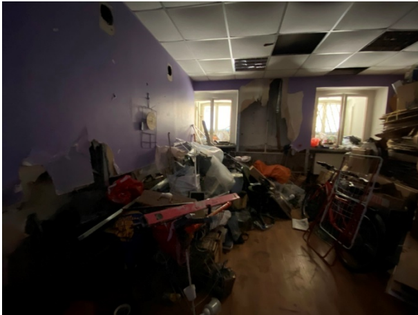
Фото № 7 – Внутреннее состояние помещения
