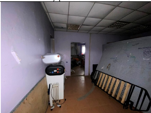
Фото № 11 – Внутреннее состояние помещения
