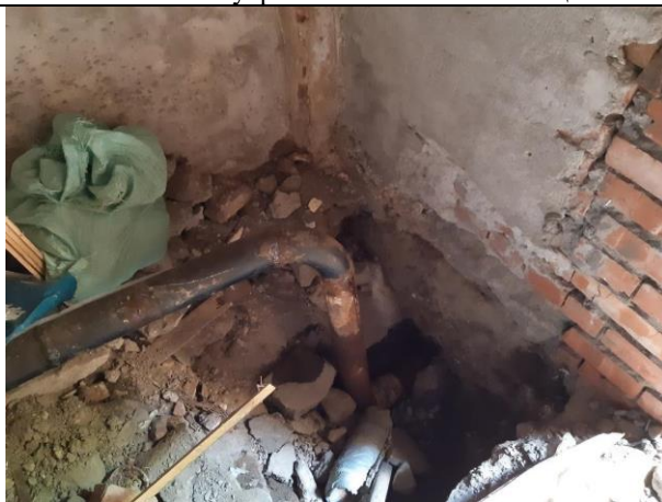
Фото № 11 – Внутреннее состояние помещения
