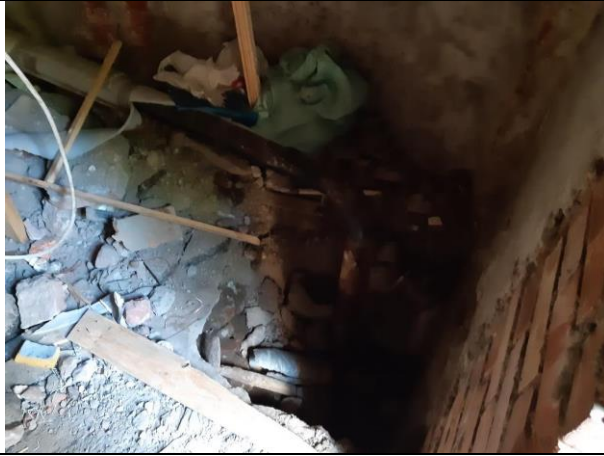
Фото № 7 – Внутреннее состояние помещения
