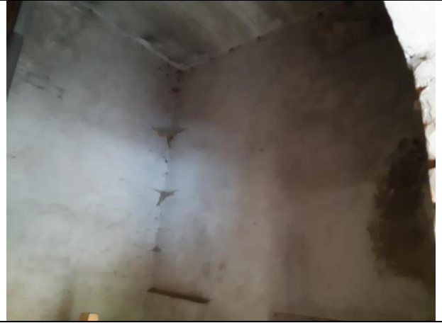
Фото № 8 – Внутреннее состояние помещения
