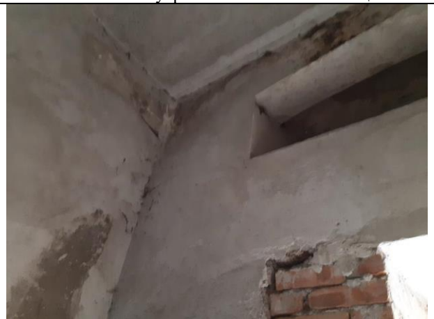
Фото № 12 – Внутреннее состояние помещения
