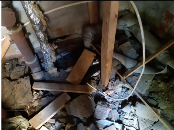
Фото № 9 – Внутреннее состояние помещения
