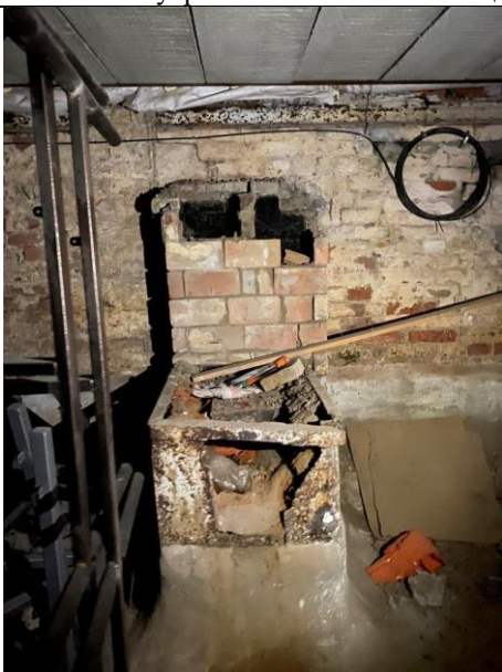
Фото № 17 – Внутреннее состояние помещения
