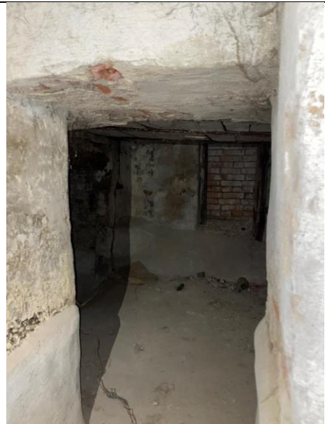
Фото № 12 – Внутреннее состояние помещения
