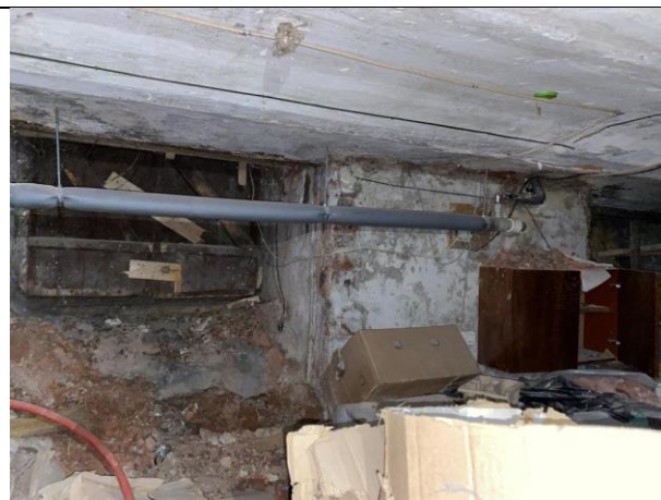
Фото № 22 – Внутреннее состояние помещения
