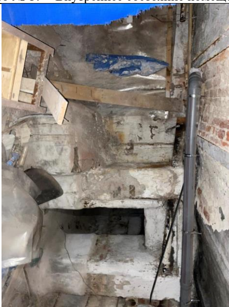
Фото № 19 – Внутреннее состояние помещения
