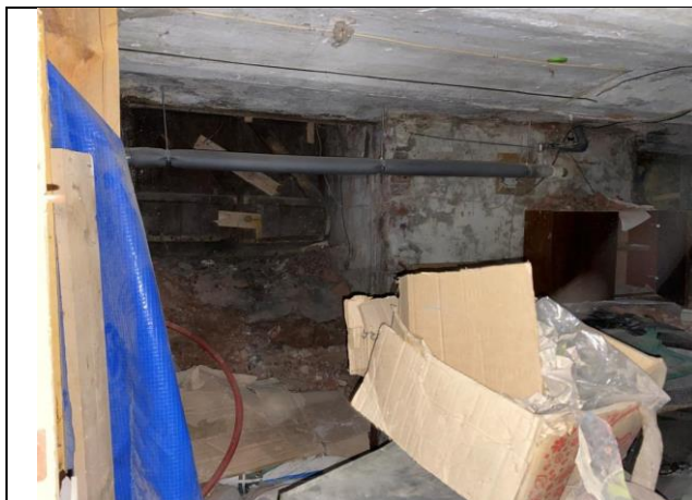
Фото № 21 – Внутреннее состояние помещения
