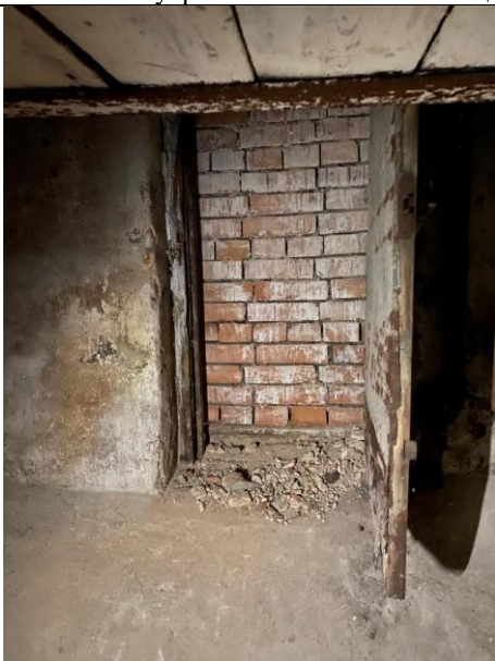
Фото № 13 – Внутреннее состояние помещения
