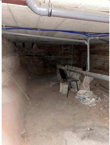
Фото № 16 – Внутреннее состояние помещения
