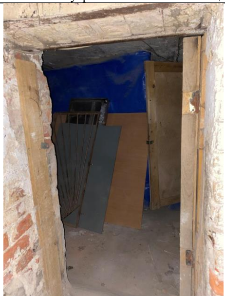
Фото № 18 – Внутреннее состояние помещения
