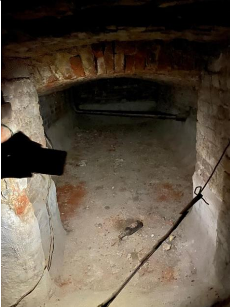
Фото № 15 – Внутреннее состояние помещения
