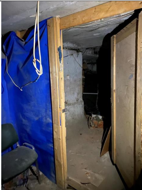
Фото № 11 – Внутреннее состояние помещения
