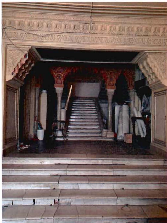
7. Лестница с Литейного пр. в кв. 12. Фрагмент.
