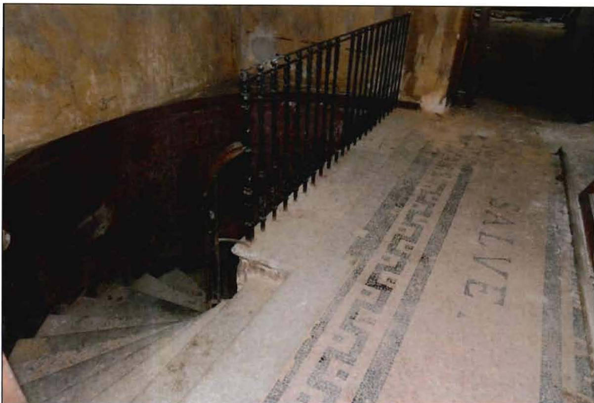
6. Интерьер объекта культурного наследия. Фрагмент. Помещение 5ЛК.
