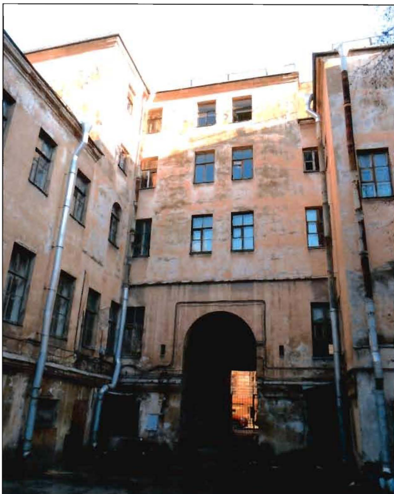
4. Фасады восточного двора объекта культурного наследия.
