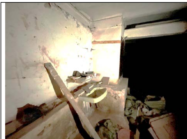
Фото 68. Типичное состояние Объекта оценки
