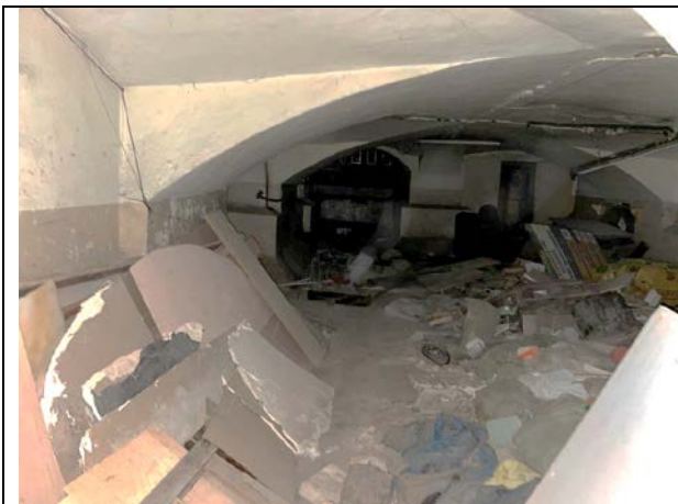
Фото 45. Типичное состояние Объекта оценки
