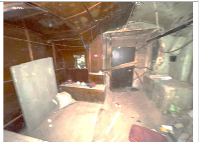
Фото 50. Типичное состояние Объекта оценки
