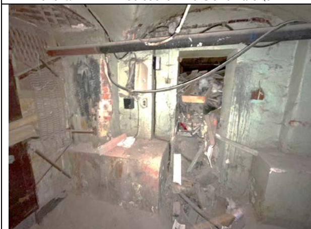
Фото 51. Типичное состояние Объекта оценки
