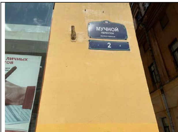
Фото 21. Адрес Объекта оценки
