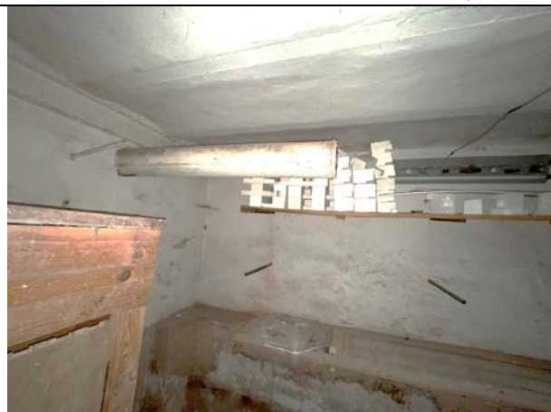
Фото 65. Типичное состояние Объекта оценки
