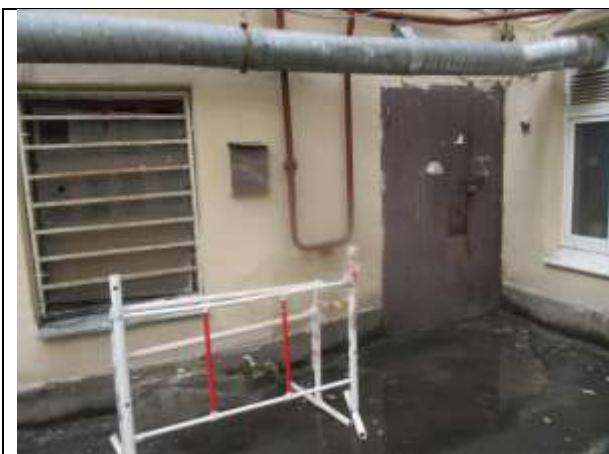
Фото 9.Окно Объекта оценки и отдельный вход со двора
