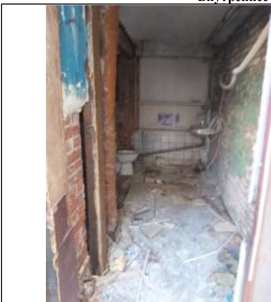
Фото 11. Внутреннее состояние Объекта оценки
