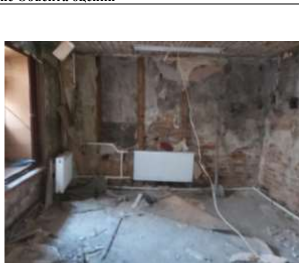
Фото 12. Внутреннее состояние Объекта оценки
