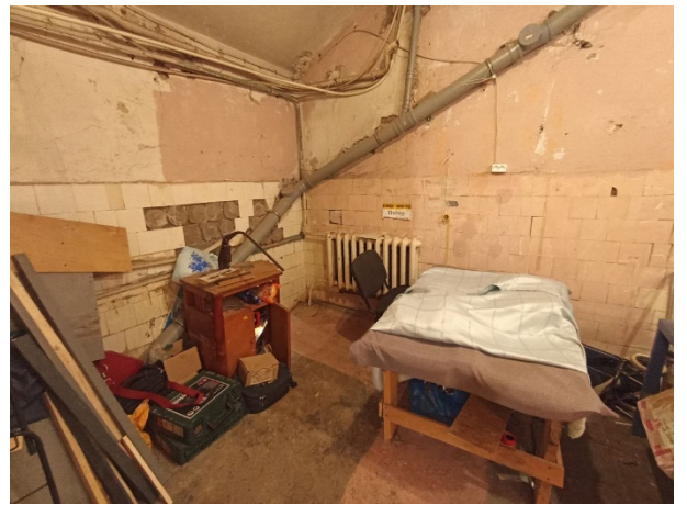
Фото № 16 – Внутреннее состояние помещения
