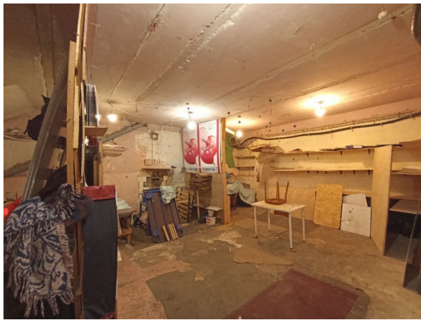
Фото № 15 – Внутреннее состояние помещения
