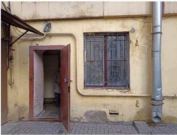
Фото № 9 – Вход в помещение
