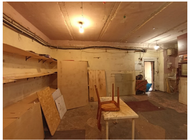
Фото № 10 – Внутреннее состояние помещения
