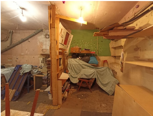
Фото № 11 – Внутреннее состояние помещения
