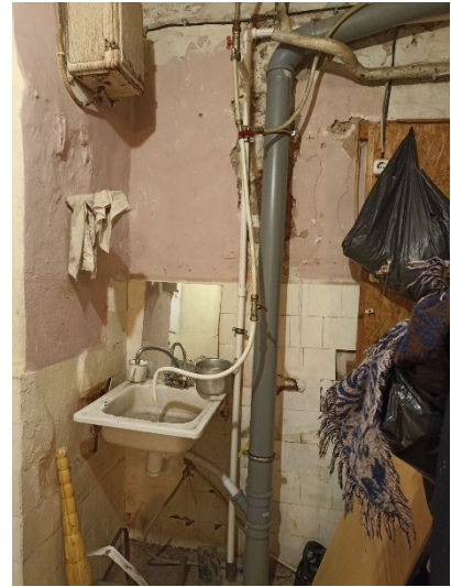
Фото № 14 – Внутреннее состояние помещения
