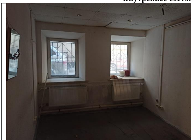
Фото 15. Внутреннее состояние Объекта оценки
