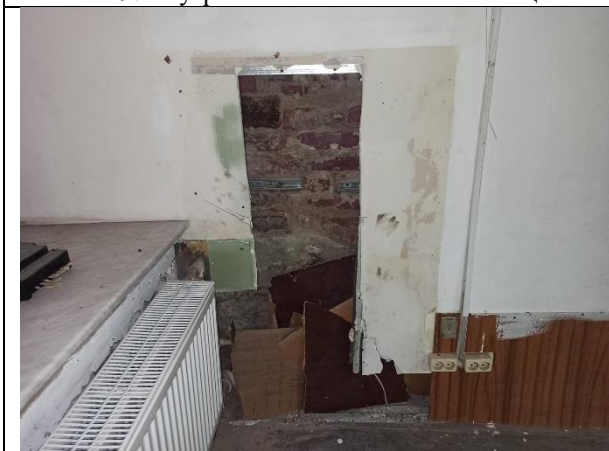
Фото 31. Внутреннее состояние Объекта оценки
