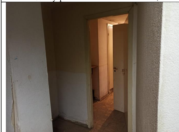
Фото 29. Внутреннее состояние Объекта оценки
