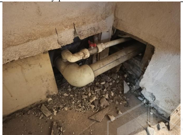
Фото 34. Внутреннее состояние Объекта оценки
