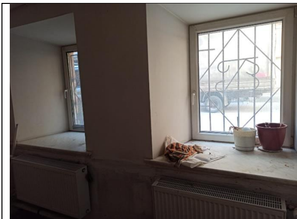
Фото 27. Внутреннее состояние Объекта оценки
