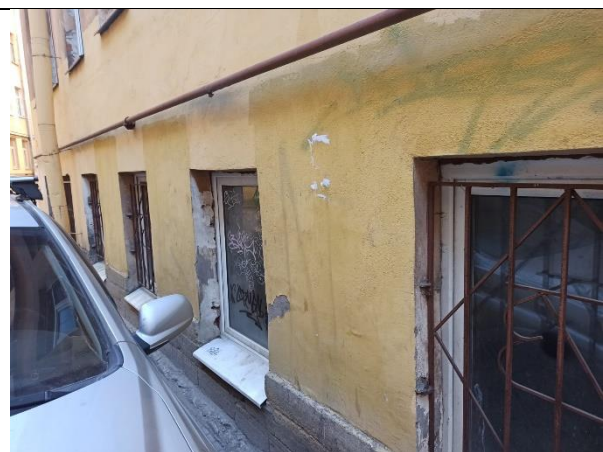
Фото 14. Вид окон Объекта оценки
