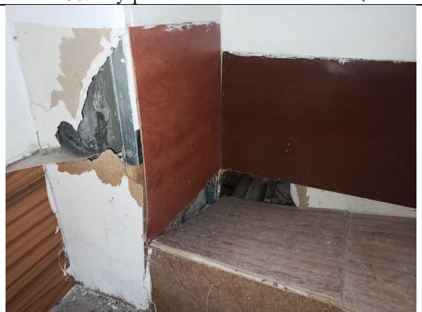
Фото 32. Внутреннее состояние Объекта оценки
