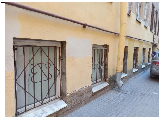
Фото 13. Вид окон Объекта оценки
