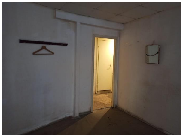
Фото 28. Внутреннее состояние Объекта оценки
