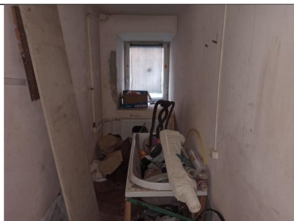
Фото 20. Внутреннее состояние Объекта оценки
