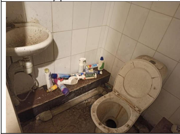
Фото 25. Внутреннее состояние Объекта оценки
