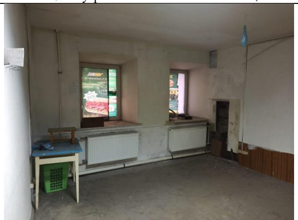
Фото 30. Внутреннее состояние Объекта оценки
