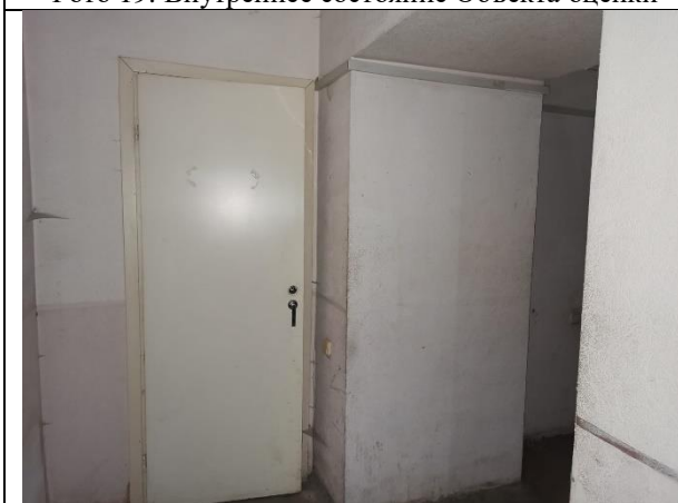
Фото 21. Внутреннее состояние Объекта оценки
