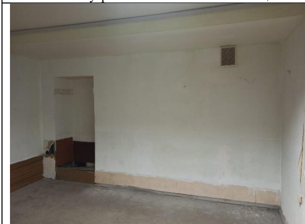
Фото 17. Внутреннее состояние Объекта оценки
