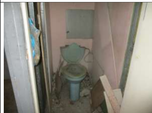
Фото 23. Внутреннее состояние Объекта оценки
