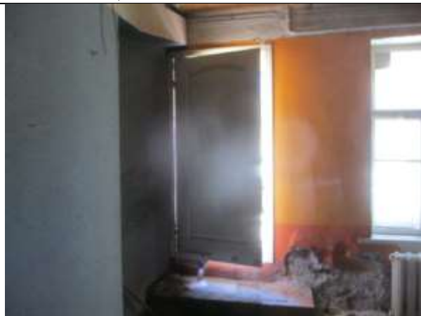
Фото 10. Внутреннее состояние Объекта оценки
