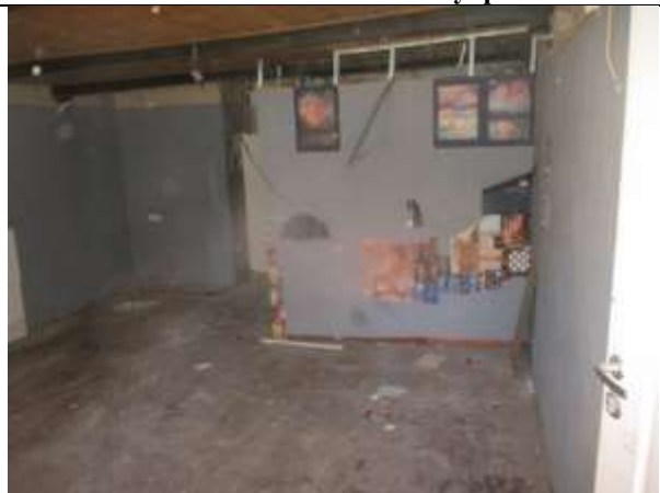
Фото 9. Внутреннее состояние Объекта оценки
