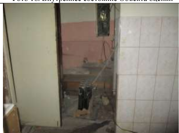
Фото 18. Внутреннее состояние Объекта оценки
