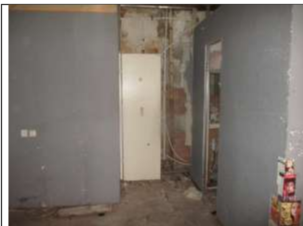
Фото 15. Внутреннее состояние Объекта оценки
