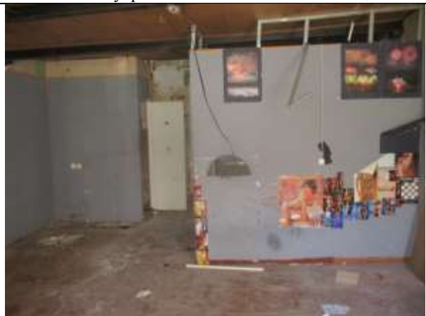
Фото 11. Внутреннее состояние Объекта оценки
