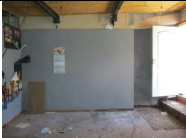
Фото 13. Внутреннее состояние Объекта оценки
