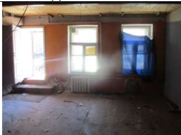
Фото 12. Внутреннее состояние Объекта оценки
