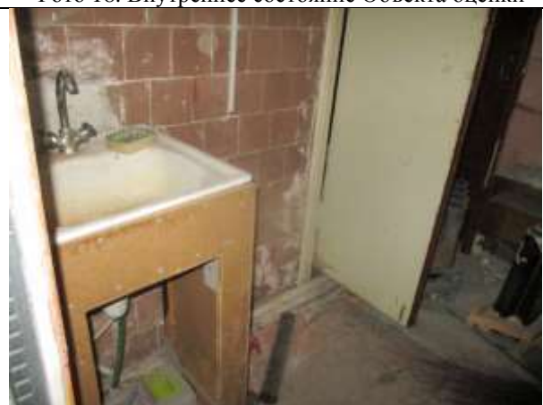
Фото 20. Внутреннее состояние Объекта оценки
