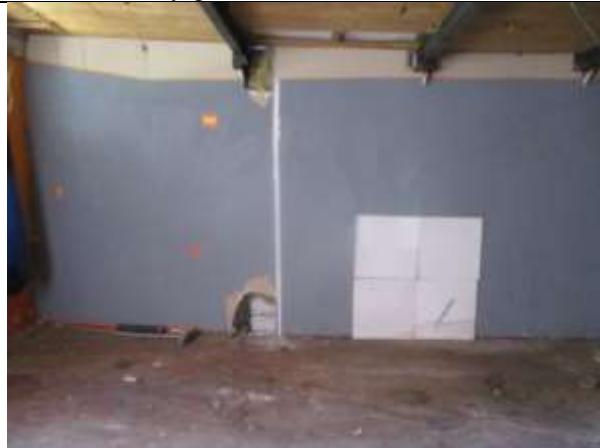
Фото 14. Внутреннее состояние Объекта оценки
