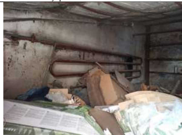
Фото 17. Внутреннее состояние соседнего пом. с Объектом оценки
