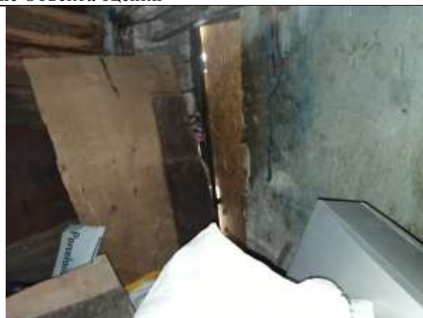
Фото 12. Внутреннее состояние Объекта оценки
