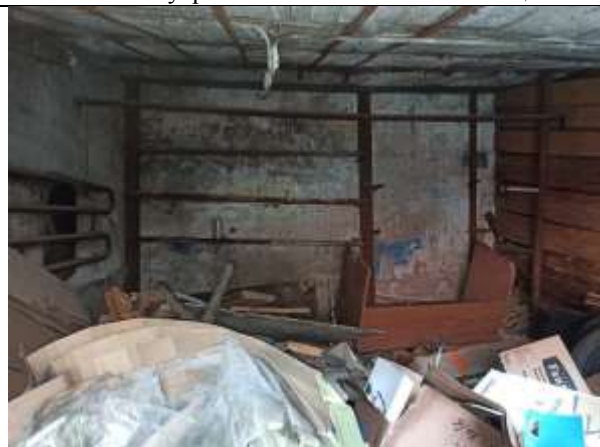
Фото 18. Внутреннее состояние Объекта оценки
