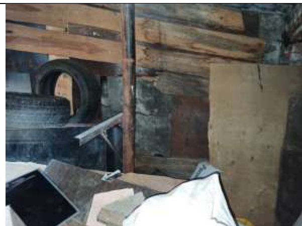
Фото 13. Внутреннее состояние Объекта оценки
