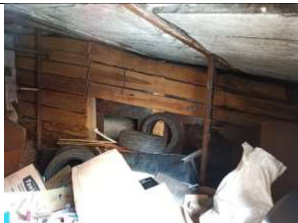
Фото 14. Внутреннее состояние Объекта оценки
