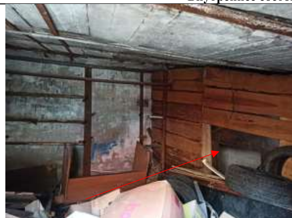
Фото 11. Внутреннее состояние Объекта оценки
