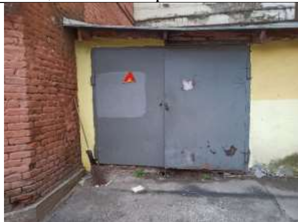
Фото 8. Отдельный вход со двора пом. 2-Н (через который осуществляется доступ в Объект оценки)
