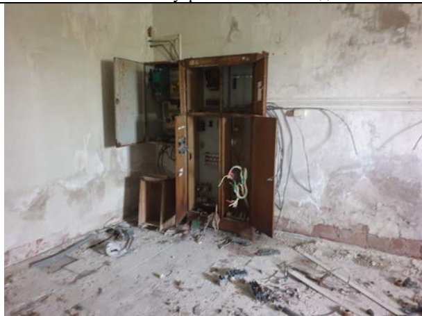
Фото № 33. Внутреннее состояние здания
