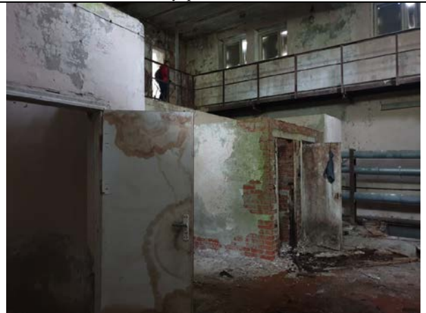
Фото № 26. Внутреннее состояние здания
