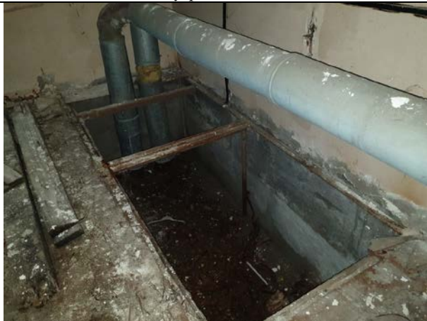
Фото № 25. Внутреннее состояние здания
