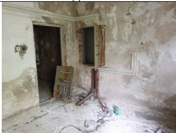
Фото № 35. Внутреннее состояние здания
