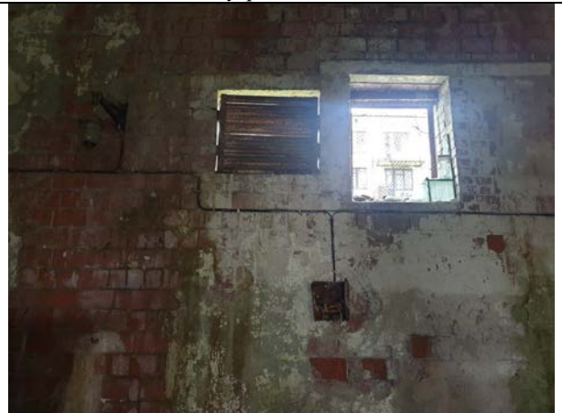
Фото № 18. Внутреннее состояние зданий
