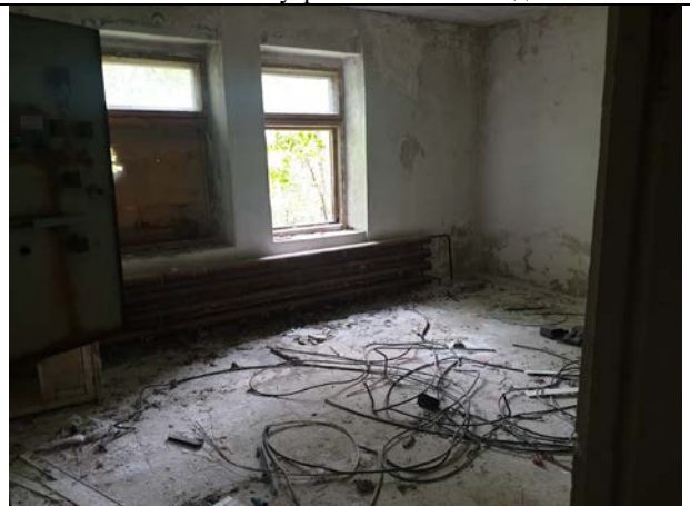
Фото № 34. Внутреннее состояние здания
