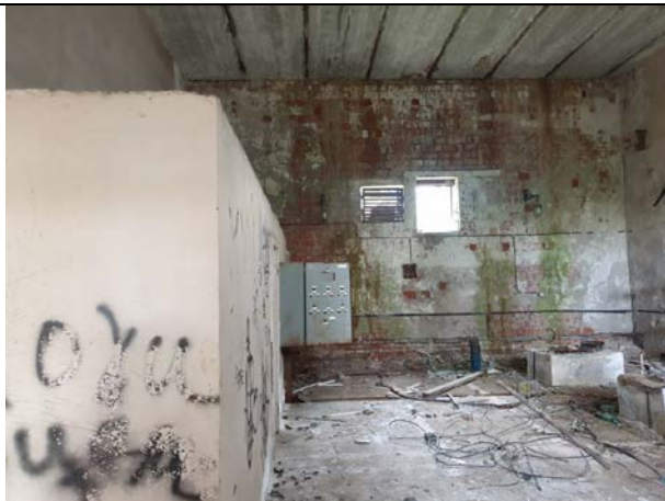
Фото № 13. Внутреннее состояние зданий
