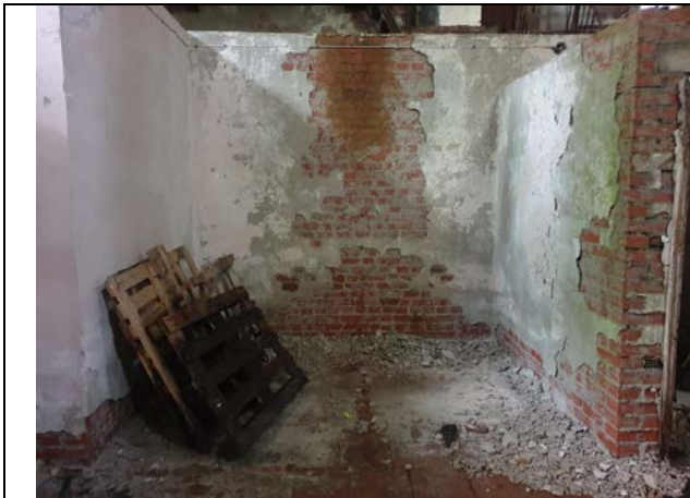
Фото № 29. Внутреннее состояние здания
