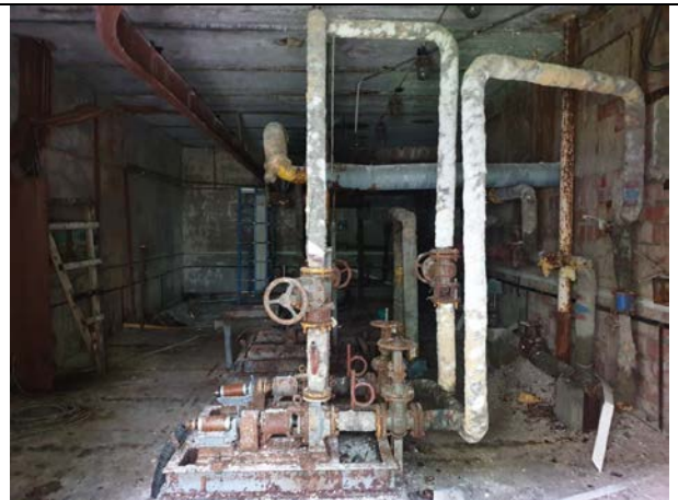
Фото № 22. Внутреннее состояние зданий
