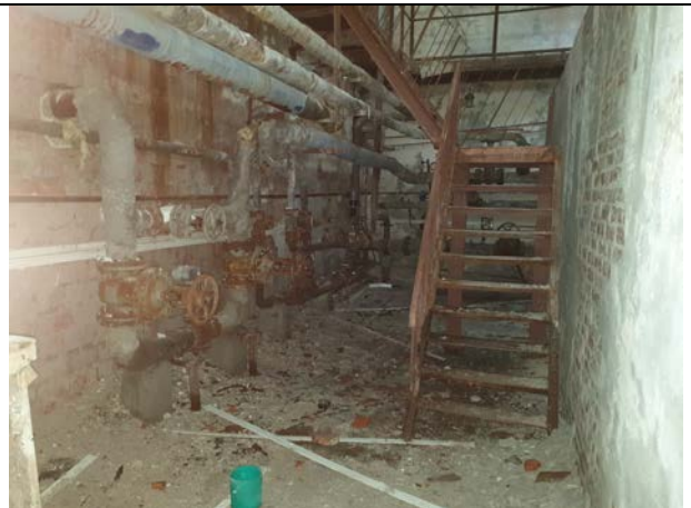
Фото № 30. Внутреннее состояние здания
