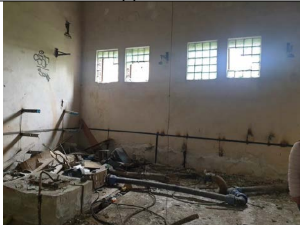
Фото № 15. Внутреннее состояние зданий
