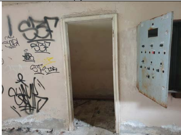
Фото № 17. Внутреннее состояние зданий
