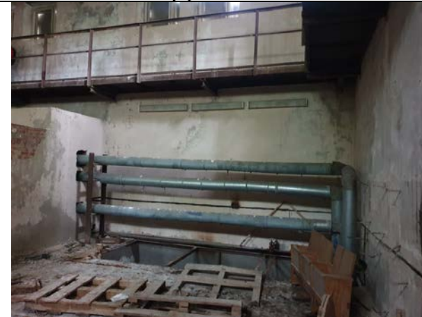
Фото № 27. Внутреннее состояние здания
