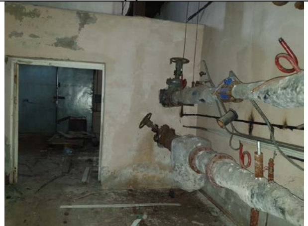
Фото № 24. Внутреннее состояние зданий
