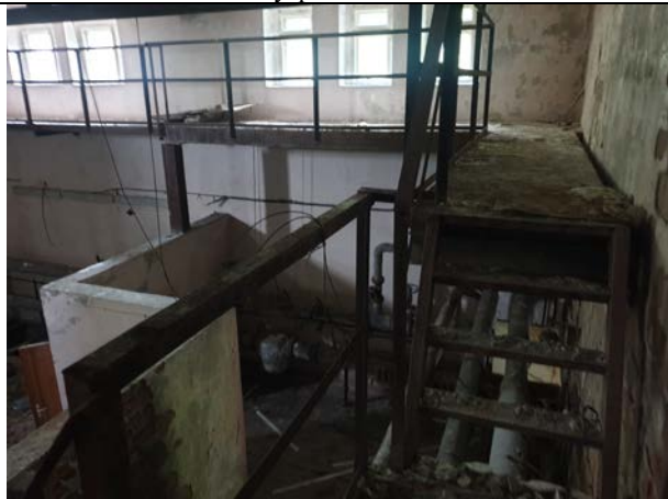
Фото № 31. Внутреннее состояние здания
