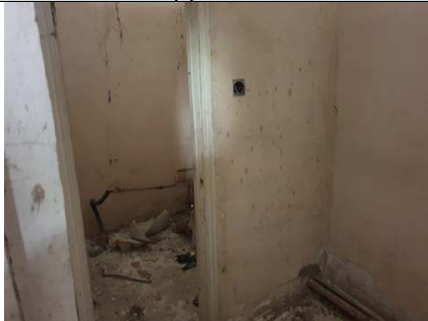
Фото № 19. Внутреннее состояние зданий
