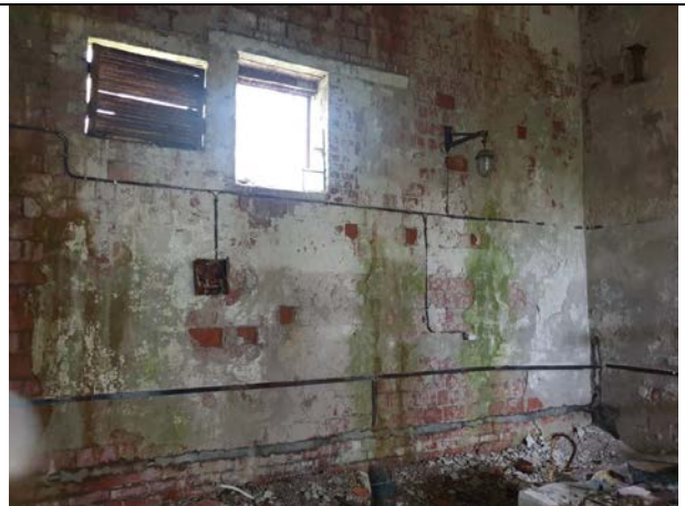
Фото № 14. Внутреннее состояние зданий
