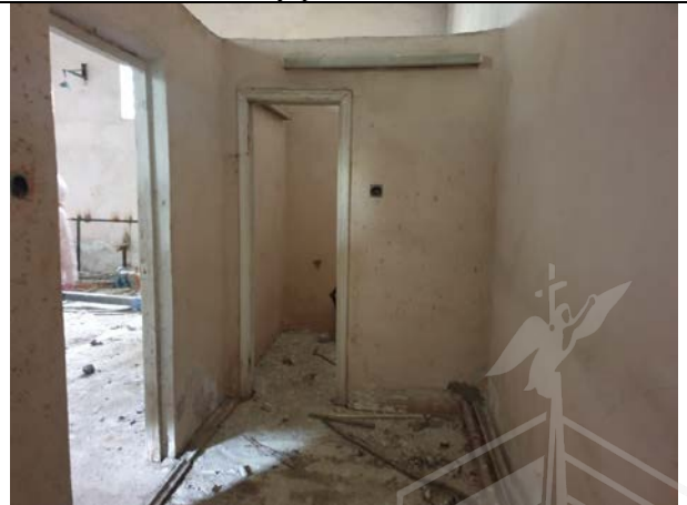
Фото № 20. Внутреннее состояние зданий
