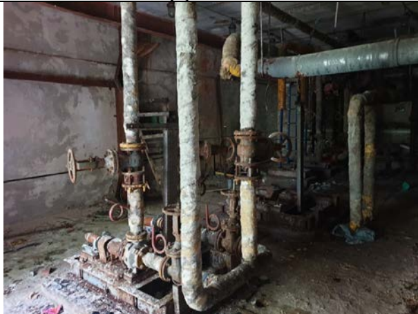
Фото № 23. Внутреннее состояние зданий
