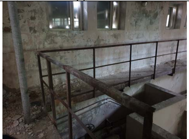
Фото № 32. Внутреннее состояние здания
