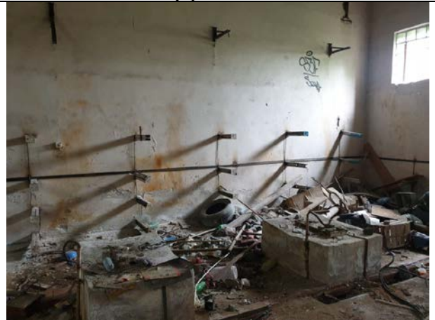
Фото № 16. Внутреннее состояние зданий
