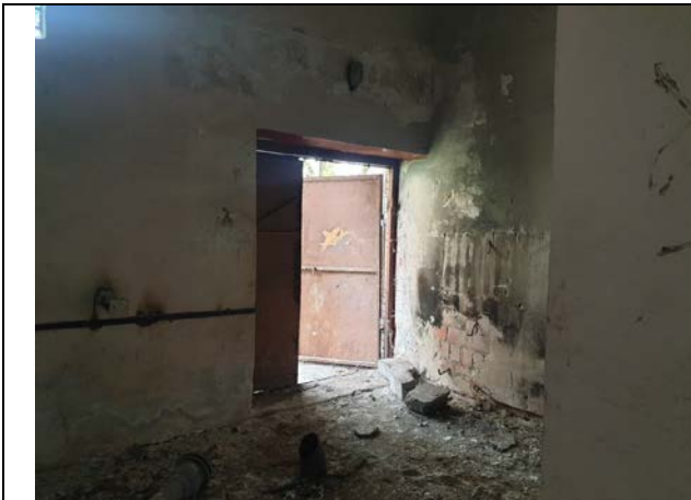
Фото № 21. Внутреннее состояние зданий
