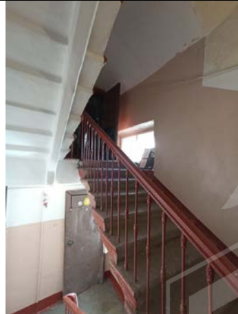
Фото № 14 – Лестничный марш
