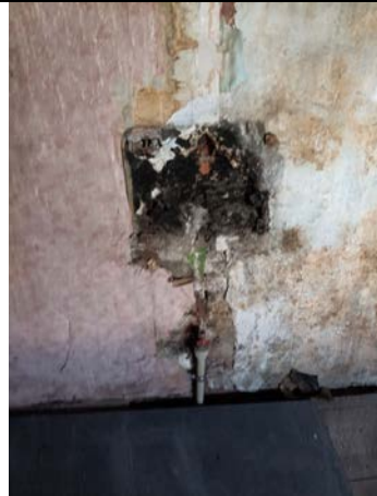
Фото № 10 – Внутреннее состояние помещения
