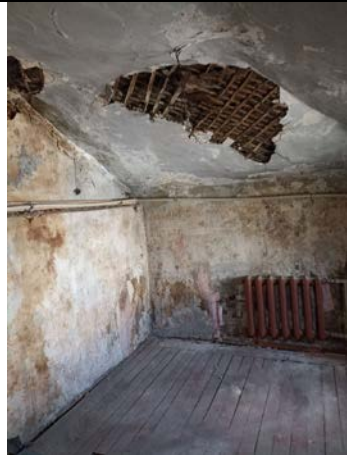
Фото № 9 – Внутреннее состояние помещения
