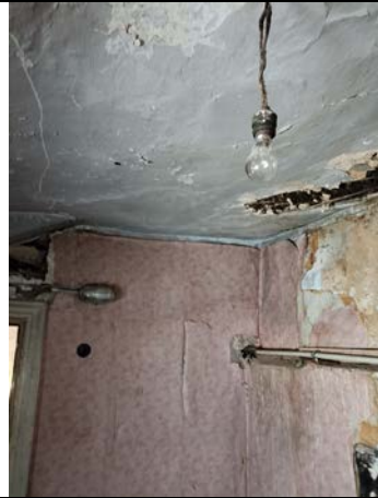
Фото № 12 – Внутреннее состояние помещения
