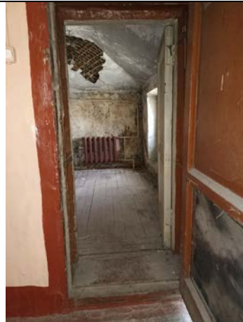
Фото № 8 – Вход в помещение
