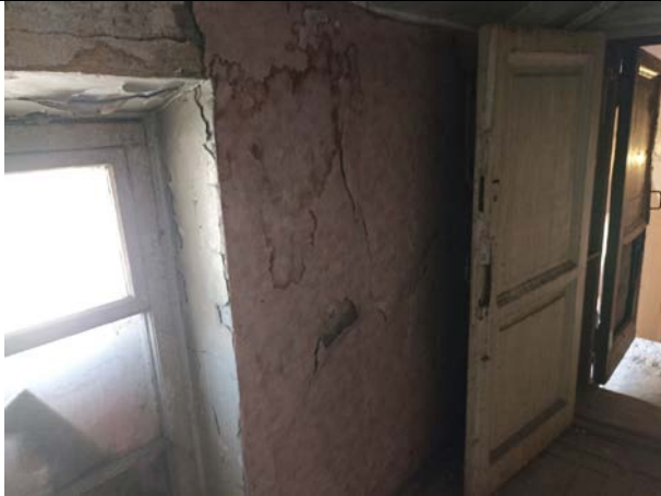
Фото № 13 – Внутреннее состояние помещения
