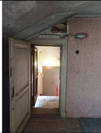
Фото № 11 – Внутреннее состояние помещения
