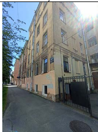
Фото № 4 – Здание, в котором находится объект оценки
