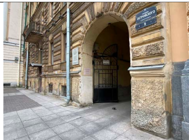
Фото № 5 – Вход в арку
