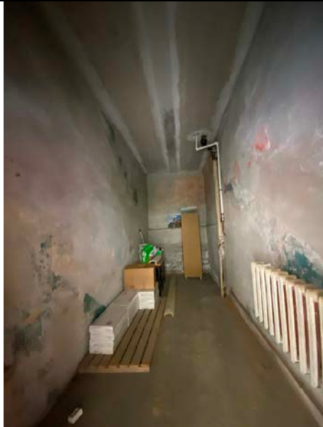
Фото № 9 – Внутреннее состояние помещения
