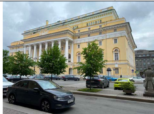
Фото № 1 – Ближайшее окружение и подъездные пути
