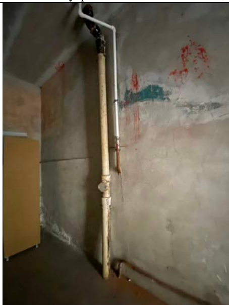
Фото № 11 – Внутреннее состояние помещения
