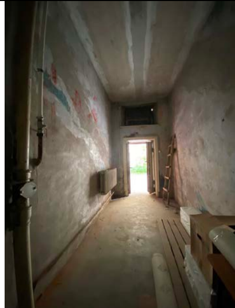
Фото № 10 – Внутреннее состояние помещения
