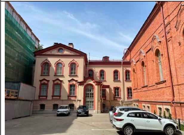
Фото 33. Внутри дворовая территория Объекта оценки
