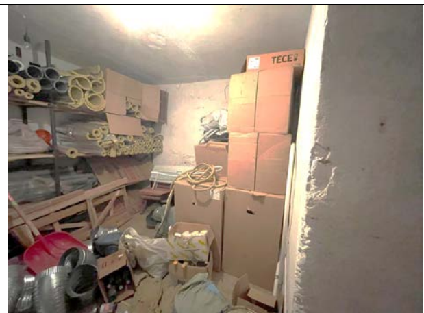
Фото 40. Типичное состояние Объекта оценки
