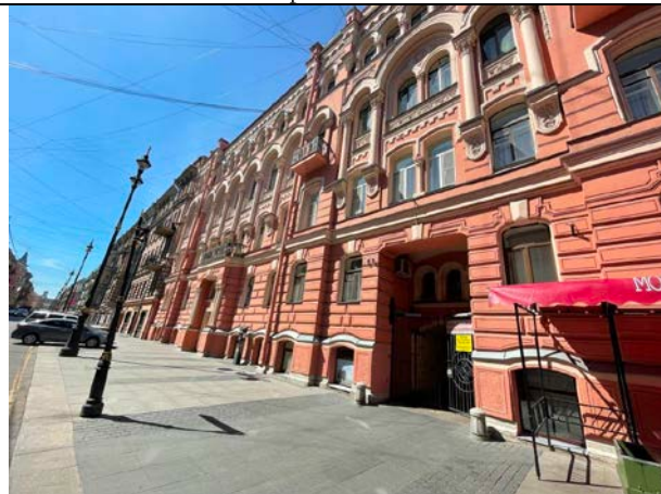
Фото 25. Вид здания расположения Объекта оценки
