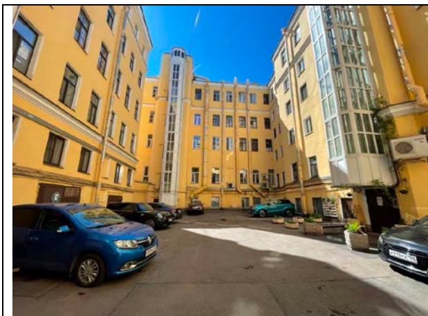
Фото 21. Внутри дворовая территория Объекта оценки
