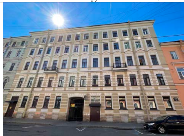
Фото 16. Вид здания расположения Объекта оценки
