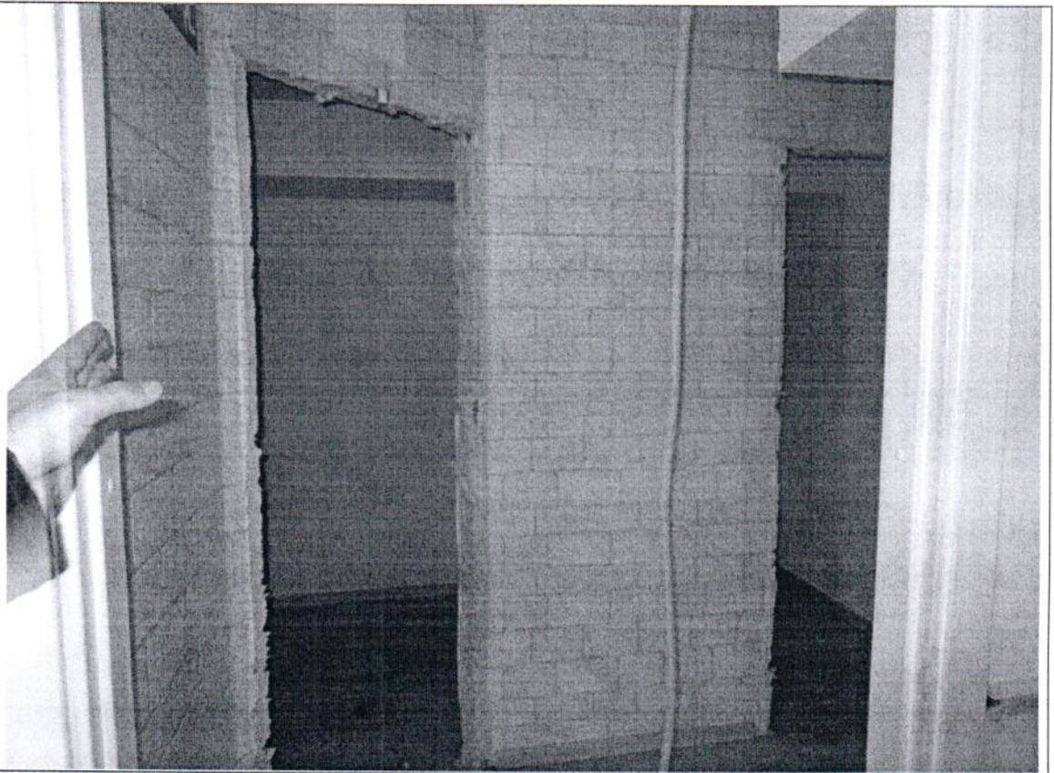
Описание: в ч.п. 2 Объекта установлены перегородки с дверными проемами
