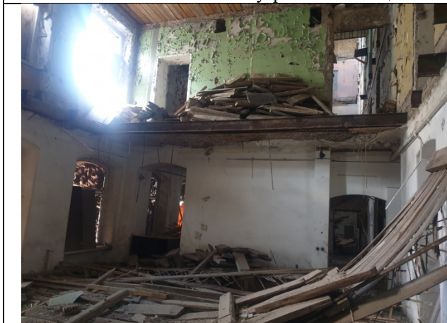
Фото № 21 – Состояние внутренних помещений
