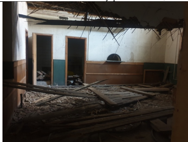
Фото № 22 – Состояние внутренних помещений
