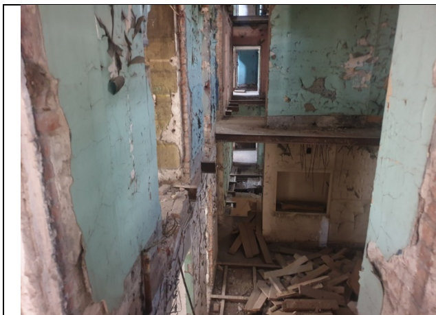
Фото № 27 – Состояние внутренних помещений
