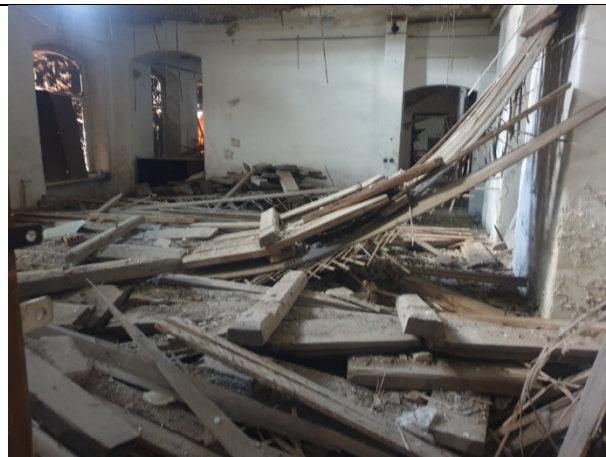
Фото № 20 – Состояние внутренних помещений
