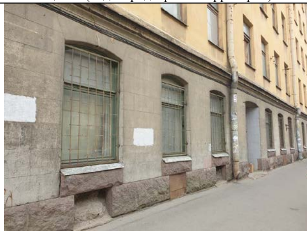
Фото № 18 – Расположение окон, входов в помещение (с улицы)
