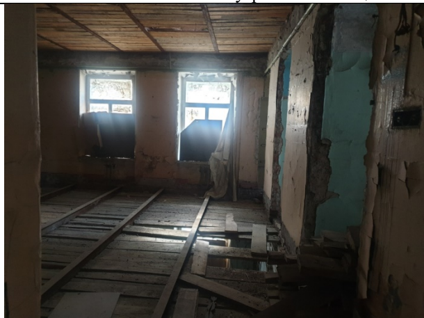
Фото № 29 – Состояние внутренних помещений
