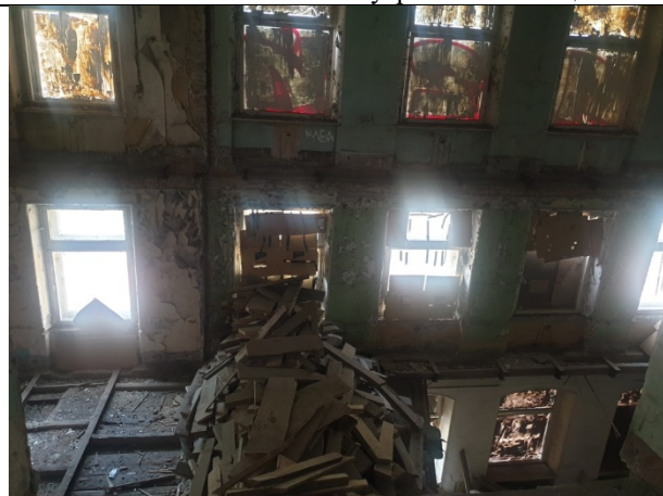
Фото № 30 – Состояние внутренних помещений
