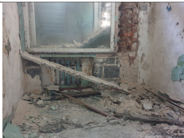
Фото № 28 – Состояние внутренних помещений
