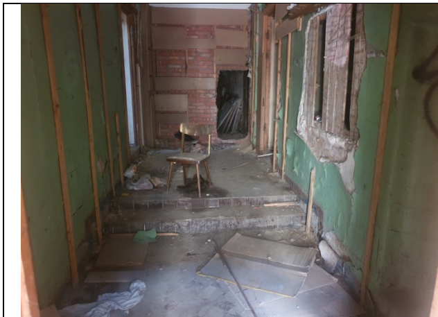
Фото № 19 – Состояние внутренних помещений
