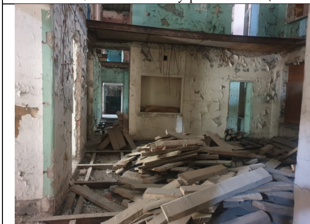
Фото № 25 – Состояние внутренних помещений
