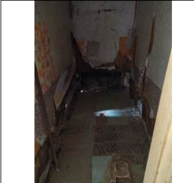
Фото 13. Типичное состояние помещения 1-Н
