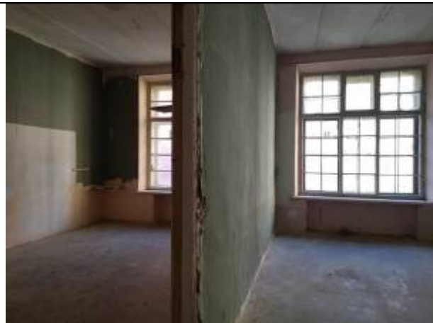
Фото 12. Типичное состояние помещения 15-Н
