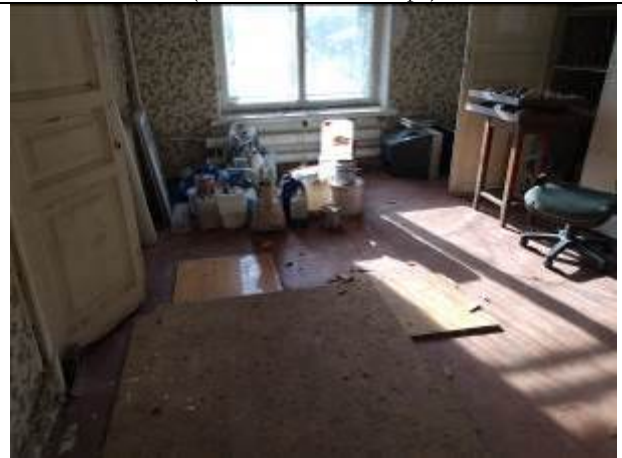
Фото 6. Типичное состояние помещения 1-Н
