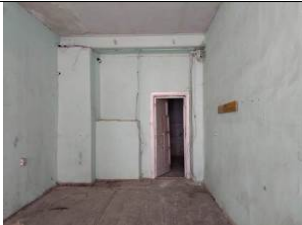
Фото 9. Типичное состояние помещения 16-Н
