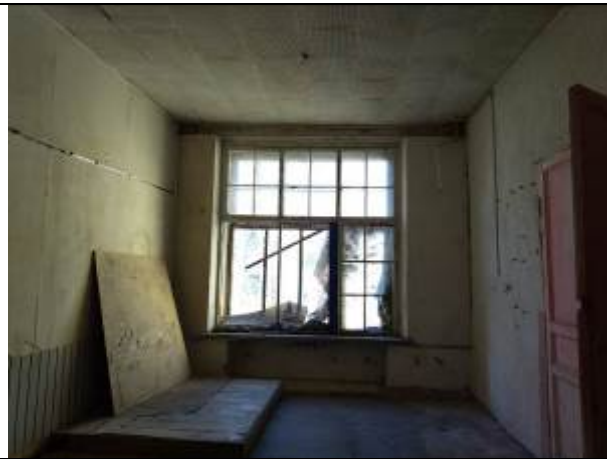
Фото 12. Типичное состояние помещения 16-Н
