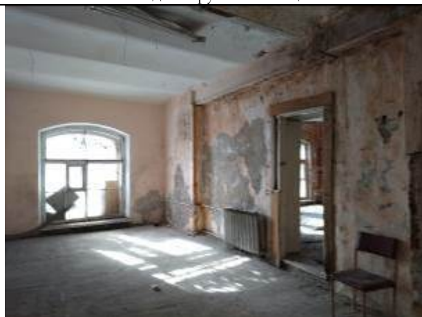
Фото 3. Типичное состояние помещения 3-Н
