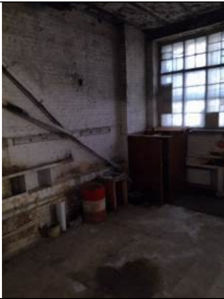
Фото 7. Типичное состояние помещения 6-Н
