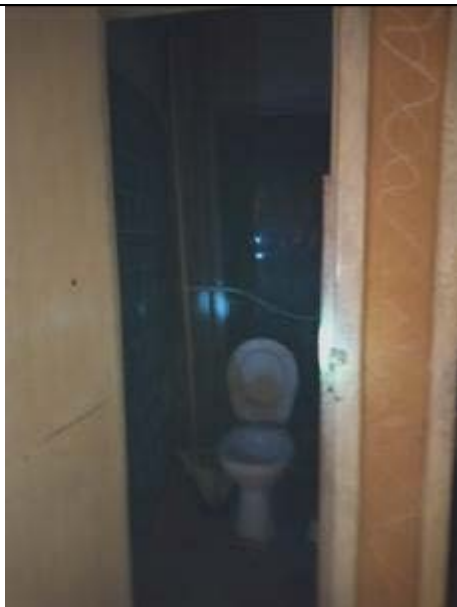
Фото 15. Типичное состояние помещения 8-Н
