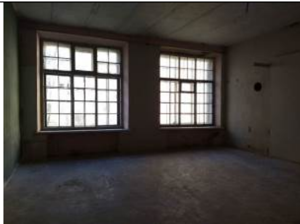
Фото 11. Типичное состояние помещения 15-Н
