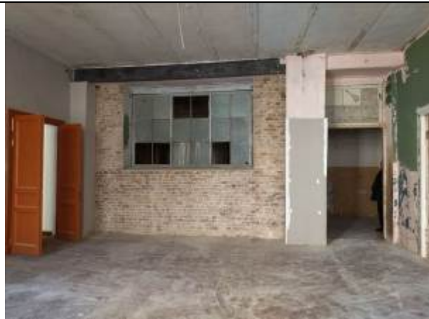
Фото 13. Типичное состояние помещения 15-Н
