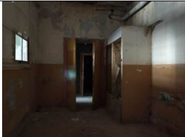
Фото 15. Типичное состояние помещения 15-Н
