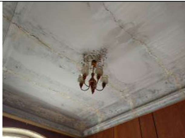
Фото 12. Типичное состояние помещения 8-Н
