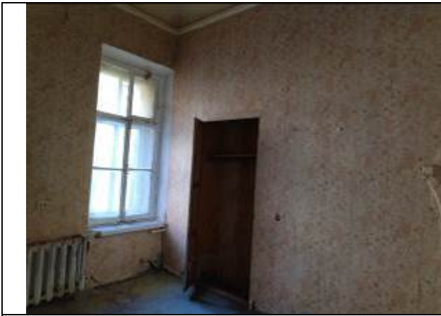
Фото 11. Типичное состояние помещения 1-Н
