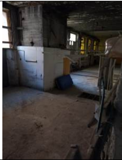
Фото 8. Типичное состояние помещения 6-Н
