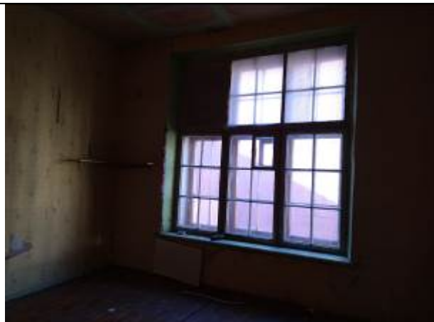
Фото 11. Типичное состояние помещения 17-Н
