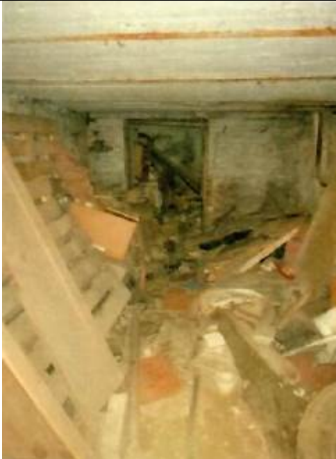
Фото 11. Типичное состояние помещения 6-Н
