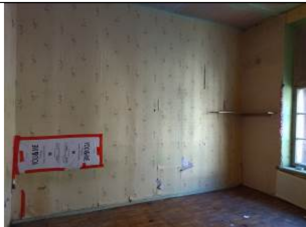
Фото 12. Типичное состояние помещения 17-Н
