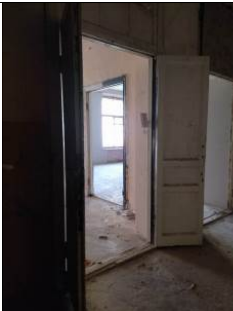
Фото 9. Типичное состояние помещения 15-Н
