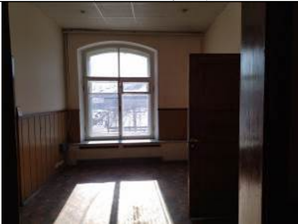
Фото 3. Типичное состояние помещения 7-Н
