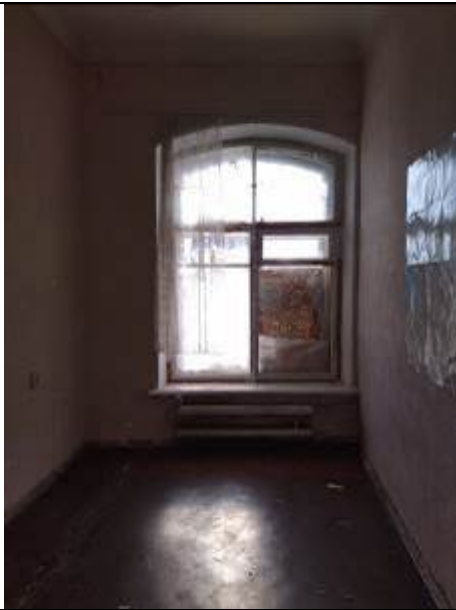
Фото 7. Типичное состояние помещения 8-Н
