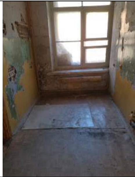
Фото 8. Типичное состояние помещения 8-Н
