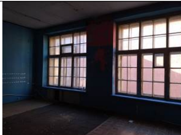
Фото 8. Типичное состояние помещения 17-Н
