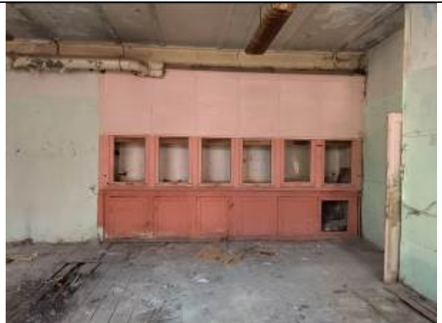
Фото 20. Типичное состояние помещения 17-Н
