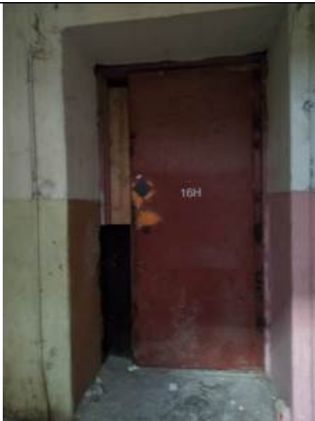
Фото 5. Входная дверь (первая) в помещение
