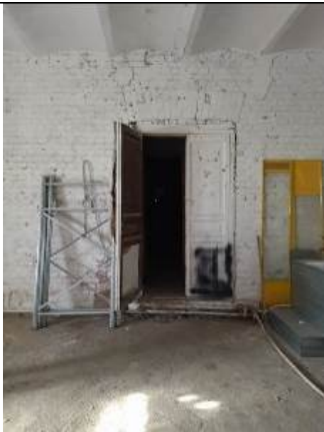
Фото 7. Типичное состояние помещения 14-Н
