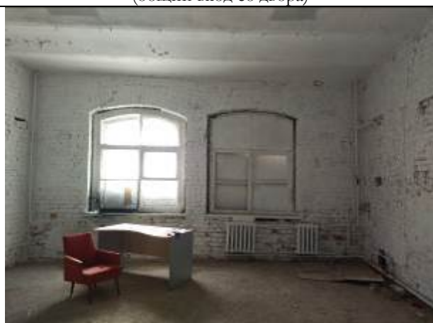
Фото 5. Типичное состояние помещения 14-Н
