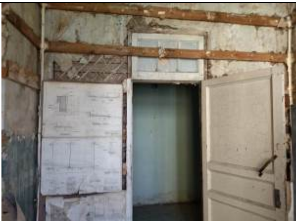
Фото 15. Типичное состояние помещения 16-Н
