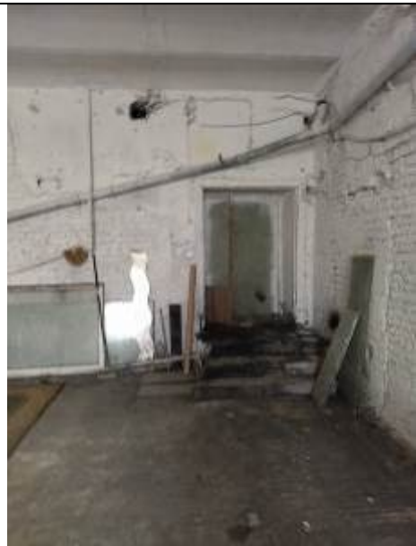
Фото 8. Типичное состояние помещения 14-Н
