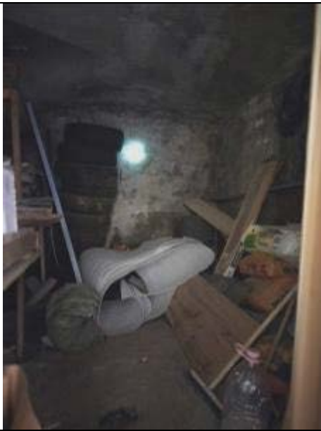
Фото 3. Типичное состояние помещения 4-Н
