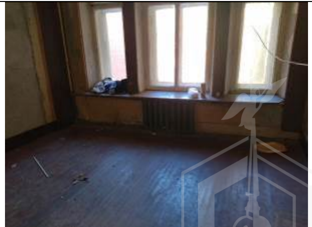
Фото 10. Типичное состояние помещения 8-Н
