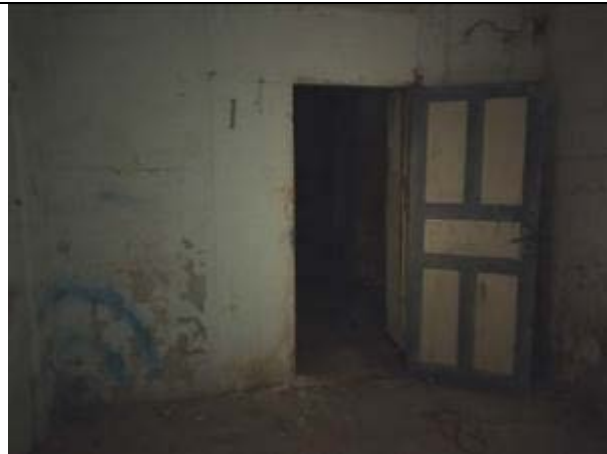
Фото 14. Типичное состояние помещения 16-Н
