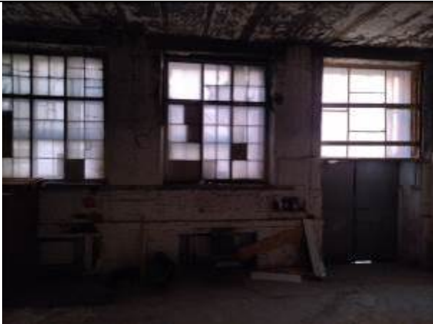
Фото 9. Типичное состояние помещения 6-Н
