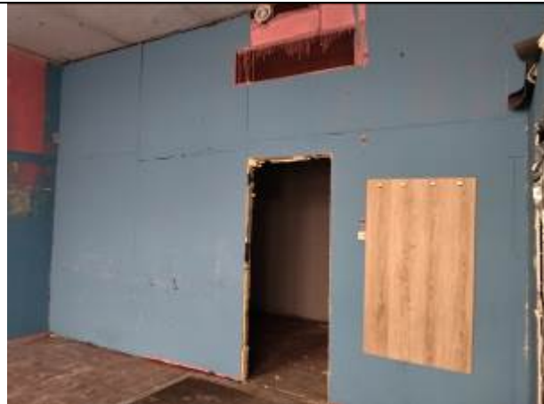
Фото 10. Типичное состояние помещения 17-Н
