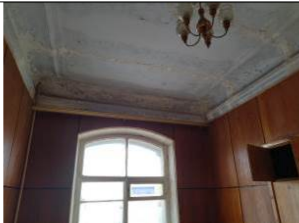
Фото 11. Типичное состояние помещения 8-Н
