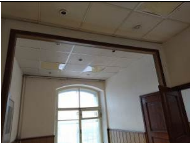
Фото 5. Типичное состояние помещения 7-Н
