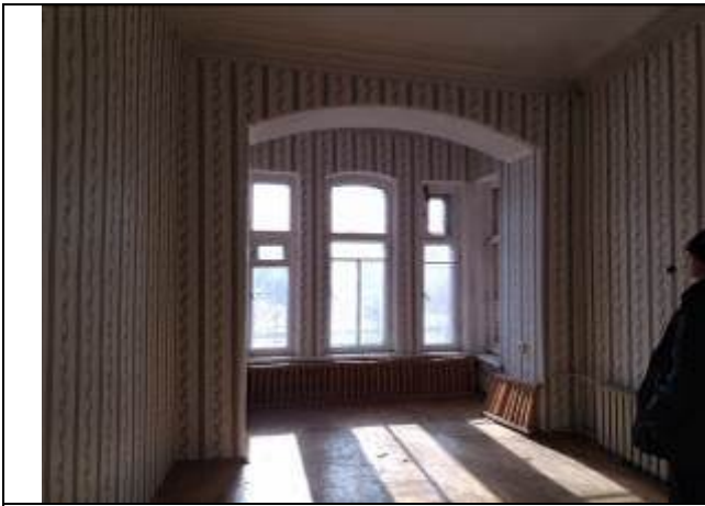
Фото 3. Типичное состояние помещения 8-Н
