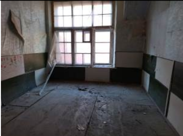
Фото 17. Типичное состояние помещения 17-Н
