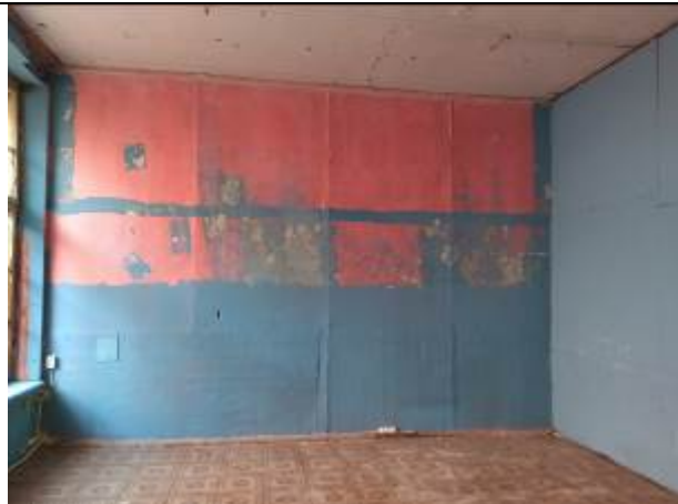
Фото 9. Типичное состояние помещения 17-Н
