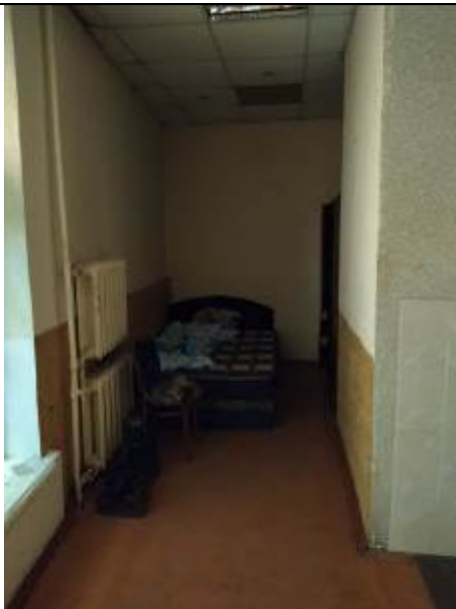
Фото 7. Типичное состояние помещения 7-Н
