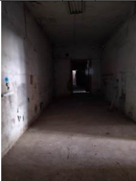
Фото 7. Типичное состояние помещения 16-Н
