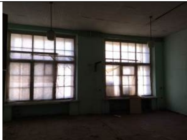
Фото 16. Типичное состояние помещения 16-Н
