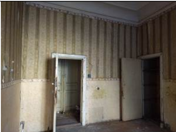
Фото 9. Типичное состояние помещения 1-Н
