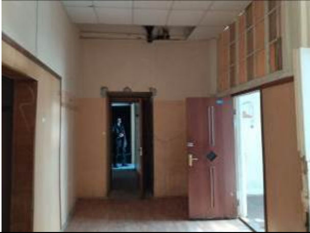
Фото 5. Типичное состояние помещения 8-Н
