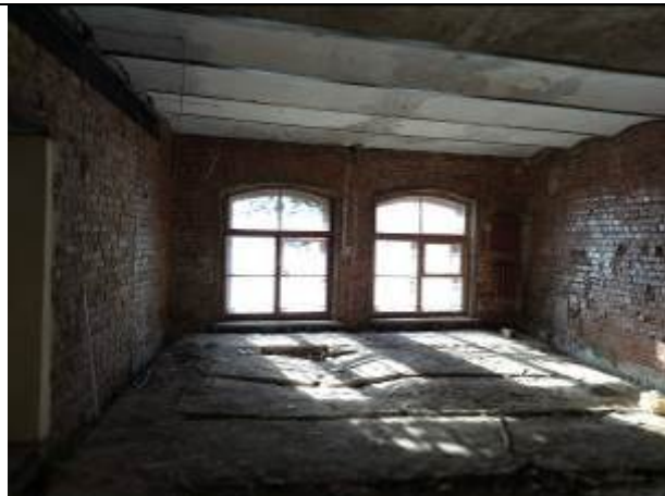
Фото 5. Типичное состояние помещения 3-Н
