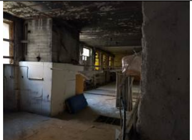
Фото 10. Типичное состояние помещения 6-Н
