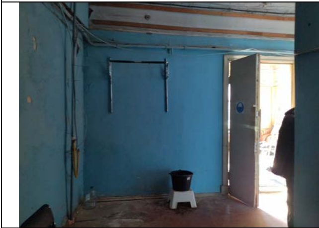
Фото 15. Типичное состояние помещения 1-Н
