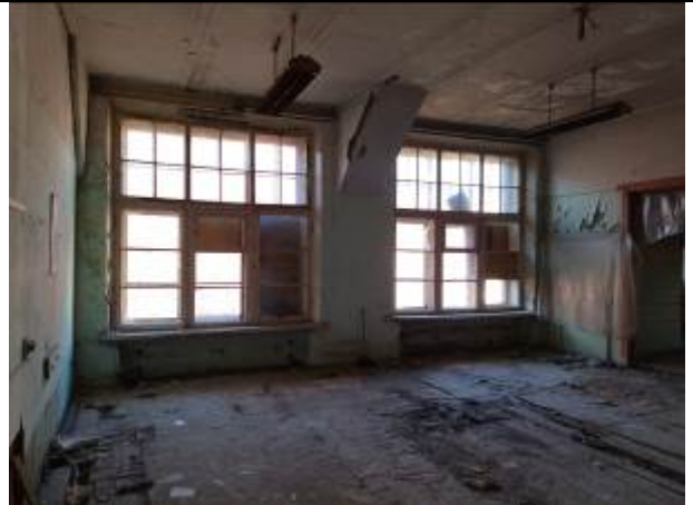
Фото 18. Типичное состояние помещения 17-Н
