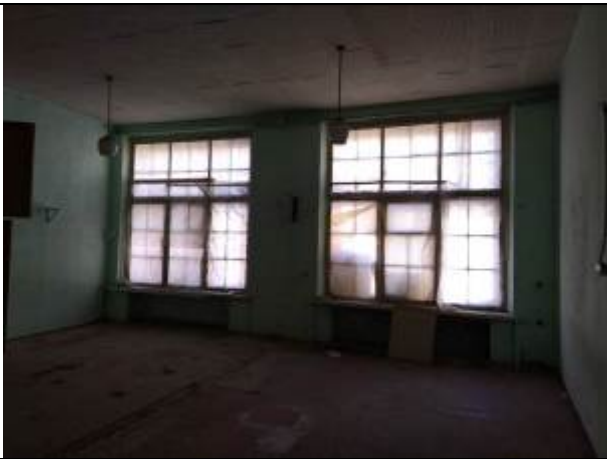
Фото 11. Типичное состояние помещения 16-Н
