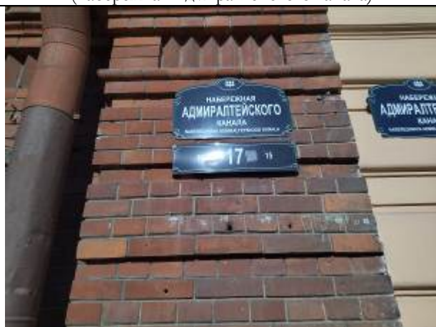
Фото 5. Адрес Объекта оценки
