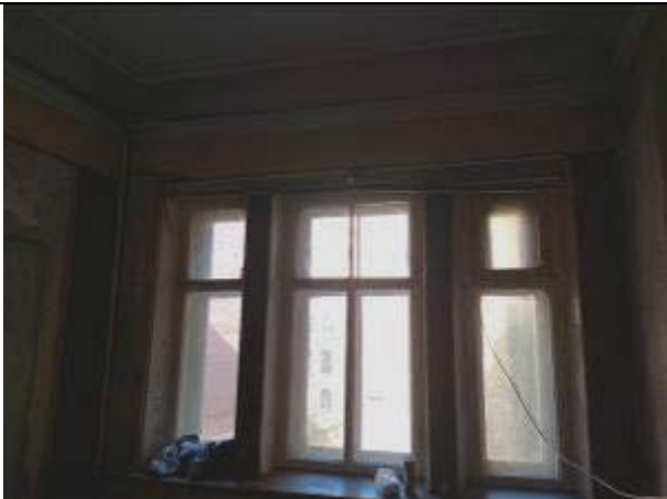
Фото 9. Типичное состояние помещения 8-Н
