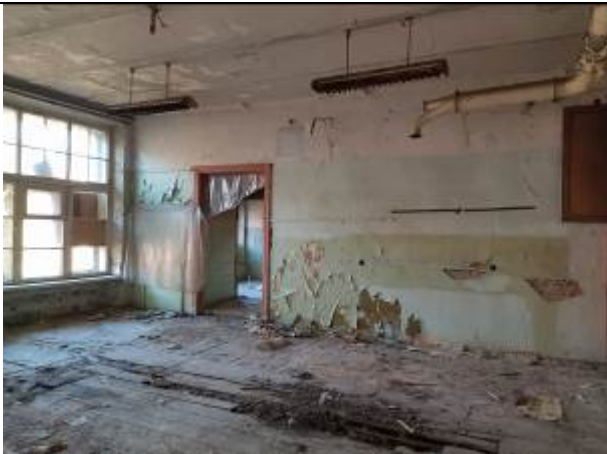
Фото 19. Типичное состояние помещения 17-Н
