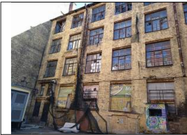
Фото 9. Дворовая территория Объекта оценки (помещения №6, №15, №16, №17 соответственно 1, 2, 3 и 4 этажи здания)
