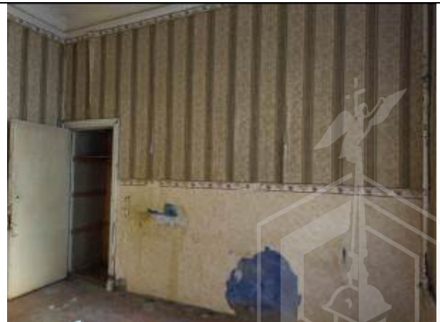
Фото 10. Типичное состояние помещения 1-Н
