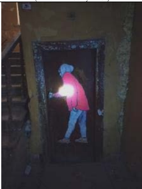
Фото 3. Типичное состояние помещения 5-Н
