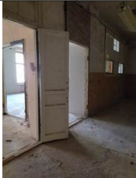
Фото 8. Типичное состояние помещения 15-Н
