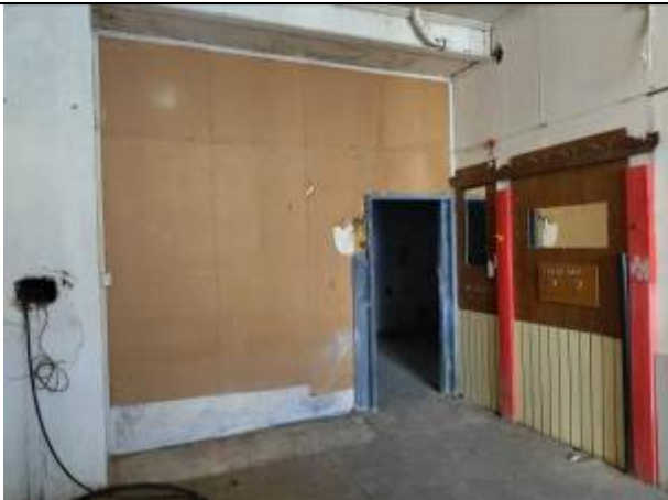
Фото 13. Типичное состояние помещения 16-Н
