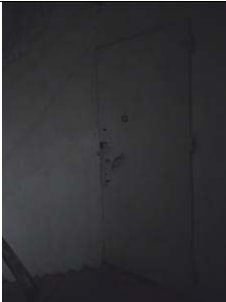
Фото 5. Входная дверь в помещение
