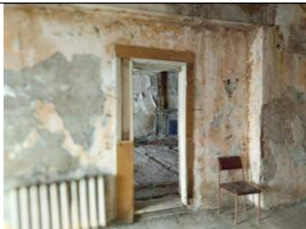
Фото 7. Типичное состояние помещения 3-Н
