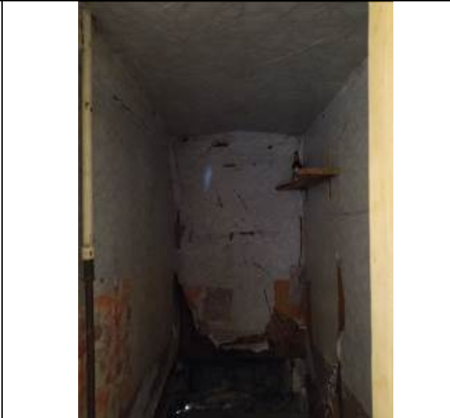
Фото 14. Типичное состояние помещения 1-Н
