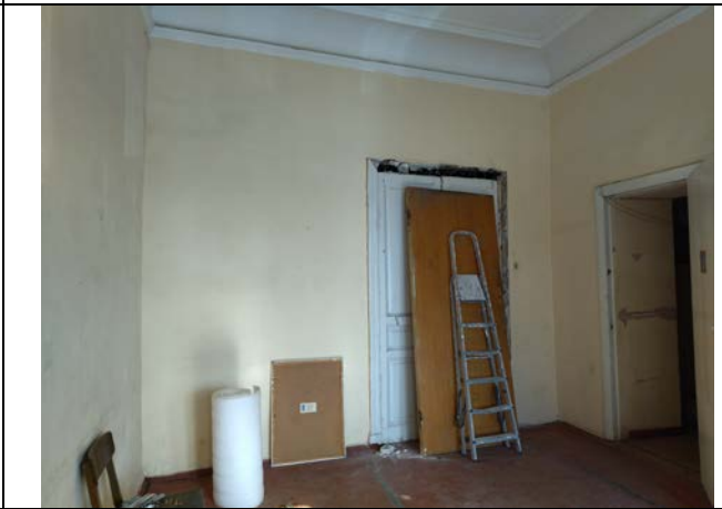
Фото 16. Типичное состояние помещения 1-Н
