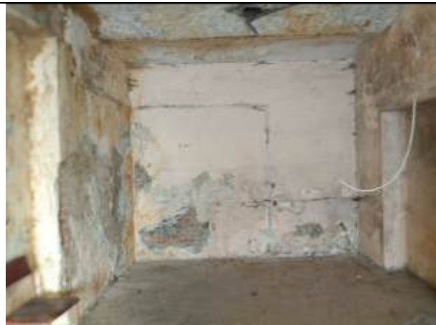
Фото 6. Типичное состояние помещения 3-Н
