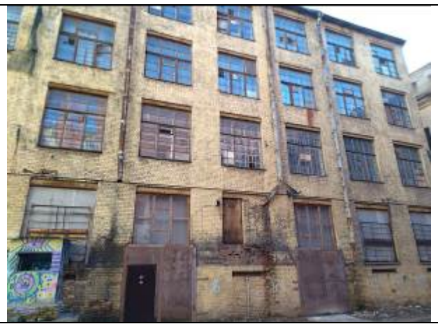
Фото 10. Дворовая территория Объекта оценки (помещения №6, №15, №16, №17 соответственно 1, 2, 3 и 4 этажи здания)
