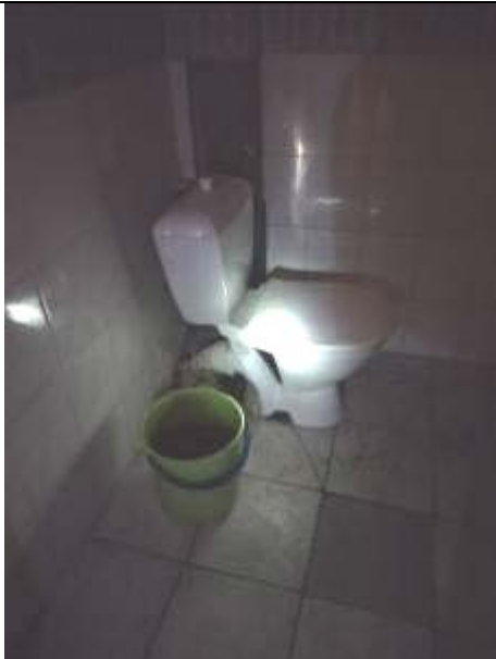
Фото 9. Типичное состояние помещения 7-Н
