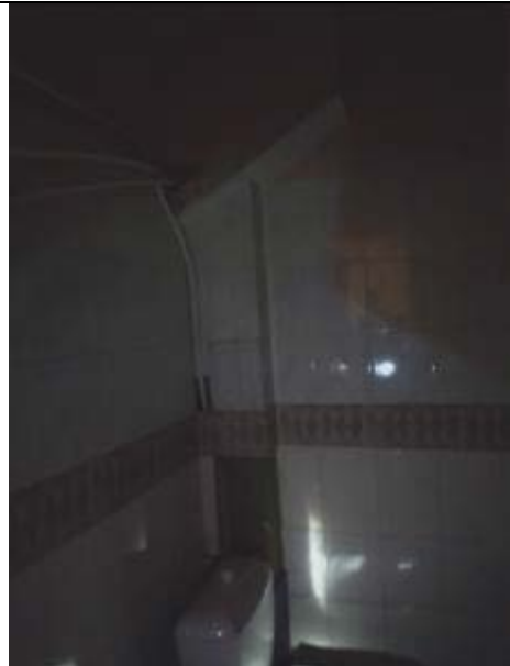
Фото 10. Типичное состояние помещения 7-Н
