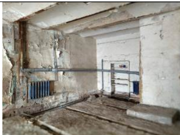
Фото 8. Типичное состояние помещения 3-Н
