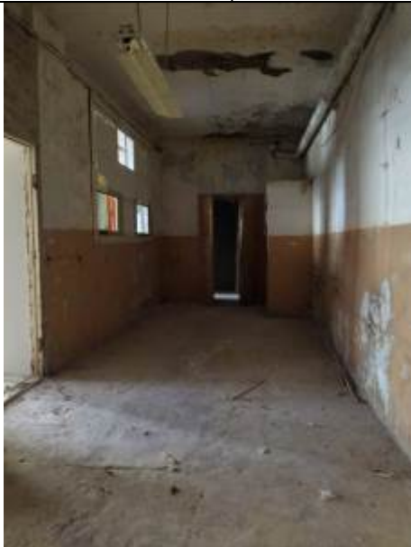
Фото 7. Типичное состояние помещения 15-Н
