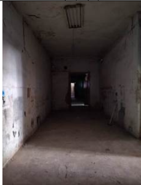
Фото 8. Типичное состояние помещения 16-Н
