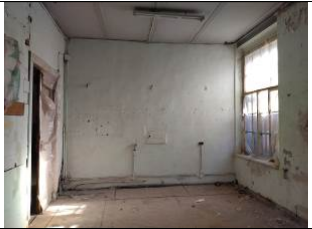
Фото 16. Типичное состояние помещения 17-Н
