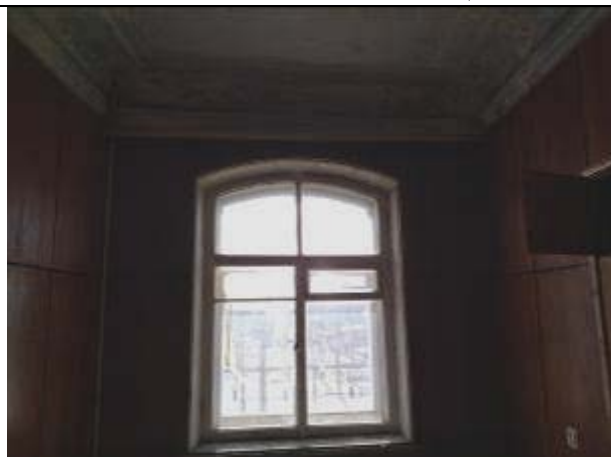
Фото 13. Типичное состояние помещения 8-Н
