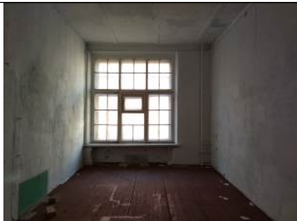
Фото 13. Типичное состояние помещения 17-Н
