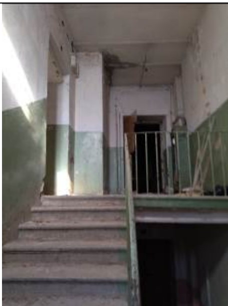
Фото 5. Входная дверь в помещение
