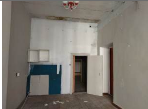
Фото 16. Типичное состояние помещения 15-Н
