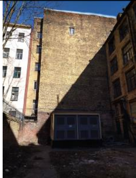
Фото 12. Дворовая территория здания расположения Объекта оценки
