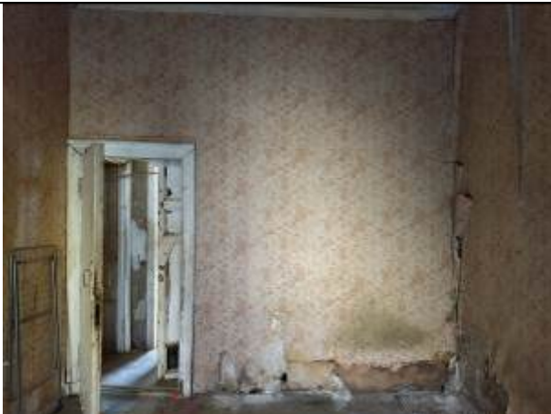
Фото 7. Типичное состояние помещения 1-Н
