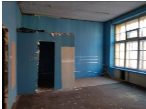
Фото 7. Типичное состояние помещения 17-Н
