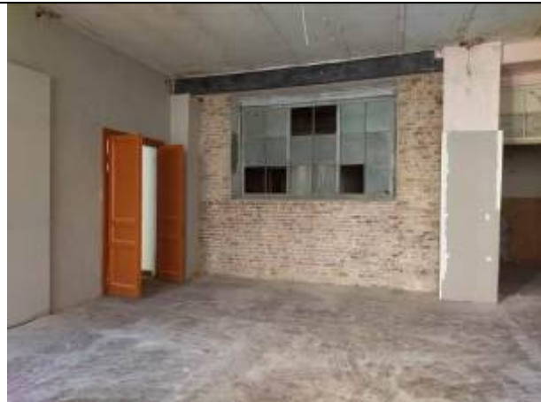
Фото 14. Типичное состояние помещения 15-Н
