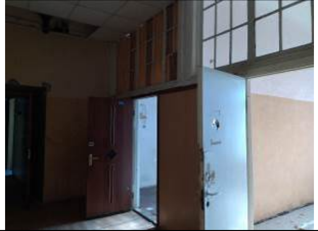
Фото 6. Типичное состояние помещения 8-Н
