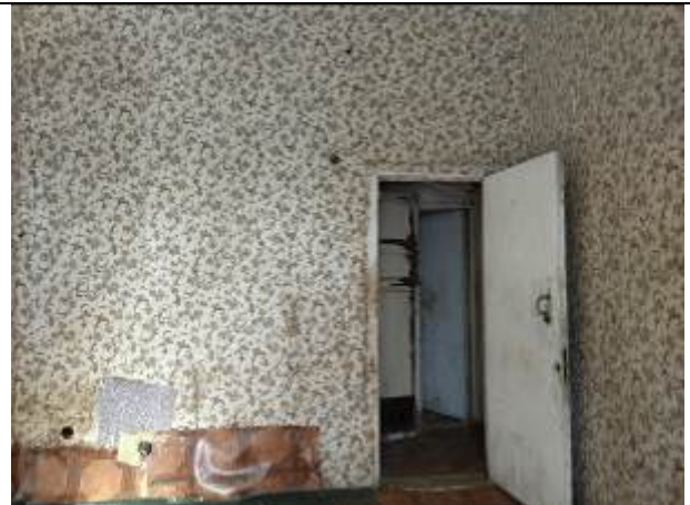
Фото 8. Типичное состояние помещения 1-Н
