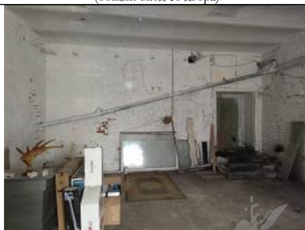
Фото 6. Типичное состояние помещения 14-Н
