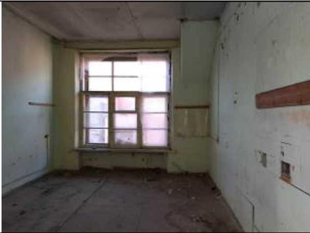
Фото 15. Типичное состояние помещения 17-Н
