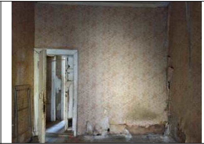
Фото 12. Типичное состояние помещения 1-Н
